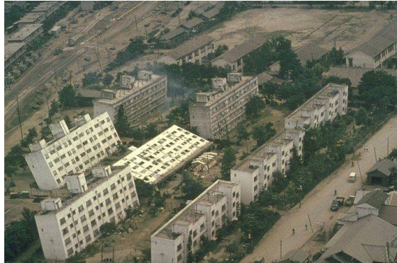
Şekil 1.1 Sıvılaşma nedeniyle oluşan taşıma gücü kaybının sonuçlarına bir örnek (USGS)
