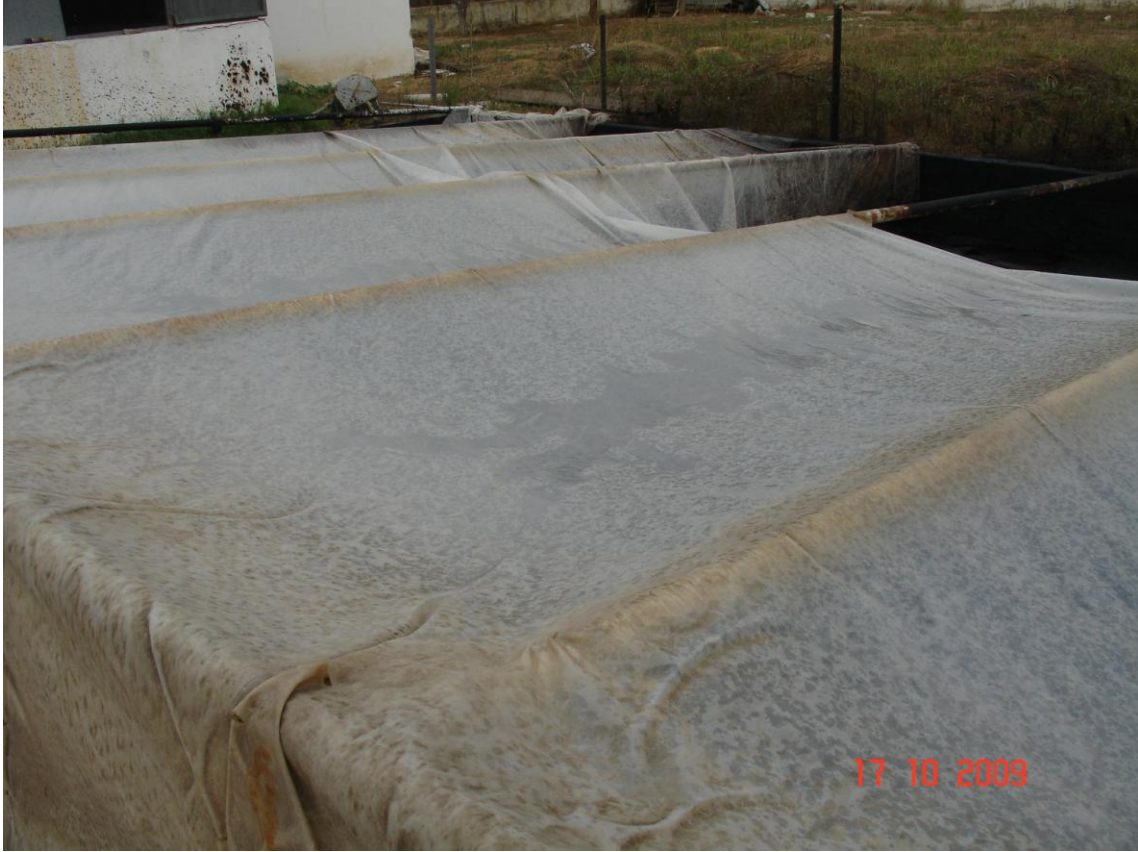
Şekil 2.3 Zeytin karasularının havuzlarda depolanarak buharlaştırılması
