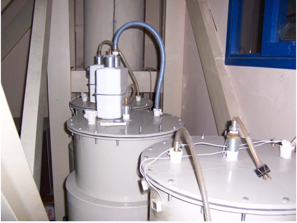
Reaktörlerin işletme aşamasına ait görünüş
