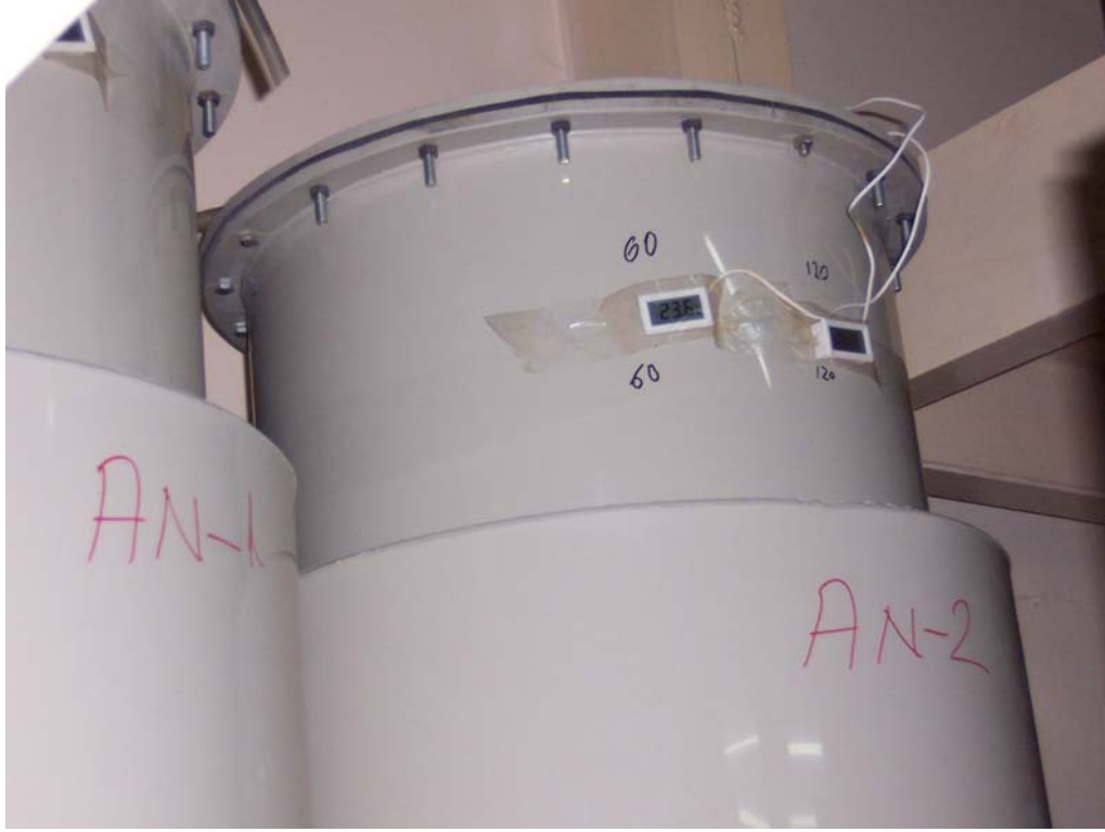
Anaerobik reaktörlerin işletme aşamasına ait görünüş
