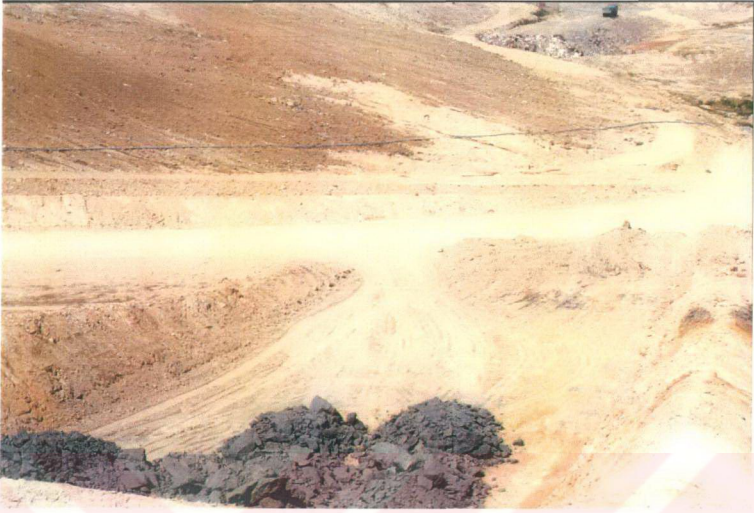
Test hücrelerinin tabanındaki kil tabakasının hazırlanması
