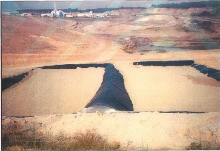
Test hücrelerindeki drenaj tabakasının teşkili
