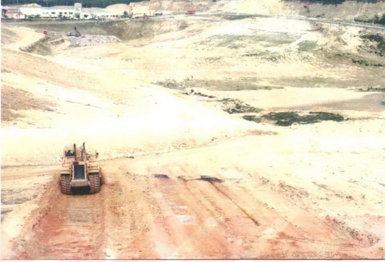
Saha tabanının hazırlanması
