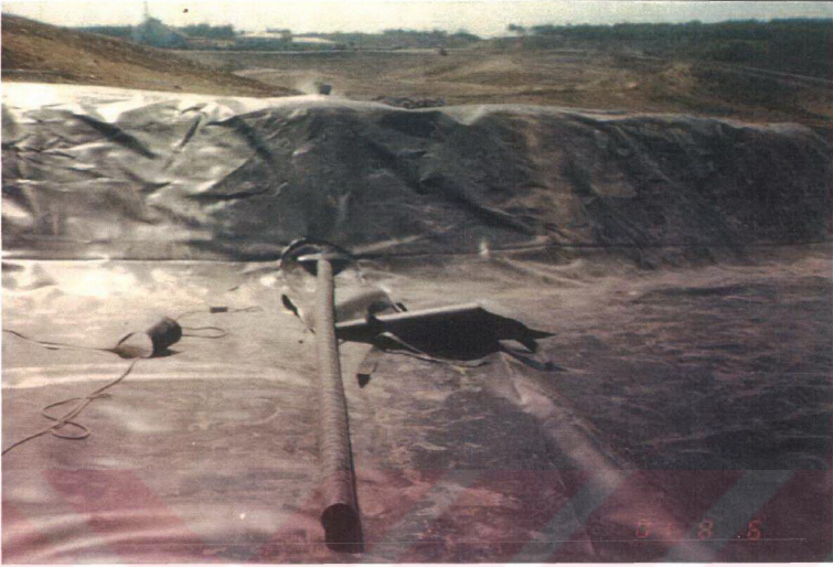
Test hücrelerindeki drenaj tabakasının teşkili
