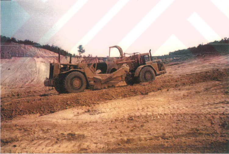
Saha tabanının hazırlanması
