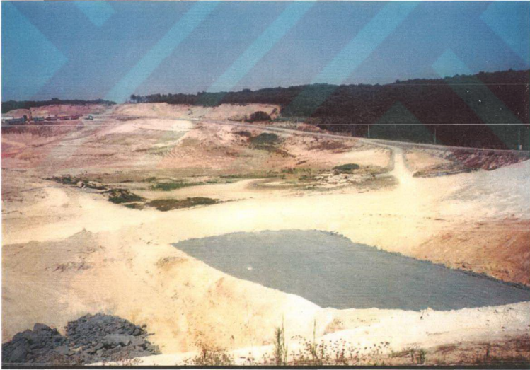
Test hücrelerinin tabanındaki kil tabakasının hazırlanması
