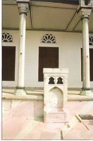
Resim 3.4.18.12 Gözdeler Taşlığı'nda sağlamlaştırma ve temizleme tekniği kullanılarak restorasyonu yapılan çeşme (Ü. Karahasan arşivi)
