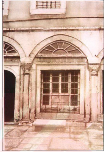
Resim 3.4.13.6 Cariyeler Dairesi 2. oda penceresi onarım sonrası görünüşü (TSDA. TSM. No: 55/49-a )
