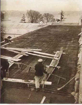
Resim 3.2.4.11 Fatih Köşkü revak tavanlarının 1943'te betonarmeye dönüştürülmesi (TSDA. TSM. No: 55/37)
