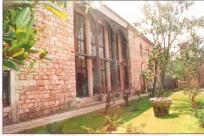
Resim 3.1.3.16 Tablakarlar Koğuşu Tahsin Öz restorasyonu; ahşap revak kemer ve sütunları özgün şekli ile korunmuş, arkada yapılan camlı bölme ile revak kapalı mekan şekline sokulmuştur (Ü. Karahasan arşivi).
