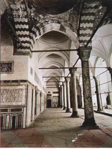
Resim 3.2.7.12 Harem Dairesi'ni Hırka-i Saadet Dairesine bağlayan revakların onarım sonrası görünüşü (TSDA. TSM. No:55/80, Topkapı Sarayı 1970-1971 yılları onarımı)
