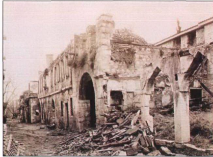
Resim 3.1.3.27 1943 restorasyonları öncesi Has Mutfak Kapısı ve Aşçı koğuşların görünüşü; sağ taraftaki koğuşların bir kısmı yıkılmış, sadece revakları ayakta kalabilmiştir. Kapı ve sol taraftaki koğuşların örtü sistemi çökmüştür (TSDA. TSM. No: 55/36).
