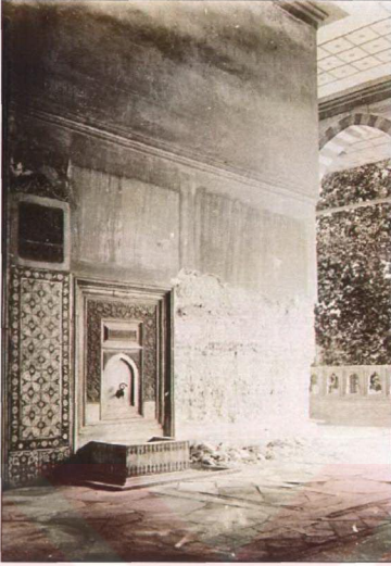
Resim 3.2.10.9 Arz Odası'nın Bab-üs Saade cephesinde Taşin Öz zamanında yapılan raspa çalışmaları; sıva altında taş-tuğla alması ve duvar örgüsü gözükmektedir (TSDA. TSM. No: 55/35).
