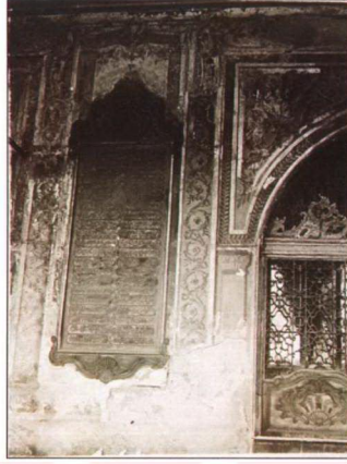
Resim 3.1.5.24 Kubbealtı revak duvarlarında raspa çalışması (TSDA. TSM. No: 55/37)
