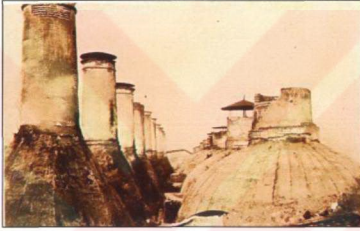
Resim 3.1.3.1 Mutfak baca ve kubbelerin 1943 restorasyonu öncesi görünüşü (TSDA. TSM. 55/36)
