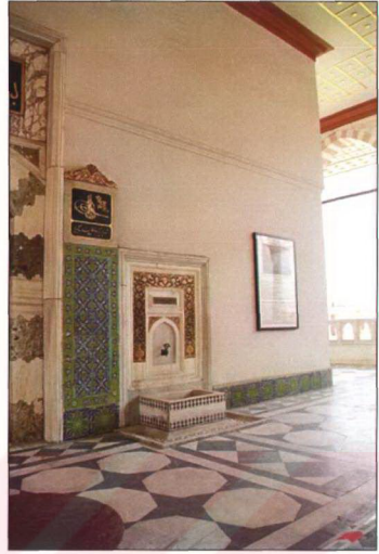
Resim 3.2.10.10 Arz Odası'nın bugünkü görünüşü; çeşme üstündeki peyzaj ve diğer kalem işi bezemeler kaldırılmış ve cephe sıvanmıştır. (Ü. Karahasan arşivi)
