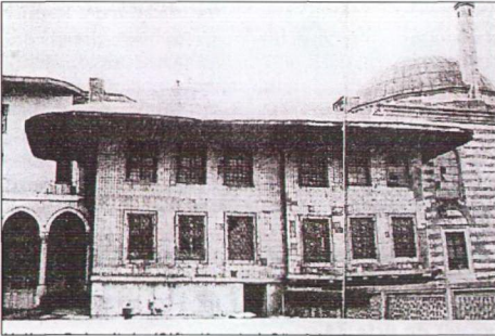
Resim 3.4.4.10 Velihaht Dairesi'nin restorasyon sonrası görünüşü (Anhegger, 1986)
