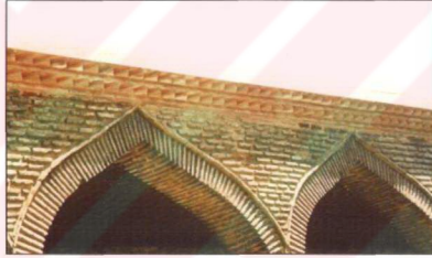
Resim 3.1.2.23 İkinci Avlu Revakları'nın Marmara Denizi cephesinde yeni yapılan kirpi saçaklar (Ü. Karahasan arşivi)
