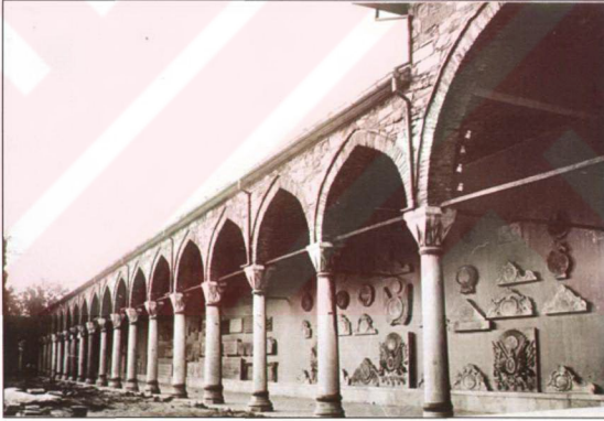
Resim 3.1.2.12 İkinci Avlu Revakları Haliç cephесinin 1940 1944 restorasyonları sonrası görünüş; revak alınları derz onarımı yapılarak sıvanmadan bırakılmıştır. Giriş cephесinden farklı olarak kirpi saçak yapılmamıştır (TSDA. TSM. No: 55/37)
