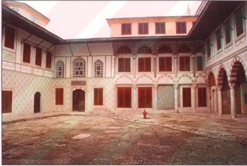
Resim 3.4.1.15 Valide Taşlığı'nın Ocaklı Sofa cephesi'nin bugünkü görünüşü (Ü. Karahasan arşivi)
