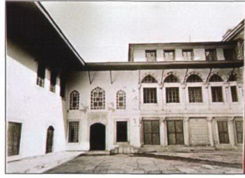
Resim 3.4.1.13 Valide Taşlığı Ocaklı Sofa cephesi saçak yapıldıktan sonra görünüşü (TSDA. TSM. No: 55/80)
