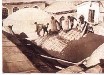
Resim 3.4.3.2 Ocaklı Sofa örtü sisteminin betonarme yapım tekniğiyle yeniden yapılışı (TSDA. TSM. No: 55/42)
