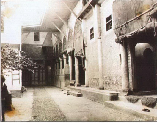
Resim 3.4.15.5 Karaağalar Taşlığı'nın Cumhuriyet dönemi onarımları öncesi görünüşü; Revaklar geç dönemde yapılan gecekondu nitelikli eklerle kapatılmıştır. Daha sonra onarımlarda kaldırılan ahşap fruşlara taşıtılan geniş saçaklar görülmektedir (TSDA. TSM. No: 55/40).
