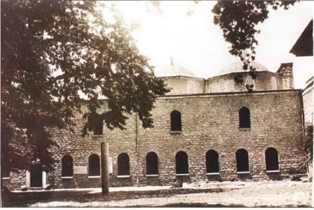
Resim 3.1.6.2 Dış Hazine'nin 1943 restorasyonu sonrası görünüşü (TSDA. TSM. No: 55/37 )
