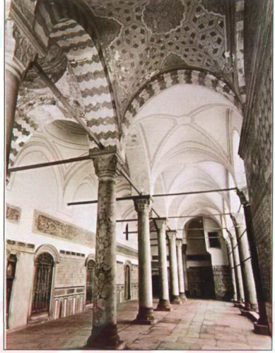
Resim 3.2.7.13 Harem Dairesi'ni Hırka-i Saadet Dairesine bağlayan revakların onarım sonrası görünüşü (TSDA. TSM. No:55/80, Topkapı Sarayı 1970-1971 yılları onarımı)
