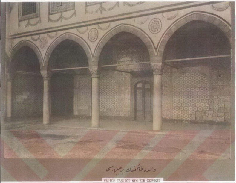
Resim 3.4.1.10 Valide Taşlığı revakları Cumhuriyet dönemi restorasyonları öncesi görünüşü; Revakların bugünkü görünüşüyle karşılaştırıldığında, en soldaki kapının yanında devam eden duvarın, revakları bu bölümünü kapalı bir mekan şekline soktuğu anlaşılmaktadır (TSDA. TSM. No: 55/40).
