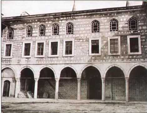
Resim 3.4.1.7 Valide Taşlğı Altın Yol cephesi Tahsin Öz restorasyonları ikinci aşama
