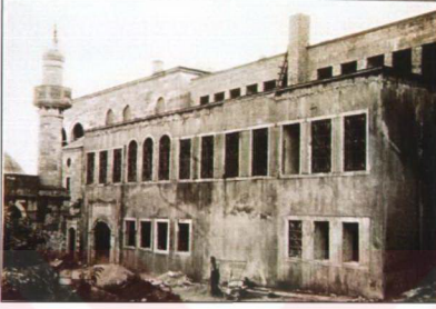
Resim 3.2.5.2 Hazine Kethüdalığı Dairesi arka cephe onarım öncesi görünüşü (TSDA. TSM. No: 55/59-c)
