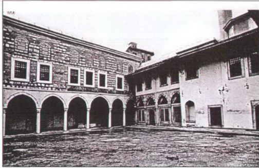
Resim 3.4.1.4 Valide Taşlığı'nın Karaağalar ve Hamam cephesisinin 1943 restorasyonları sonrası görünüşü; Karaağalar cephesi kagir duvar yüzeylerinde sağlamlaştırma onarımları yapılmıştır. Hamam cephesinde de çini kaplamalar ve çini taklidi kalem işi bezemeler kaldırılmış duvar yüzeyleri bu kısımlarda düz sıvalı bırakılmıştır (Anhegger, 1986).
