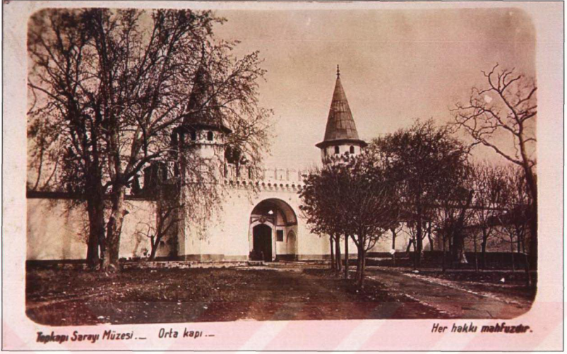
Resim 3.1.1.4 Tahsin Öz restorasyonlarından önce Bab-üs Selam'ın Birinci Avlu'dan görüntüsü; kapının her iki tarafındaki kulelerin kurşun külahları pencere kavislerini örtecek şekilde aşağıdadır ve kule beden duvarında küçük saçakları vardır. Kapı'nın girişindeki tonozu belirleyen bugün mevcut olmayan kalem işleri göze çarpmaktadır (TSDA. TSM. No: 55/37).
