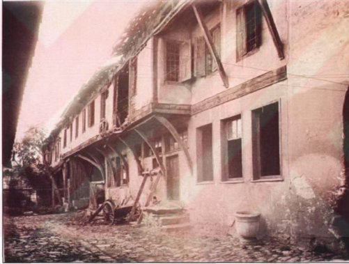
Resim 3.1.3.34 Saray Mutfakları'nın 1943 restorasyonları öncesi tamamen yıkılan Vekilharç Dairesi (TDMA. TSM. No: 55/36)
