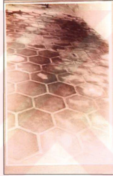
Resim 3.1.6.6 Dış Hazine'de 1967-1968 yılı restorasyonu sonrası yapılan altıgen tuğla yer kaplamalarının görünüşü (TSDA. TSM. No: 55/48-a; No: 55/48-b))
