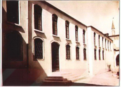
Resim 3.2.1.10 Akağalar Koğuşları dış cephe onarımı tamamlandıktan sonra görünüşü (TSDA.TSM.No:55/50)
