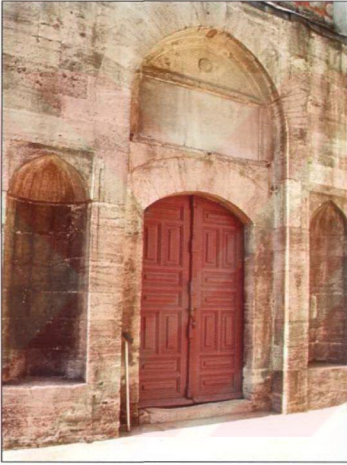
Resim 3.1.7.9 Has Ahırlar'a 1996 restorasyonlarında konulan yeni tablalı giriş kapısı (Ü. Karahasan arşivi)
