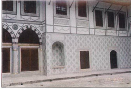
Resim 3.4.1.3 Valide Taşlığı'nın Hamam cephesisinin bugünkü görünüşü
