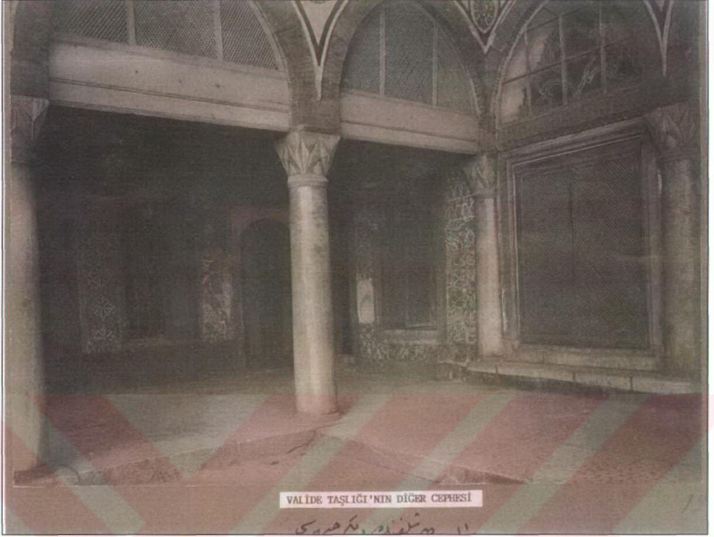
Resim 3.4.1.8 Valide Taşlığı Karaağalar cephесinin Cumhuriyet dönemi restorasyonları öncesi görünüşü; Kemer gergi demirlerinin üst kısmının kapatılmış olması, bu kısımlarda ilave bölmeler olduğunu göstermektedir. Restorasyon sırasında bu ekler kaldırılmıştır. Sağda revak kemer içinin dışlık olarak camla içte ise revzen pencereyle kapatıldığı görülmektedir (TSDA. TSM. No: 55/40).
