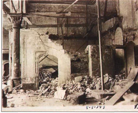
Resim 3.1.5.19 Kubbealtı revaklarında Cumhuriyetten önce yapılan ek kısmın 1943 restorasyonlarında kaldırılışı görülmektedir. Molozlar arasında Kubbealtı'nda bugün sergilenmekte olan, padişahın arkasından konuşmaları dinlediği kafes görülmektedir (TSDA. TSM. No: 55/37).
