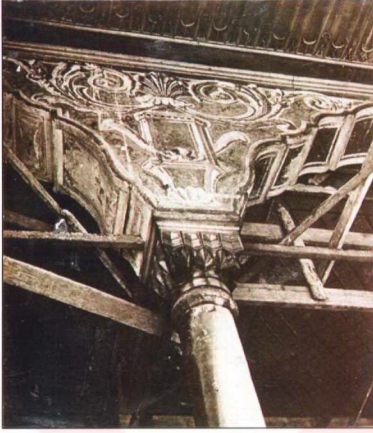
Resim 3.1.1.16 Bab-üs Selam revak kemer alınlığında bulunan ve 1943 restorasyonlarında kaldırılan barok kalem işleri (TSDA. TSM. No: 55/37)
