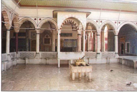
Resim 3.3.1.4 Havuzlu Taşlık'ta revakları kapatan geç dönem eklerin kaldırılmasından sonra görünüş (Ü. Karahasan arşivi)
