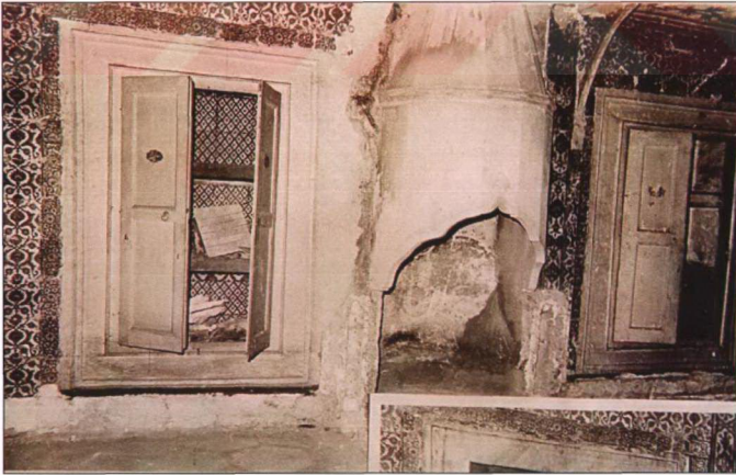
Resim 3.4.13.7 Cariyeler Dairesi 2.oda restorasyon öncesi görünüşü (TSDA.TSM. No: 55/49-a)
