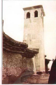
Resim 3.2.7.9 Destimal Odası Bacası onarım sonrası (TSDA 55/49-A)
