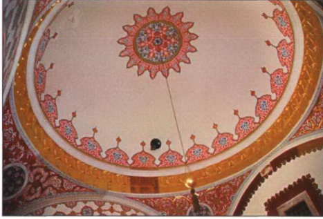
Resim 3.1.5.2 Kubbealtı'nın kubbesinde rokoko bezemeler altından çıkartılarak onarımları yapılan XVI. yüzyıl süslemeleri (Ü. Karahasan arşivi)
