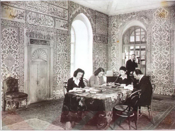
Resim 3.2.8.2 Ağa Camisi'nin kütüphane olarak düzenlenmesinden sonra görünüşü (TSDA. TSM. No: 55/35)
