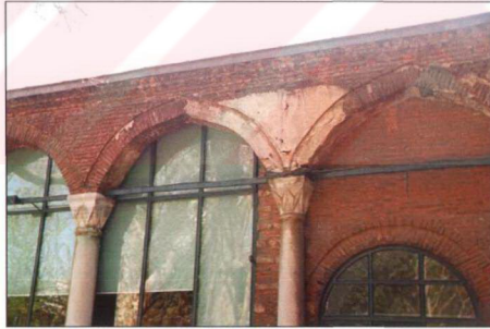
Resim 3.1.2.21 Bab-üs Selam'ın sol tarafında bulunan İkinci Avlu Revakları'nın kemer alınlıklarında bulunan eski sıva örnekleri (Ü. Karahasan arşivi)
