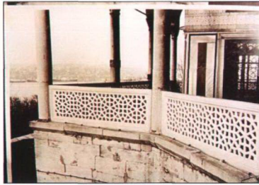
Resim 3.3.2.5 Bağdat Köşkü korkuluk onarımları sonrası görünüşü (TSDA. TSM. No: 55/49/a)
