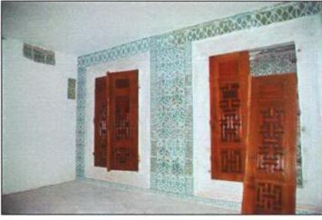
Resim 3.4.16.7 Cüceler Dairesi'nde onarımı yapılan Dolap kapakları ve duvar süslemeleri (Ü. Karahasan arşivi)
