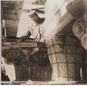
Resim 3.1.4.8 Adalet Kulesi sütun başlıklarının onarımı (TSDA. TSM. No: 55/63)
