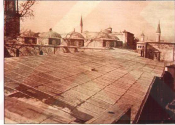
Resim 3.2.1.8 Akağalar Koğuşları çatısına kurşun serilmesi (TSDA. TSM. No: 55/50 )
