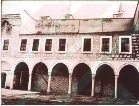
Resim 3.4.1.6 Valide Taşlğı'nın Altın Yol cephesi Tahsin Öz restorasyonu birinci aşama
