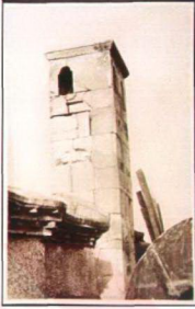
Resim 3.2.7.8 Destimal Odası bacası onarım öncesi (TSDA 55/49-A)
