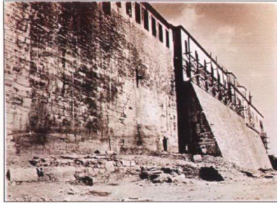
Resim 3.1.3.38 Saray Mutfakları'nın Marmara Denizi cephesinde sağlamlaştırma onarımları (TDMA. TSM. No: 55/36)
