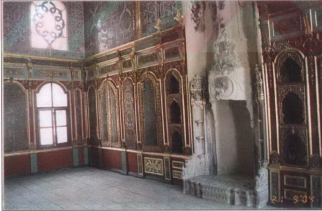
Resim 3.4.17.7 Şehzadeler Mektebi'nin onarım sonrası görünüşü; Ocak eski resimlere göre yeniden yapılmıştır. (Ü. Karahasan arşivi)
