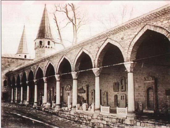
Resim 3.1.2.2 Bab-üs Selam'ın sağ tarafındaki revakların 1943 restorasyonları sonrası görünüşü; bütünleme tekniği kullanılarak örtü sistemi tamamlanmıştır (TSDA. TSM. No: 55/37).
