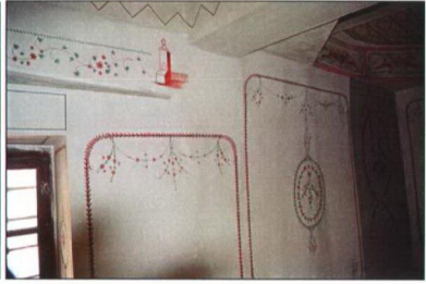
Resim 3.4.16.2 Cüceler Dairesi'nde üst katta onarımı yapılan kalem işleri (Ü. Karahasan arşivi)
