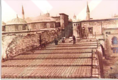
Resim 3.2.1.7 Akağalar Koğuşları tavan döşeme restorasyonu sırasında betonarme tekniğinin uygulanışı (TSDA. TSM. No: 55/50)
