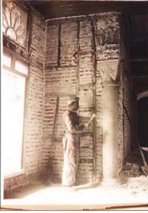
Resim 3.4.18.7 I.Hamid Odası koridorunda duvar sağlamlaştırma anarımı (TSDA. TSA. No: 55/53)
