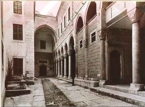
Resim 3.4.15.7 Karaağalar Taşlığı'nın temizleme-ayıklama tekniği ile yapılan restorasyonlardan sonra görünüşü; Revakları kapatan ekler ve ahşap saçaklar kaldırılmıştır. Duvarlar yüzeylerindeki sıvalar raspa yapılarak alınmış taş tuğla almasıık duvar örgüsü ortaya çıkartılmıştır. Ancak revakların iki açıklığını kapatan üzeri çini kapalı muhdes duvarların korunduğunu görüyoruz (TSDA. TSM. No: 55/80).
