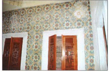
Resim 3.4.16.8 Cüceler Dairesi'nde onarım yapılan dolap kapakları ve duvar süslemeleri (Ü. Karahasan arşivi)
