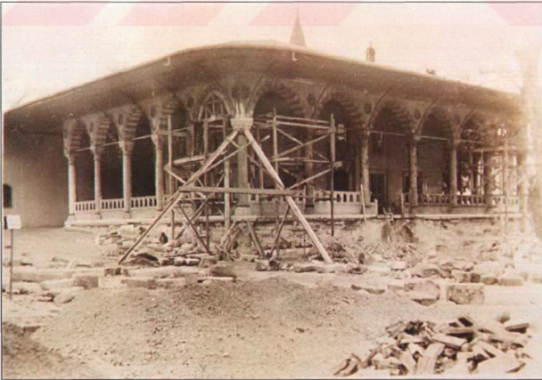
Resim 3.2.10.3 1943 restorasyonlarında Arz Odası revaklarında askıya alınarak bir sütunun değiştirilmesi (TSDA. TSM. No: 55/37)
