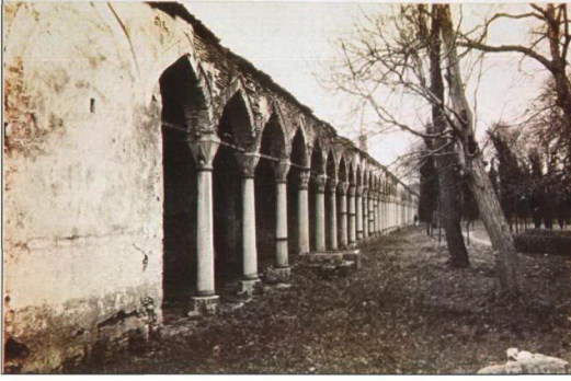
Resim 3.1.2.4 İkinci Avlu Revakları Marmara Denizi cephesinin 1943 restorasyonları öncesi görünüşü; sütunların arası duvarla örülerek kapalı bir mekan elde edilmiştir (TSDA. TSM. No: 55/36).
