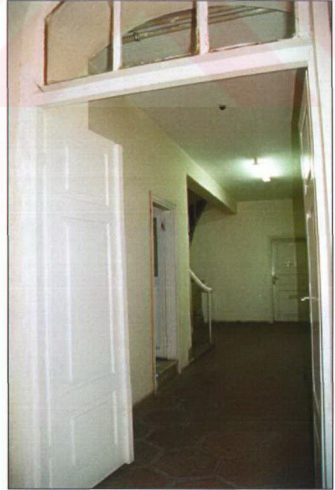
Resim 3.2.1.16 Kapı Ağası Dairesi'nin yenileme tekniğiyle restorasyonu yapılan bölümü (Ü. Karahasan arşivi)
