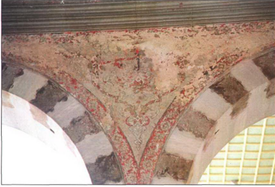
Resim 3.2.7.15 Hırka-i Saadet Dairesi Havuzlu Taşlık cephesinde taşlığa bakan kemerlerin iç yüzeylerinde bulunarak korunan XVIII. yüzyıl süsleme örnekleri (Ü. Karahasan arşivi)
