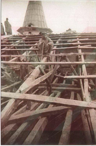
Resim 3.1.1.10 1943'te Bab-üs Selam revak çatı sında strüktürel sağlamlaştırma (TSDA. TSM. No: 55/37)
