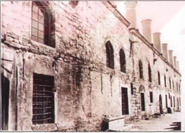
Resim 3.1.3.3 Mutfaklar (aşhane) 1943 restorasyonu öncesi dış görünüşü (TSDA. TSM. 55/36)
