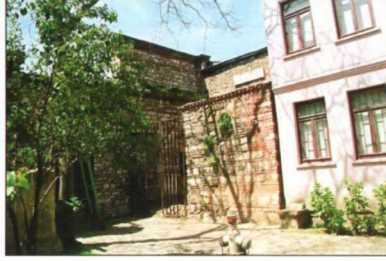
Resim 3.1.3.37 Vekilharç Dairesi'nin yerine yapılan yeni yapı ile Dolap Ocağı arasında kalan kısımdaki kagir eski yapı (Ü. Karahasan arşivi)
