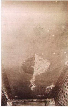
Resim 3.4.13.13 Cariyeler Dairesi 2. Oda restorasyon öncesi görünüşü (TSDA. TSM. No: 55/49-a )
