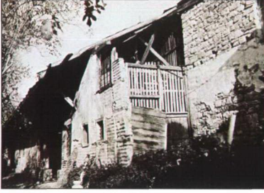
Resim 3.1.3.12 Yağhane ve Kiler Daireleri önünde ki geçekondü ek yapıların kaldırılmadan önce görünüşü (Öz, 1949)
