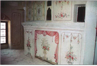
Resim 3.4.16.1 Cüceler Dairesi'nde üst katta onarımı yapılan kalem işleri (Ü. Karahasan arşivi)
