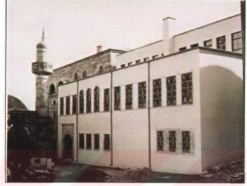
Resim 3.2.5.3 Hazine Kethüdalığı Dairesi arka cephe onarım sonrası görünüşü (TSDA. TSM. No: 55/59-c)
