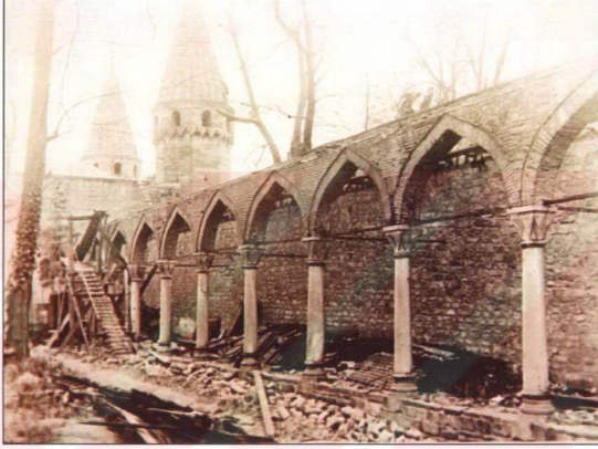
Resim 3.1.2.1 Bab-üs Selam'ın sağ tarafında revakların 1943 restorasyonları öncesi görünüşü; revak kemer alınları ve duvarları sıvasız ve tavanlar tamamen çökmüş durumdadır (TSDA. TSM. 55/37).
