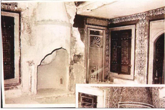
Resim 3.4.13.11 Cariyeler Dairesi 3. odanın onarım öncesi görünüşü (TSDA. TSM. No:55/49-a)
