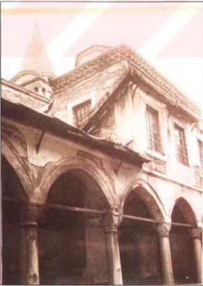
Resim 3.4.13.3 Cariyeler Taşlığı onarım öncesi görünüşü (TSDA. TSM. No: 55/53)
