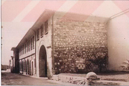
Resim 3.1.3.30 Tahsin Öz onarımlarında Has Mutfak Kapısı'nın ve solundaki Aşçı Koğuşları'nın bütünleme onarımları ile restorasyonlarının yapılmasından sonra görünüşü; sağ tarafta harap durumdaki koğuşlara ait revaklar yıkılarak kaldırılmıştır. (TSDA. TSM. No: 55/36)
