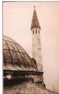
Resim 3.4.5.6 III. Murad Köşkü bacası onarım sonrası görünüşü (TSDA, TSM. No: 55/49-a)
