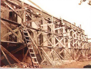
Resim 3.2.1.9 Akağalar Koğuşları dış cephe onarımı (TSDA. TSM. No: 55/50)
