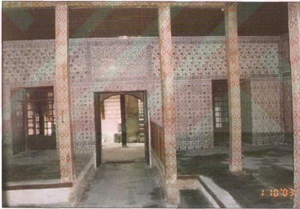
Resim 3.1.9.2 Zülüflü Baltacılar Koşu giriş kapısı cephesi iç kısımdan görünüş; ahşap sütunlar üzerinde raspa sonucu ortaya çıkartılan özgün kalem işleri görülmektedir.
