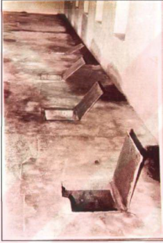
Resim 3.1.6.5 Dış Hazine'nin taş yer kaplama sı ve döşemelerde saklama fonksiyonu için ya pılan kapakların görünüşü. Restorasyon sonra sı bu kapaklar kaldırılmıştır. (TSDA. TSM. No: 55/48-a; No: 55/48-b)
