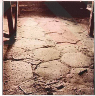
Resim 3.2.10.12 Arz Odası'nda parke döşeme altında bulunan ve tekrar üzeri parke kaplanan altıgen tuğla döşeme (TSDA. TSM. 55/48-b)
