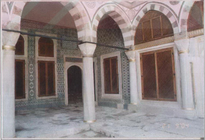
Resim 3.4.1.9 Valide Taşlığı Karaağalar cephесindeki revakların bugünkü görünüşü; revak kemer gergi demirlerinin üstündeki ek kısımlar kaldırılmıştır (Ü. Karahasan arşivi).
