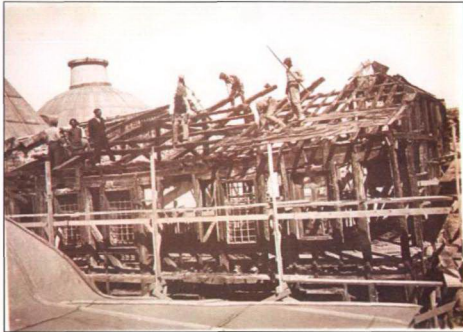
Resim 3.1.3.11 Aşçılar Camisi'nde 1943 restorasyonunda yapılan strüktürel güçlendirme çalışmaları (TSDA. TSM. No:55/53)
