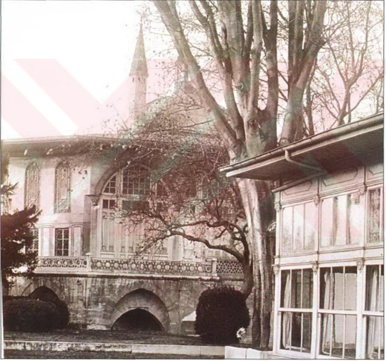
Resim 3.3.2.6 Bağdat Köşkü, Sofa Köşkü cephesinin Cumhuriyet dönemi restorasyonları öncesi görünüşü; Dikkatle bakıldığında iki farklı korkuluk örneği görülmektedir. Sol taraftaki korkuluklar Havuzlu Taşlık'ta havuz çevresinde de görülen ve onarımlarda kaldırılan korkulukların aynıdır. Büyük bir olasılıkla bu korkuluklarda Çırağan Sarayı'ndan getirilmiş olmalıdır. Sağ taraftaki korkuluklar da Köşk'ün diğer cephesinde onarılan korkuluklarla benzer özelliktedir (TSDA. TSM. No: 55/80).
