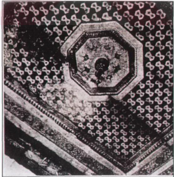
Resim 3.4.4.32 IV. Mehmed Kasrı restorasyon sonrası görünüşü (Anhegger, 1986).
