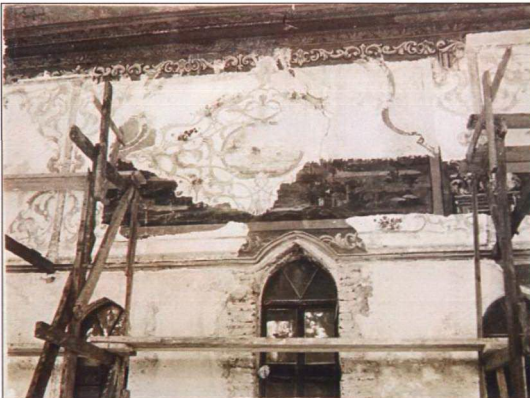
Resim 3.1.1.15 Bab-üs Selam'ın İkinci Avlu'ya bakan revak duvarında raspa sırasında ortaya çıkan kalem işleri (TSDA. TSM. No: 55/37).
