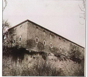
Resim 3.1.3.40 Mutfakların Marmara Denizi cephesinin onarım sonrası görüntüsü (TDMA. TSM. No: 55/70-b)
