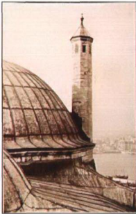
Resim 3.4.5.5 III. Murad Köşkü bacası onarım öncesi görünüşü (TSDA, TSM. No: 55/49-a)
