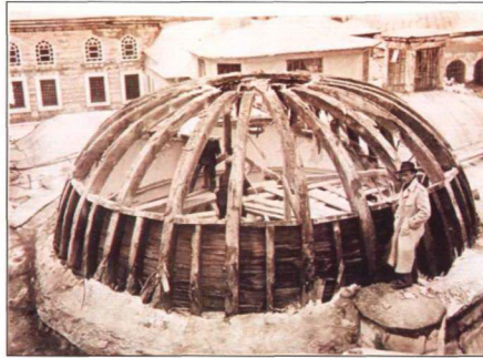
Resim 3.4.3.1 Ocaklı Sofa ahşap kubbe strüktürün sökülmesi (TSDA. TSM. No: 55/52)
