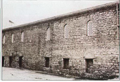
Resim 3.1.3.13 Yağhane ve Kiler Dairesi'nde temizleme ve sağlamlaştırma çalışmalarında sonra görünüş (Öz, 1949)
