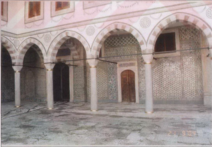
Resim 3.4.1.11 Valide Taşlığı revakları bugünkü görünüşü; Solda revakları kapatan duvar kaldırılmıştır (Ü.Karahasan arşivi)
