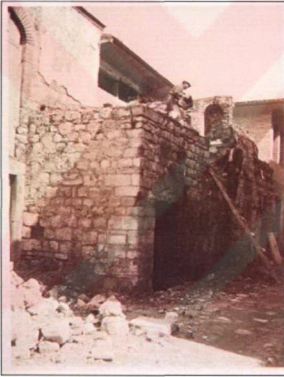
Resim 3.1.3.31 Aşçılar Hamamı 1943 restorasyonları; bütünleme tekniği kullanılarak yapı tamamlanmıştır (TSDA. TSM. No: 55/36).
