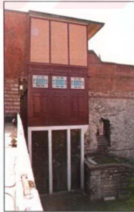
Resim 3.4.18.6 Mabeyn Odası restorasyon sonrası görünüşü (Ü. Karahasan arşivi)
