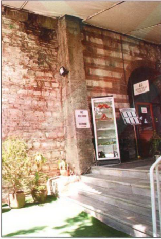
Resim 3.3.10.4 Çadır Köşkü'nde yapılan betonarme göğüsleme ayağı (Ü. Karahasan arşivi)
