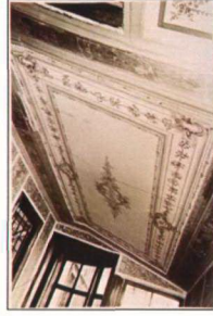
Resim 3.4.12.6 III. Selim Dua Odası merdiven başı tavanı onarım sonrası görünüşü (TSDA. 55/49-a )
