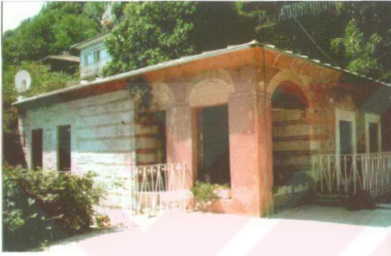
Şekil 3.10 Üst kat güneydoğu ve kuzeydoğu cepheleri
