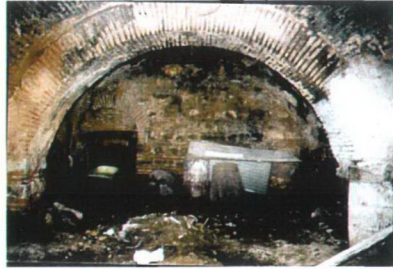
Şekil 4.3 Bodrum kat iç mekanda tonoz
