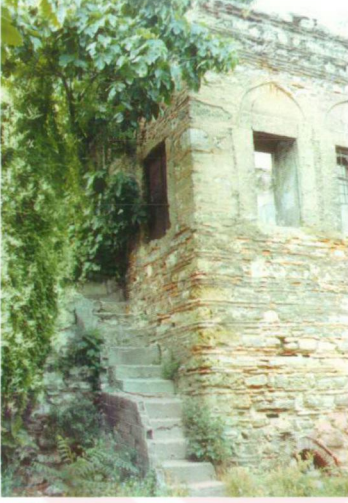
Şekil 3.1 Üst kata ulaşımı sağlayan dış merdivenler
