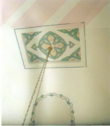
Şekil 3.17 Mevcut tavan bezemesi
