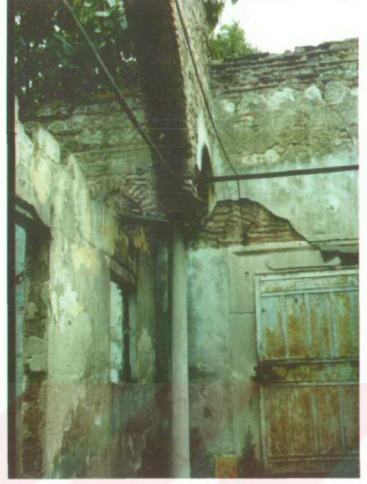
Şekil 3.2 Üst katta seki altı, sütun ve giriş kapısı
