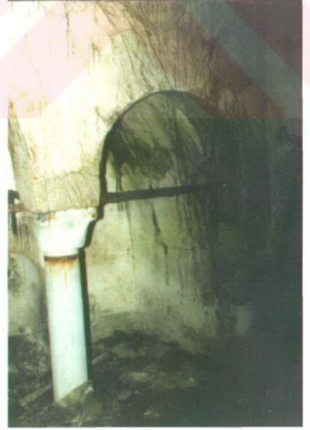
Şekil 3.4 Zemin kat iç mekan
