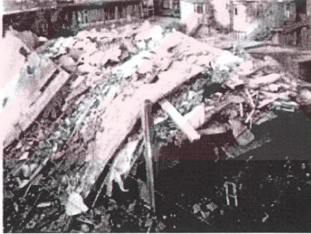
Şekil 5.61 Yapının yatay rijitlik eksikliğine bağlı olarak tamamen çökmesi (pankek tarzı) (Çelik, 1999)
