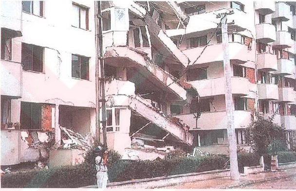
Şekil 5.44 Düşey salınımlara bağlı olarak, köşe balkonların yıkılması [25]
