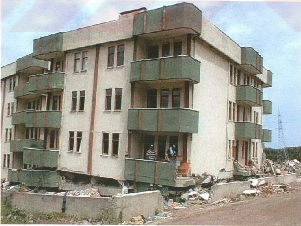
Şekil 5.37 Yapının zemin katının yumuşak kat etkisine bağlı olarak çökmesi [23]
