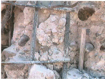
Şekil 5.67 Bingöl depremi – Niteliksiz beton (Kaplan, vd., 2003)
