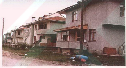
Şekil 5.9 Gölçük - 5 katlı yapılarda ağır hasarlar olduğu görülürken, 2 katlı yapılarda hasarların sınırlı kaldığı görülmektedir (AFPS, 1999)
