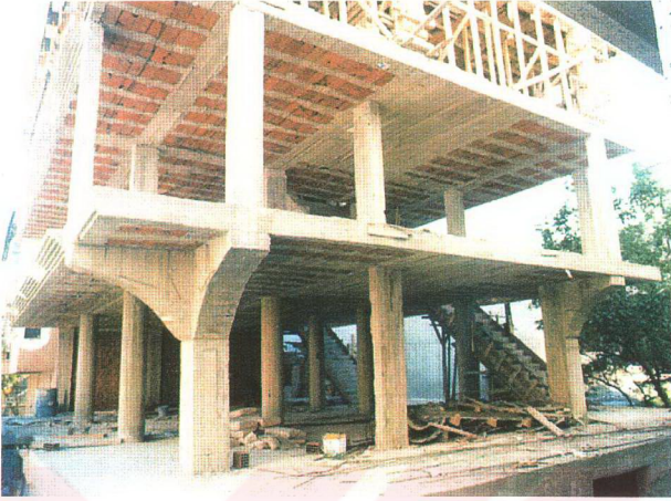
Şekil 5.39 Konsol ucunda kolonlu yapı (Çelik vd., 2000)
