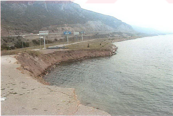
Şekil 5.15 İzmit Körfezinin kuzeyinde sahil şeridinde heyelan (AFPS, 1999)
