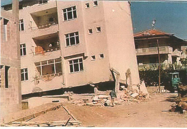
Şekil 5.38 Yapının yumuşak kat etkisine bağlı olarak zemin katının çökmesi [24]
