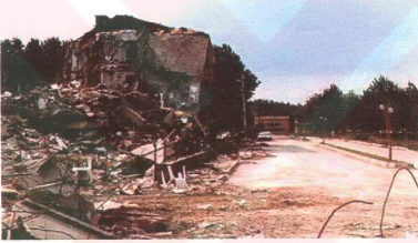
Şekil 5.9 Gölçük - 5 katlı yapılarda ağır hasarlar olduğu görülürken, 2 katlı yapılarda hasarların sınırlı kaldığı görülmektedir (AFPS, 1999)
