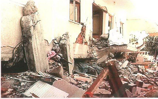
Şekil 5.68 Marmara depremi - Kalitesiz beton ve büyük ihtimalle deniz kumu kullanımına bağlı olarak, beton-çelik birleşiminin yetersiz olması ve çeliğin betondan sıyrılması [35]
