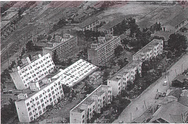
Şekil 5.11 Japonya Niigata'da sıvılaşma yüzünden devrilen yapı grupları [17]
