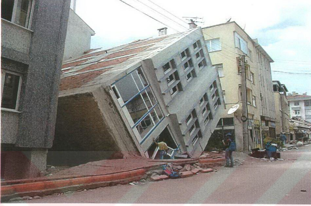
Şekil 5.12 Adapazarı bölgesinde sıvılaşmaya bağlı hasar oluşumu: yan yatan yapı (AFPS, 1999)
