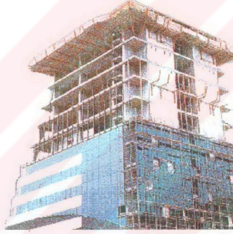
Şekil 2.34 Giydirme cephenin aşağıdan yukarıya doğru yerleştirilmesi.
