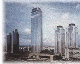
Şekil 2.14 Bir giydirme cephe örneği
