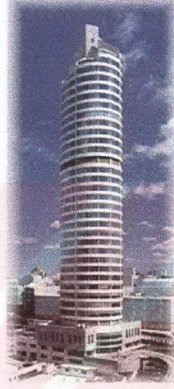
Şekil 2.13 Yüksek yapılar ve giydirme cepheler.
