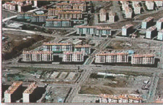
Resim 5.16 Diyarbakir Toplu Konutlarının Genel Bir Görünümü
