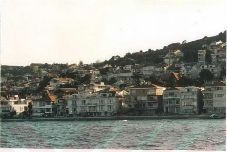
Şekil 5.3 Kınalıada'da, deniz kıyısında beton apartmanlar.
