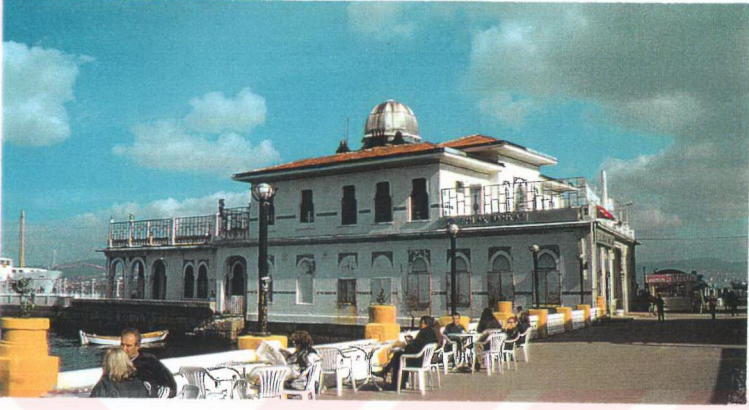
Şekil 4.89 Büyükada iskele binası.
