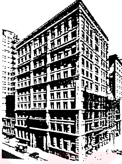
Şekil - 6.2. Sigorta Binası, Chicago (W.B. Jenney, 1883 - 85)
