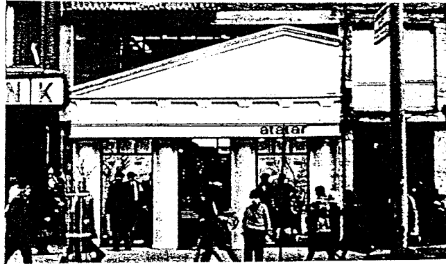
Şekil - 2.25 İstanbul, Atalar Mağazası cephesi.
