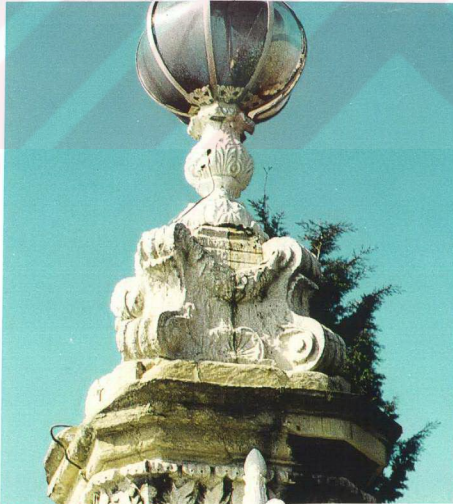
Şekil 4.22. Rıhtım boyunca uzanan parmaklıklı taş babaların yüzeyinde kırılmalar görülmektedir.
