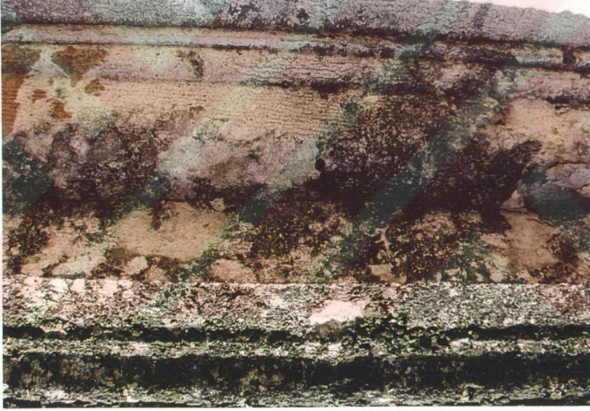
Şekil 4.34. Dolmabahçe Sarayı cephelerinde özellikle subasman seviyesindeki taş yüzeylerinde sıcaklık ve nem değişikliklerinin uç değerlerde olması nedeniyle algler görülmektedir.
