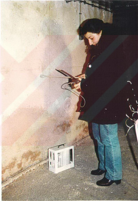
Şekil 4.24. Değerli Eşyalar Sergi Salonu 2' nin bodrum katında yüzeyde oluşmuş tuz çiçeklenmeleri görülmektedir. Bu mekanda duvar nemi ve ortamın ısı-nem değerleri tespiti için ölçümler yapılmıştır.
