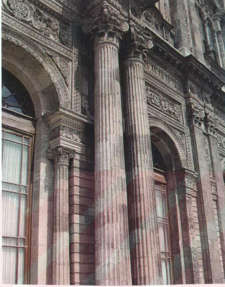
Şekil 4.5. Muayede Salonu'nun deniz tarafına açılan güney cephesindeki kemer ve sütunların yapım aşamasında farklı basınç etkisine dayanımlı olarak yapıldığı anlaşılmaktadır.
