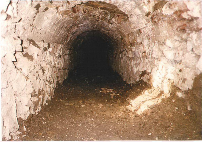
Şekil 4.16. Sarayın bodrum katında yapılan kanal temizleme çalışmaları görülmektedir.
