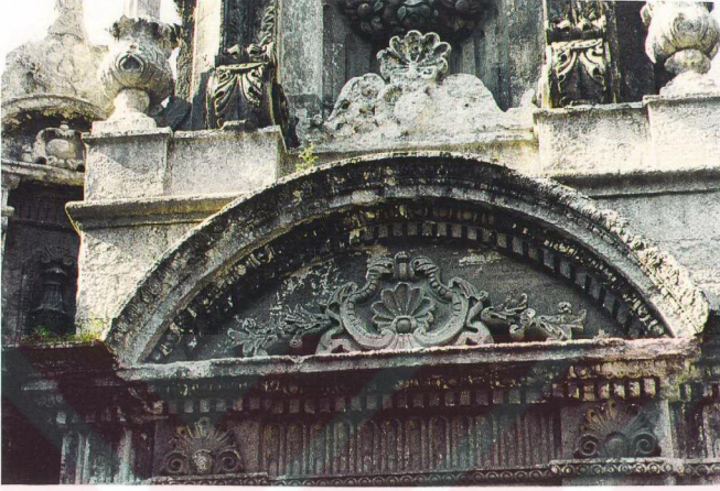
Şekil 4.29. Deneyler için alınan 2 nolu örnek taşın bulunduğu Saltanat Kulesi'nin yüzeyindeki hava kirliliği ve malzeme erimesi görülmektedir.
