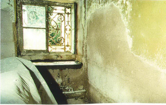
Şekil 4.26. Sarayın bodrum katındaki oda ve salonlardaki bozuk duvar yüzeyleri, geleneksel horasan harçlı sıva tekniğiyle onarılmaktadır.
