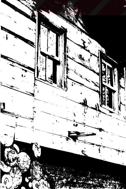
Fotoğraf 22 Ilgaz - Bostan Köyü, tahta kaplama (çaplama) örneği
