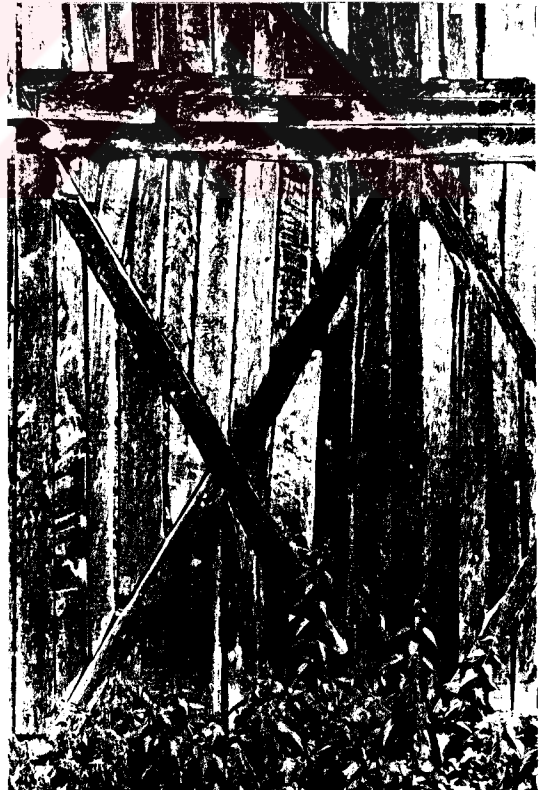
Fotograf 47 Mudurnu - Karacasu Köyü, ağaç dolgulu çapraz payandalı ahşap çatkı örneği
