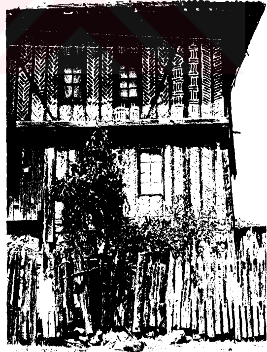
Fotograf 54 Araç-Pelitören Köyü, tuğla dolgulu konut örneği
