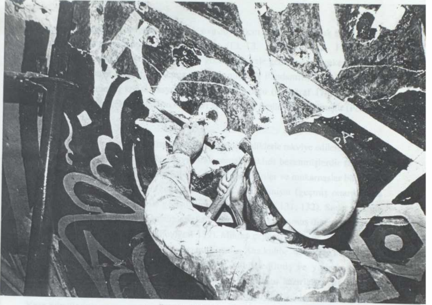
Fotoğraf.119. Pandantiflerde Beton Sivanın Sökülüşü
