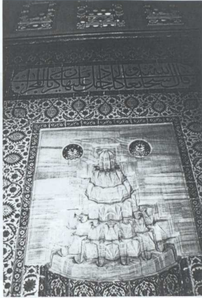
Fotoğraf.416. Mihrap Restorasyon Sonrası
