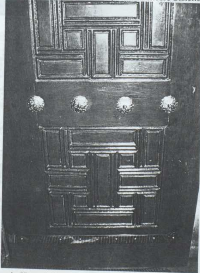
Fotoğraf.64. Zemin Kotundaki Pencereilerin Ahşap Kündekâri Kepenklerinden Biri
