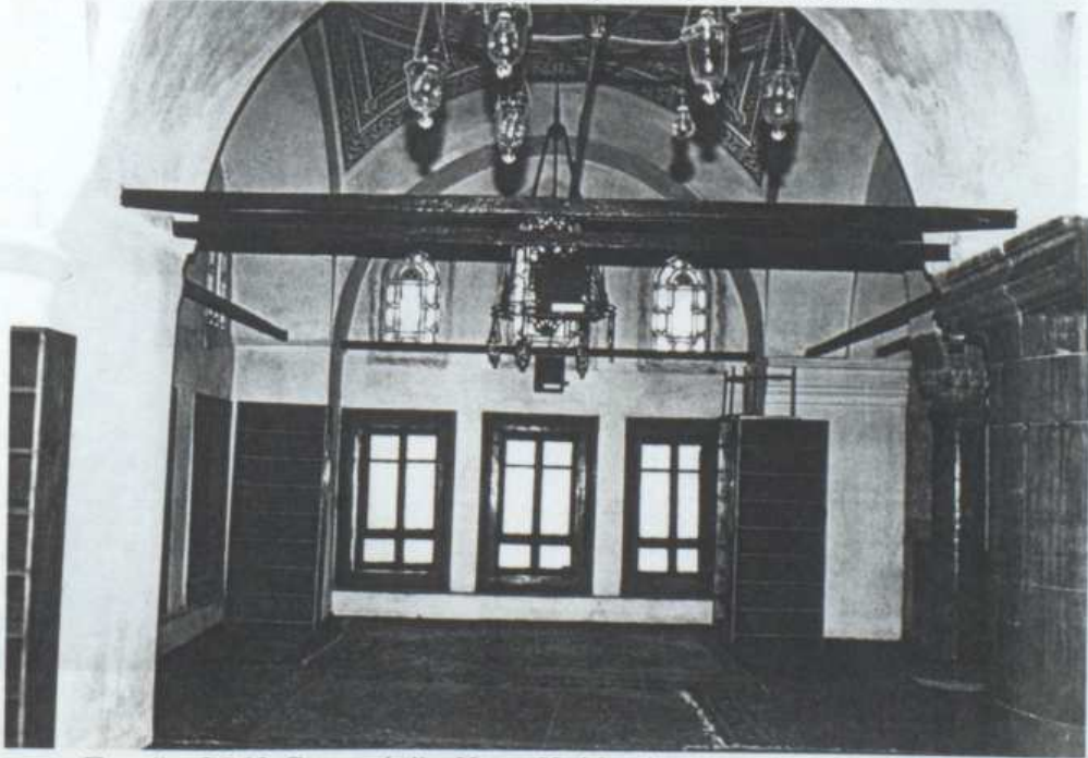
Fotoğraf.563. Güneydoğu Köşe Kubbesi Altı Pencere Sistemi
