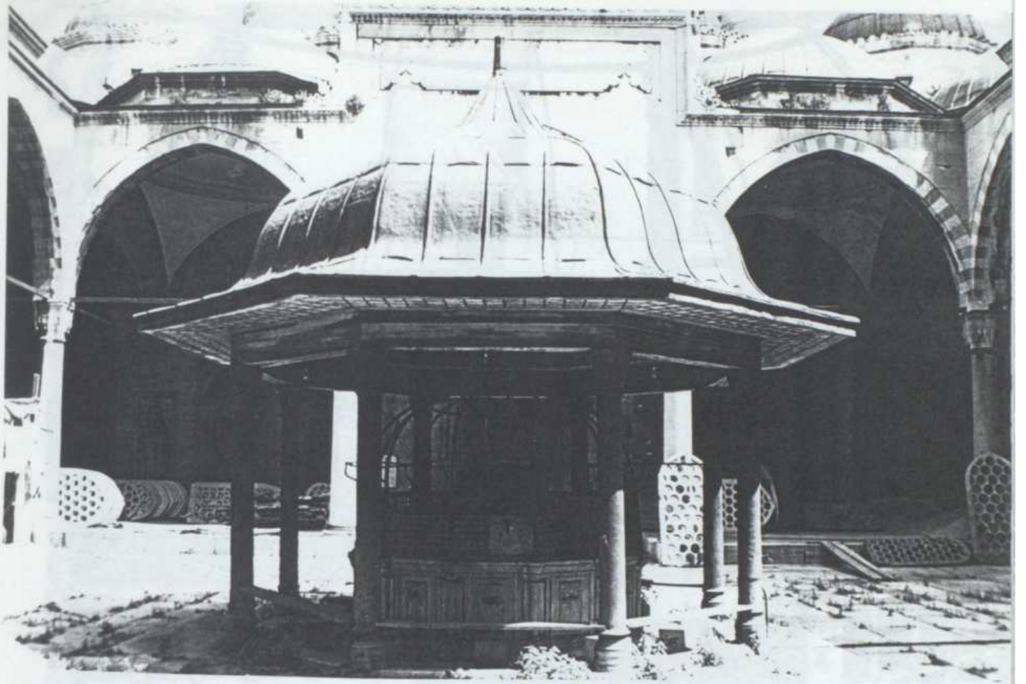
Fotoğraf.144. Şadırvanın Eklentilerden Arındırma Çalışmalarından Önceki Hali
