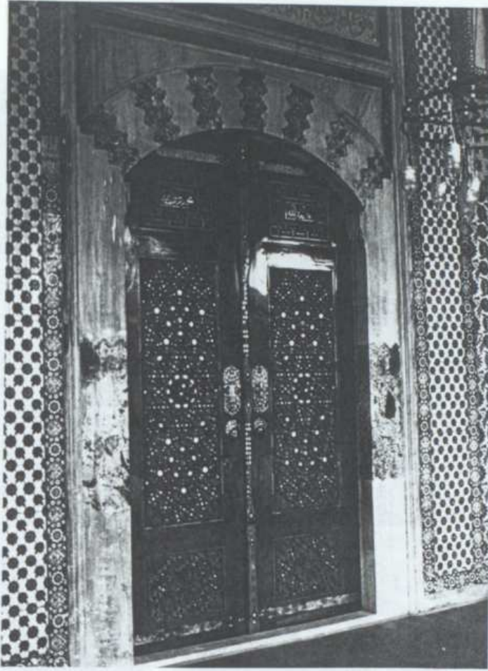
Fotoğraf.422. Cümle Kapısı Kanatları Restorasyon Sonrası
