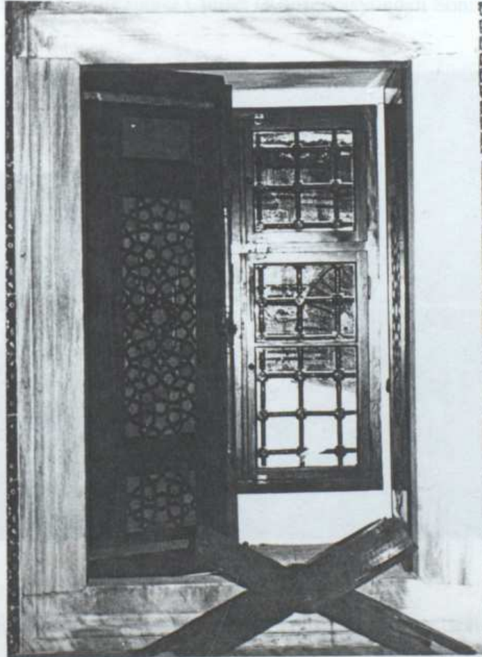
Fotoğraf.432. Pencere Sövesi, Kepenki, Doğraması, Lokmalı Demir Parmaklı Rahlesi (Restorasyon Sonrası)
