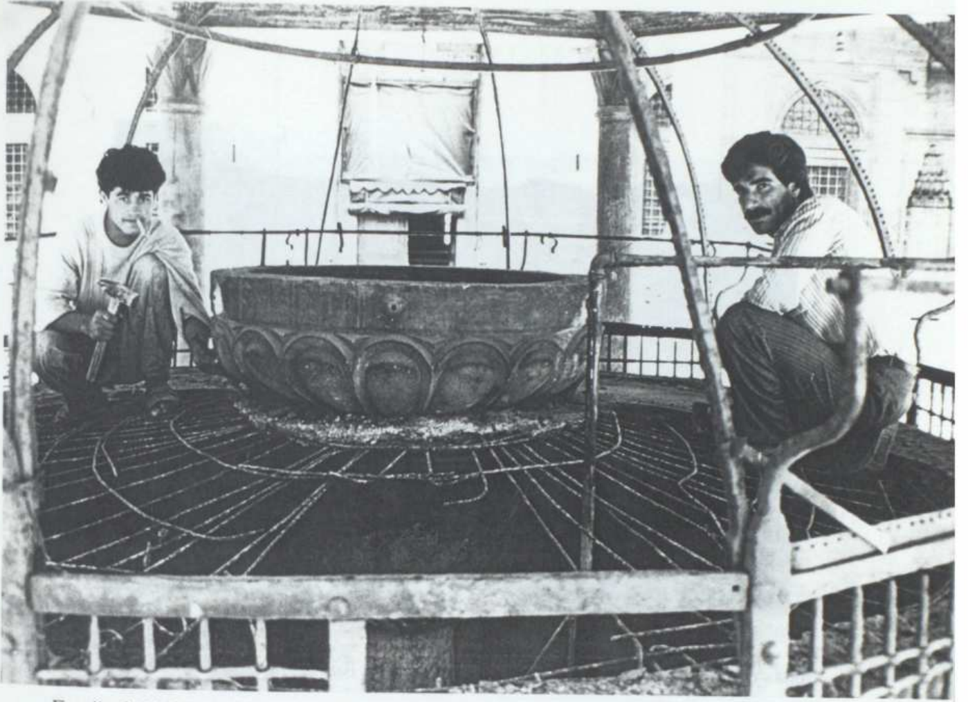
Fotoğraf. 146. Fiskiyeli Göbek Çanağının Etrafındaki Betondan Arındırma Çalışmaları
