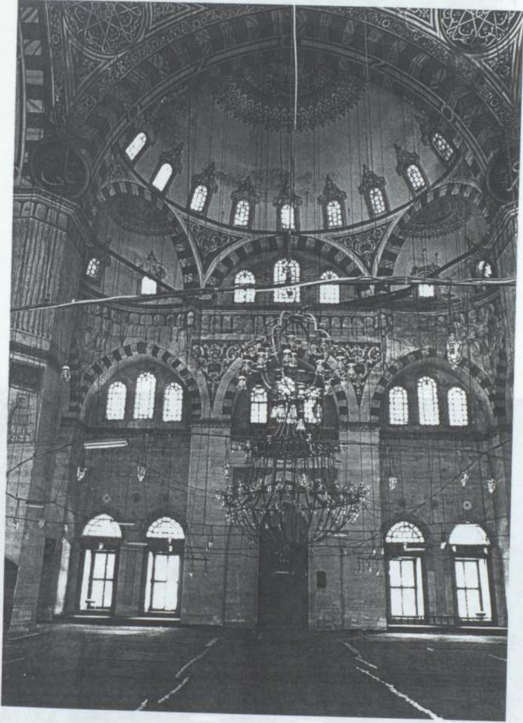
Fotoğraf.3. Duvarlarda Pencere Üstlerindeki Rozanatörler
