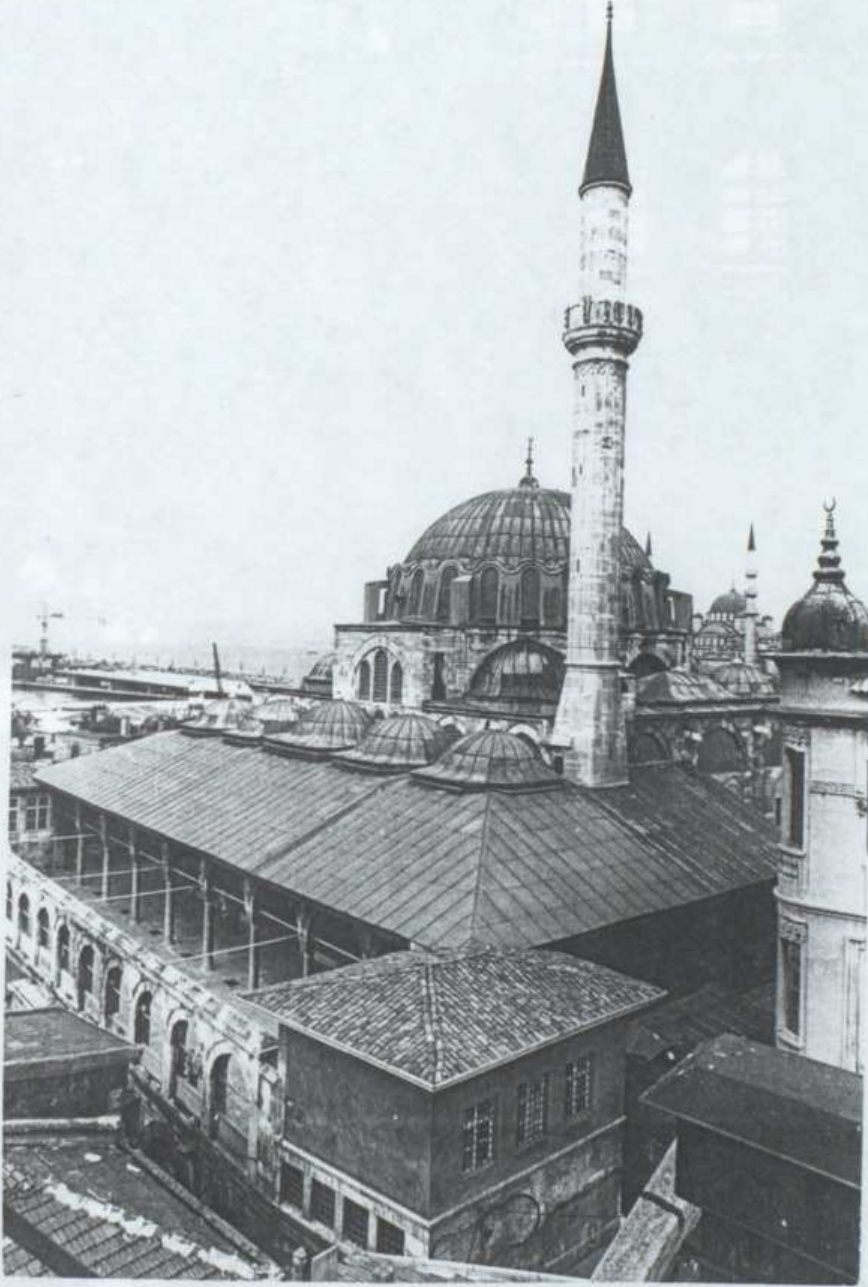
Fotoğraf.266. Rüstem Paşa Cami Genel Görünüü
