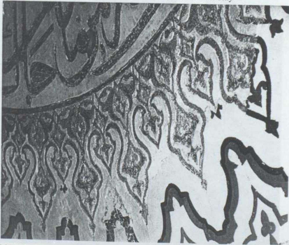
Fotoğraf.87. Yarım Kubbelerde Siva Raspası Altından Malakâri Bezeme Bulunmuştur.
