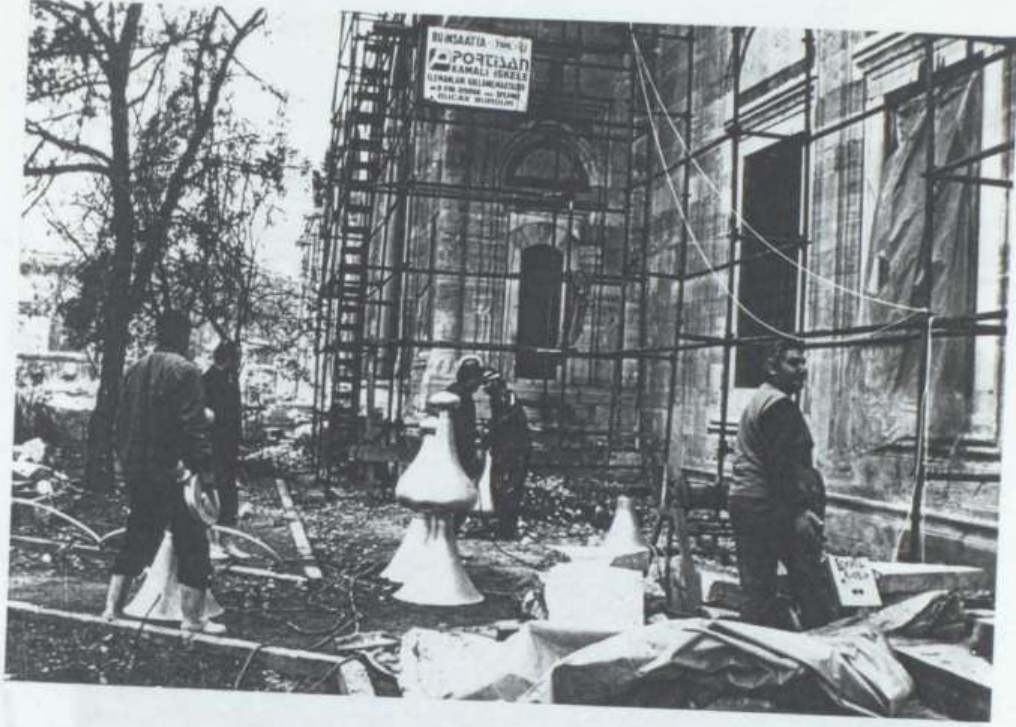
Fotoğraf.135. Altın Varakları Yapılan Bakır Âlemlerin Kubbeye Çıkarılış Çalışmaları
