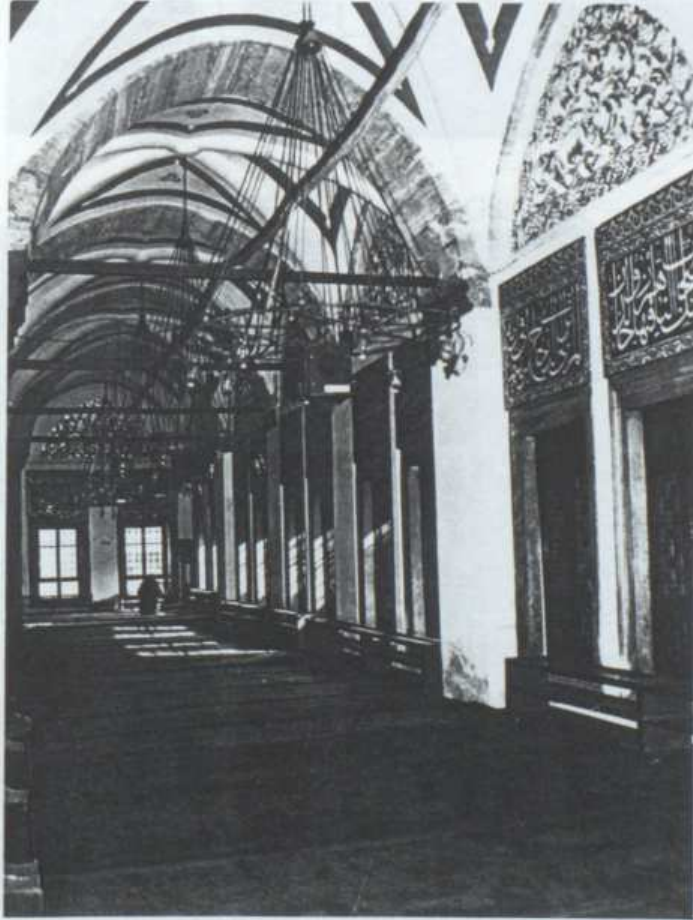
Fotoğraf. 586. Alt Galerilerin Görünüşü
