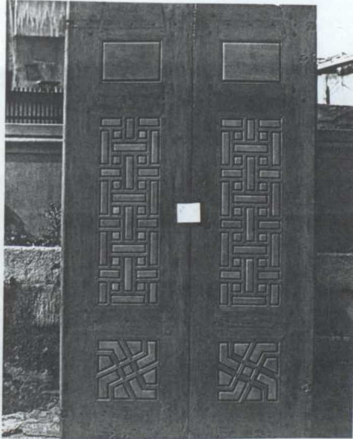
Fotoğraf.343. Kündekâri Ahşap Pencere Kepenki
