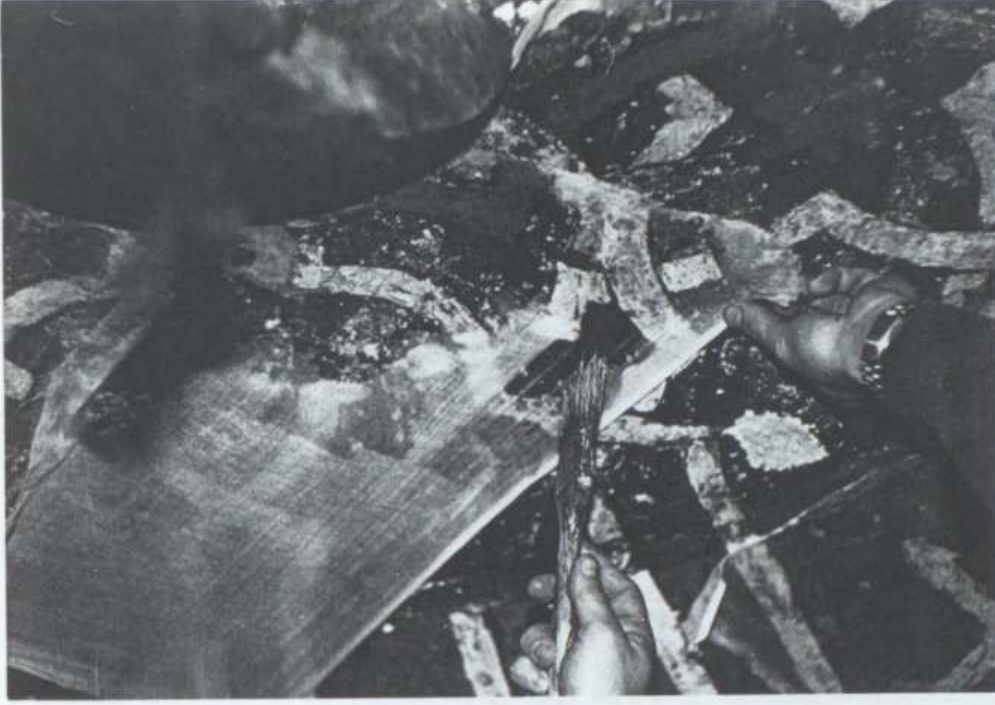
Fotoğraf. 398. Reçinenin Yüzeye Fırça ile Uygulanışı
