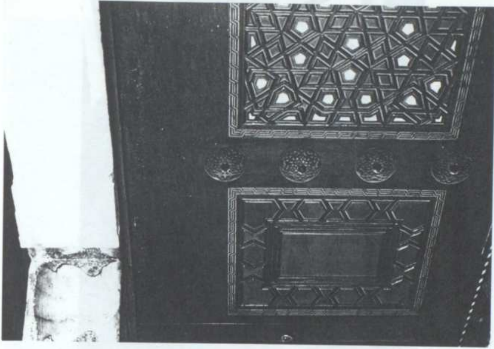
Fotoğraf.591. Kündekâri Cümle Kapısı Kanadı Üst Panosu
