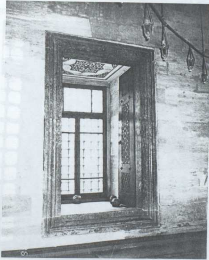
Fotoğraf.224. Ahşap Kanatlı Pencerelerden Biri
