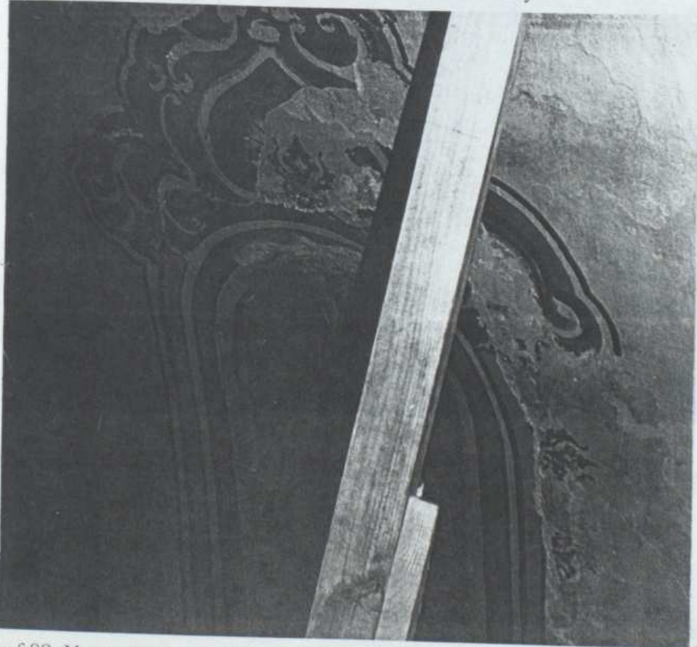
Fotoğraf.89. Yarım Kubbe ve Eksedra Pencere Çevrelerindeki Raspalar ve Bulunmaları
