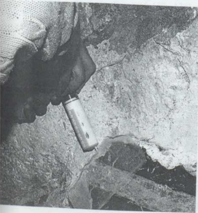
Fotoğraf.120. Mevcut Sivaya Yapıştırıcı Enjeksiyonu
