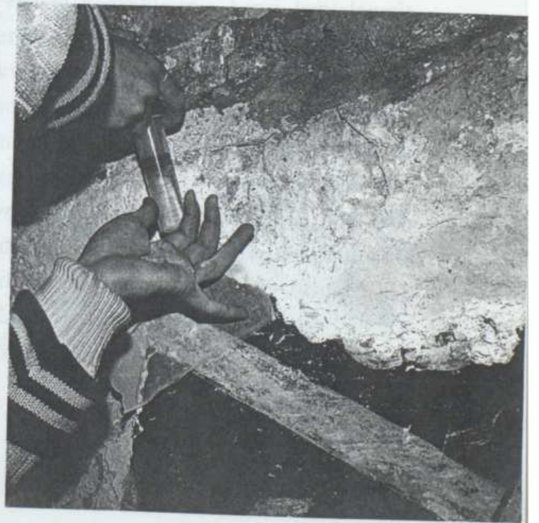
Fotoğraf.121. Mevcut Sivaya Özgün Malzeme Enjeksiyonu
