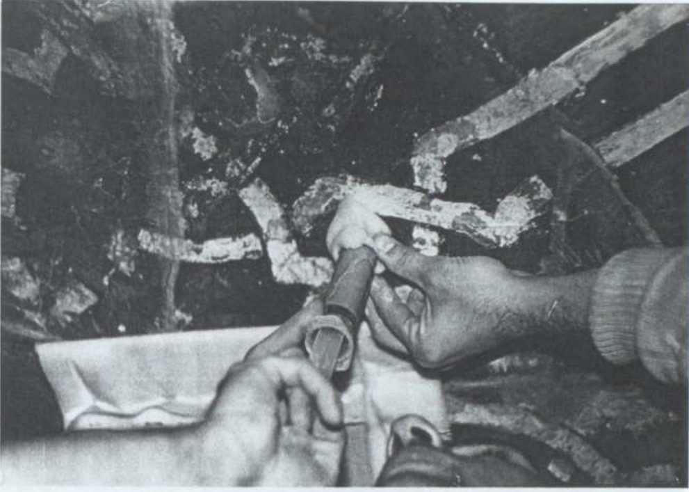
Fotoğraf.400. Kubbedeki Sıva Altına Enjeksiyon Tatbikatı
