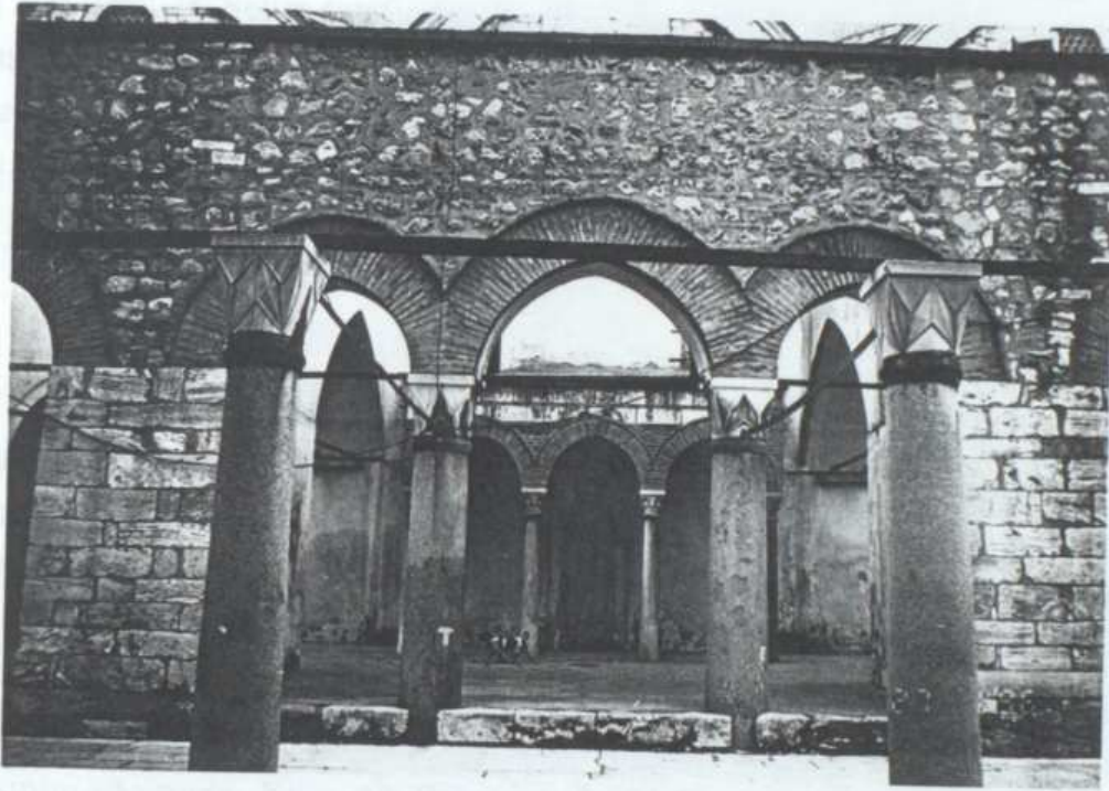
Fotoğraf.551. Son Cemaat Revakının Görünüşü
