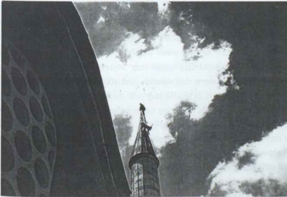
Fotoğraf.397. Minare Külâhı Kurşun İşleri Yapılırken
