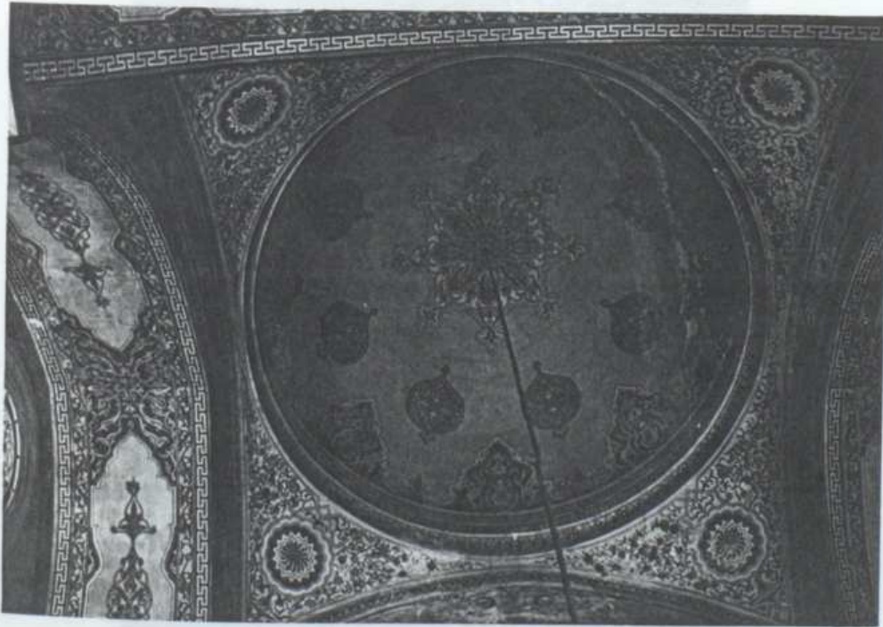
Fotoğraf.158. Üçgenler Arasındaki Küçük, Kubbeler ve Askı Kemerleri
