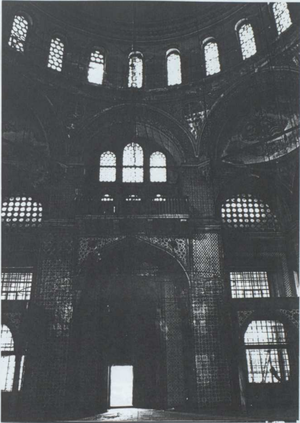
Fotoğraf.335. Cümle Kapısı Üstü Konsollu Çıkması
