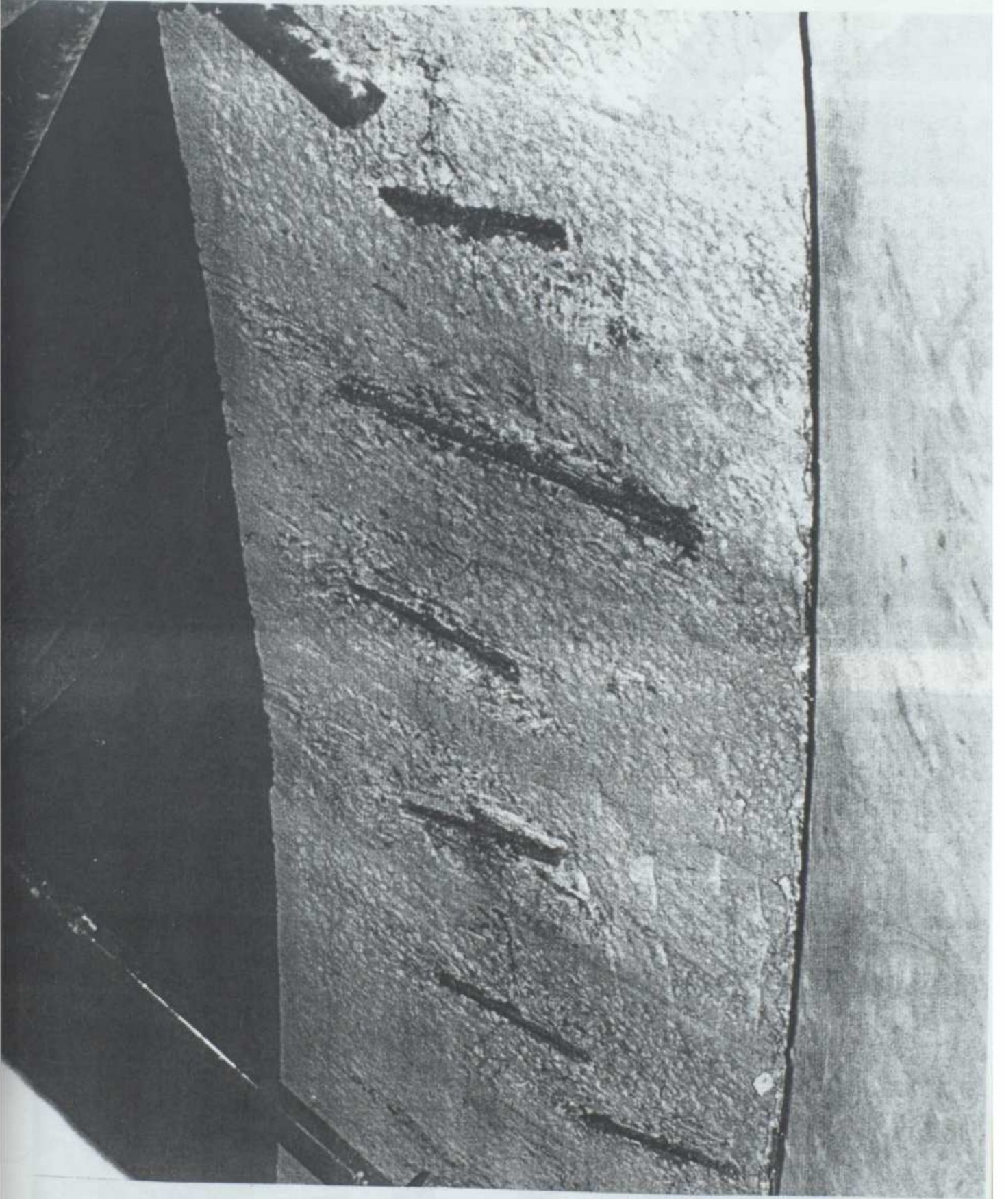
Fotoğraf.128. Askı Kemerlerindeki Çatlakların Çelik Takviyelerle Güçlendirilmesi
