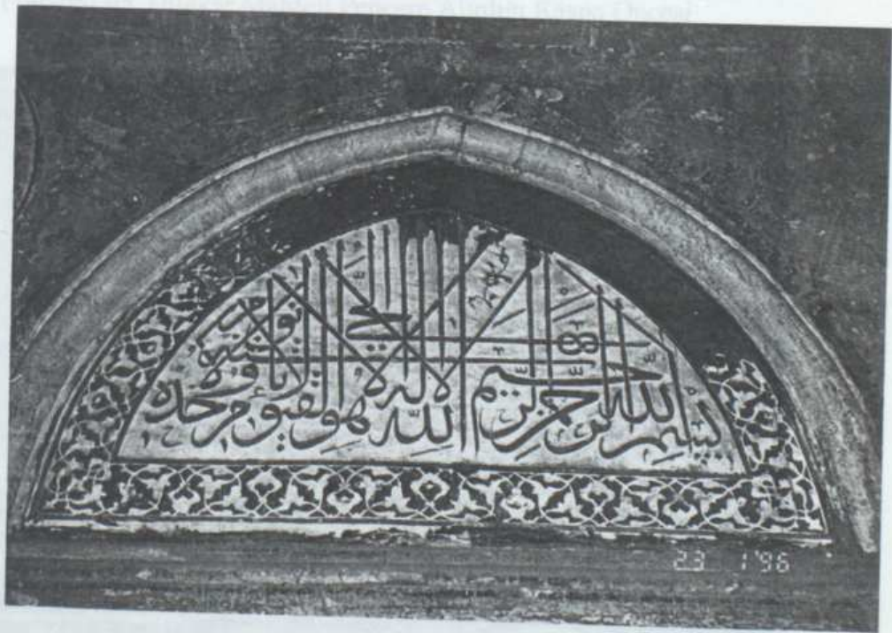
Fotoğraf.94. Hünkâr Mahfelindeki Pencere Alınlığı Raspa Sonrası
