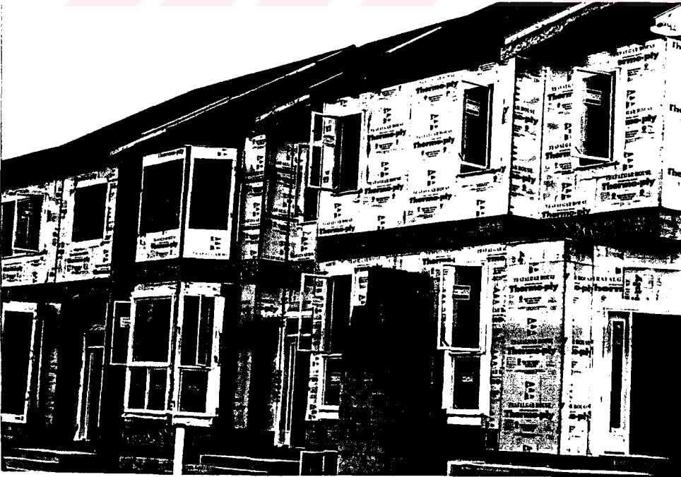
Resim 3.11 Dış Duvar Yalıtım Ayrıntısı
