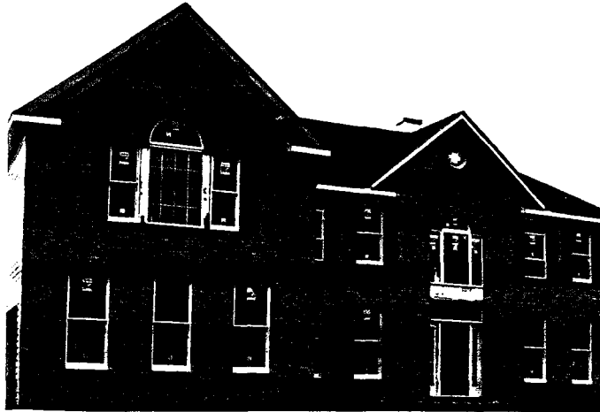
Resim 3.16 Önyapımlı Ahşap Pencere
