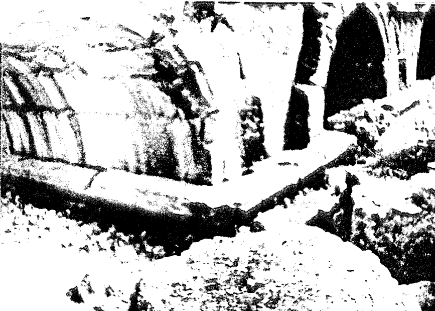
c) Giriş kapısı kagir tonozlu alt yapısı
