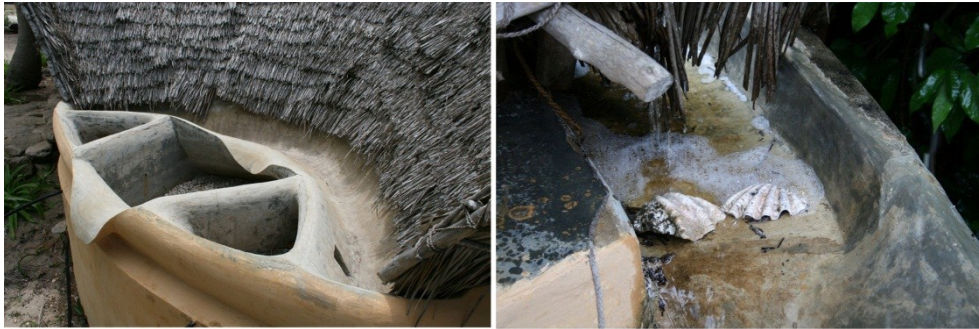
Şekil 4.3 Bungalovlarda yağmur suyu toplama ve gri su toplama Chumbeisland, Tanzanya [77]
