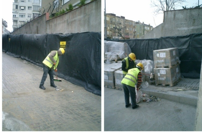
Şekil 4.47 İnşaat sırasında bakım ve temizlik_Polat Hotel-Barbaros-İstanbul
