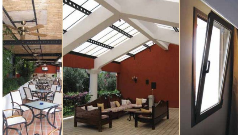
Şekil 4.34 Doğal havalandırma için uygulanan yöntemler [71]
