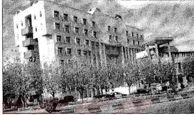
Fotoğraf 44. Şhitkamil Belediyesi Giriş Cephesi
