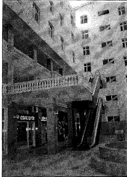
Fotoğraf: 20 Belediye Binası İç Mekandan Görünüş
