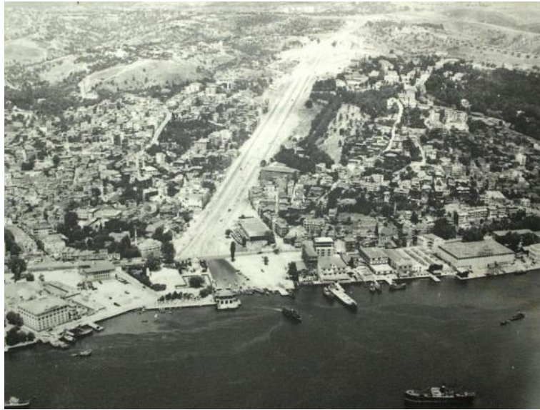
Şekil 2. 11 Barbaros Bulvarı yapım çalışmaları [165]
