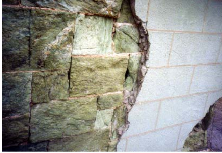
Şekil 2.10 Müdahalede hatalı malzeme seçimi
