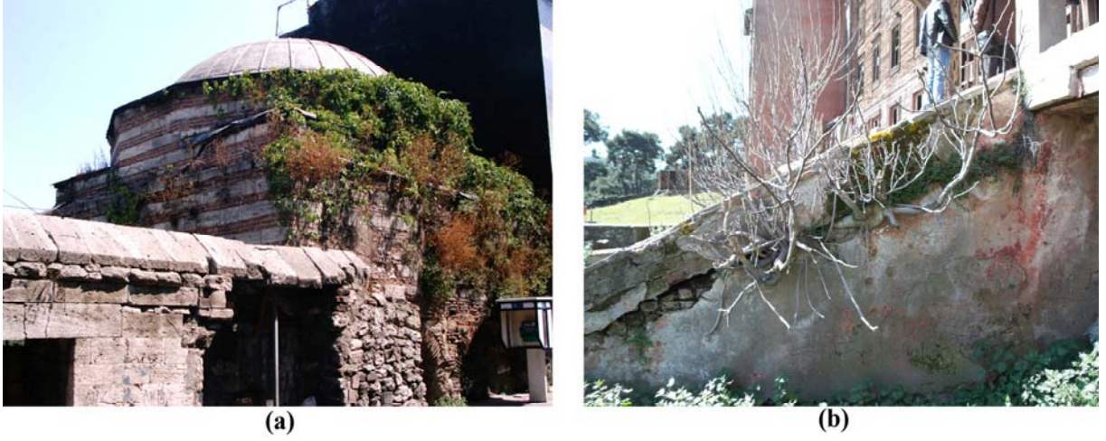
Şekil 2.6 Rüzgar ile taşınan bitkilerden kaynaklanan bozulmalar (a) Haydar Paşa Medresesi, İstanbul, (b) Yetimhane, Büyükkada, İstanbul
