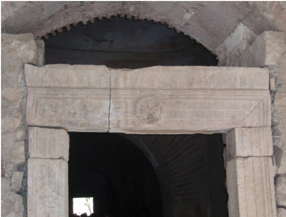
Şekil 3.20 Düşey kuvvet etkisiyle lentonun kırılması ve hafifletme kemeri oluşması, Aya Nikolas Kilisesi, Demre, Antalya (Fotoğraf: Görün Arun)
