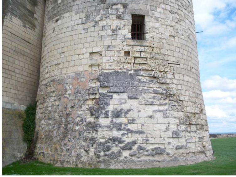
Şekil 2.2 İklimle bağlı bozulmalar, Val de Loire, Fransa
