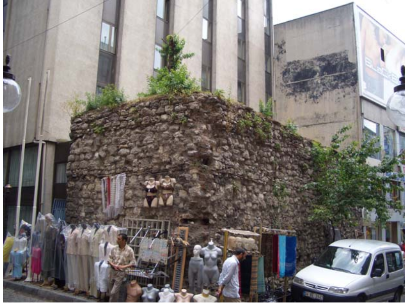
Şekil 2.13 Kullanılmayan ve terk edilen bir yapıda meydana gelen bozulma ve hasarlar, Daltaban Mescidi, İstanbul
