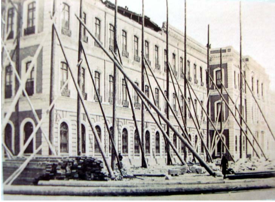
Resim 2. 34 Seraskerlik binasının 1894 depremi sonrası tamiri (Haz. Genç, 2000, 50).
