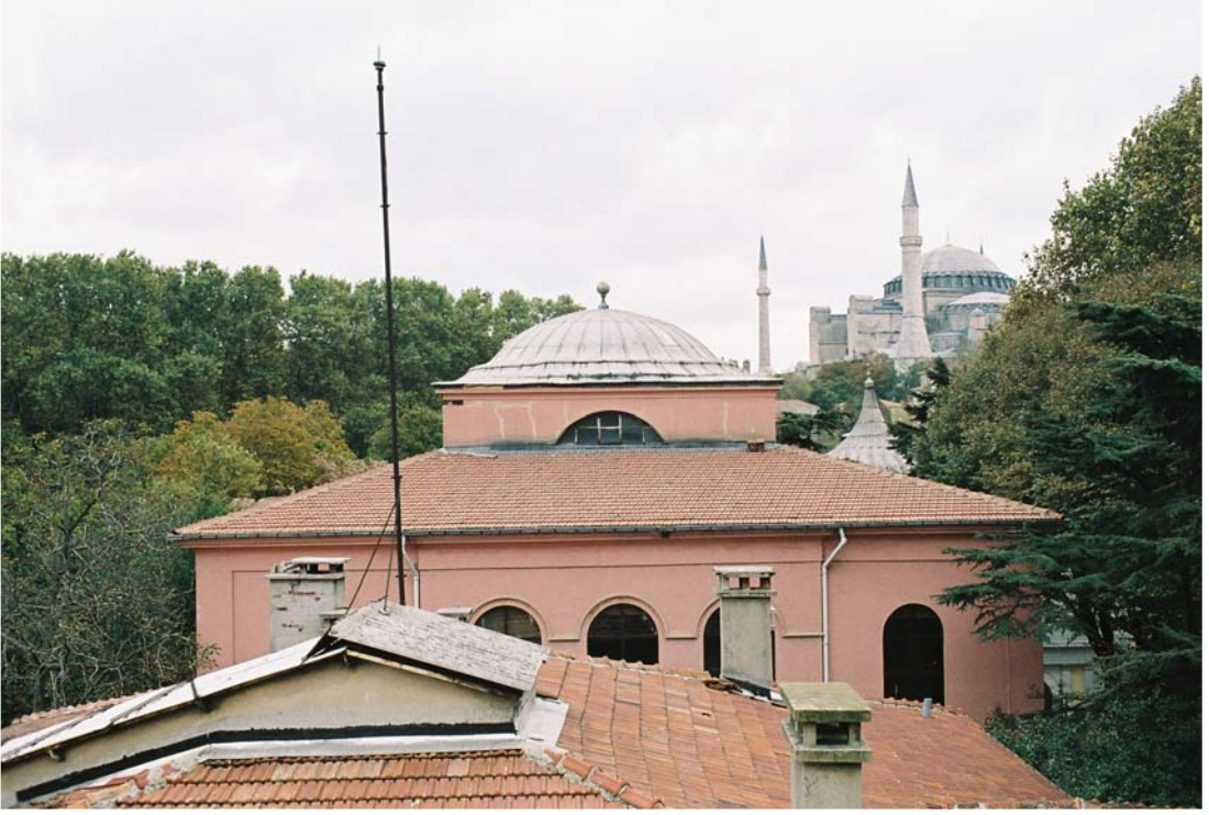
Resim 2.102 Hazine-i Evrak binası kubbesi.
