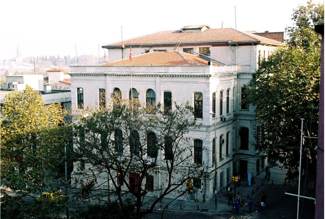
Resim 2.127 . Eski Nafia Nezareti (İstanbul İl Milli Eğitim Müdürlüğü) binası.
