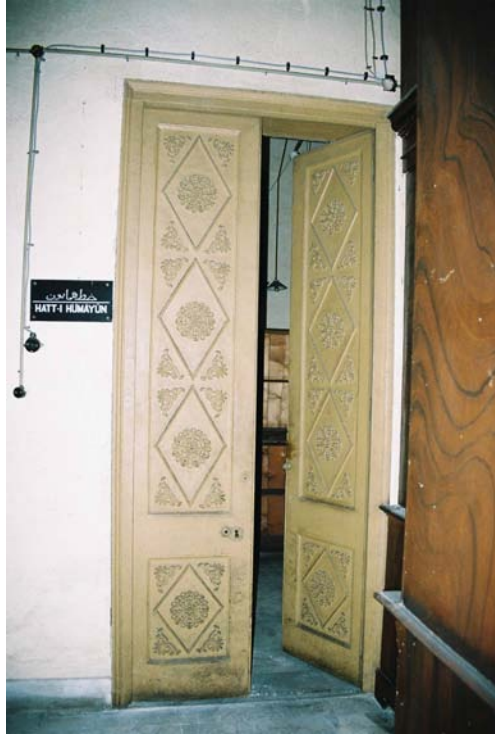
Resim 2.107 Hazine-i Evrak binası alt kat yan oda giriş kapısı.
