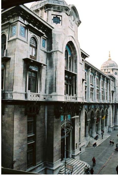
Resim 2.136 Eski Posta ve Telgraf Nezareti (Sirkeci Büyük Postahane) binası.
