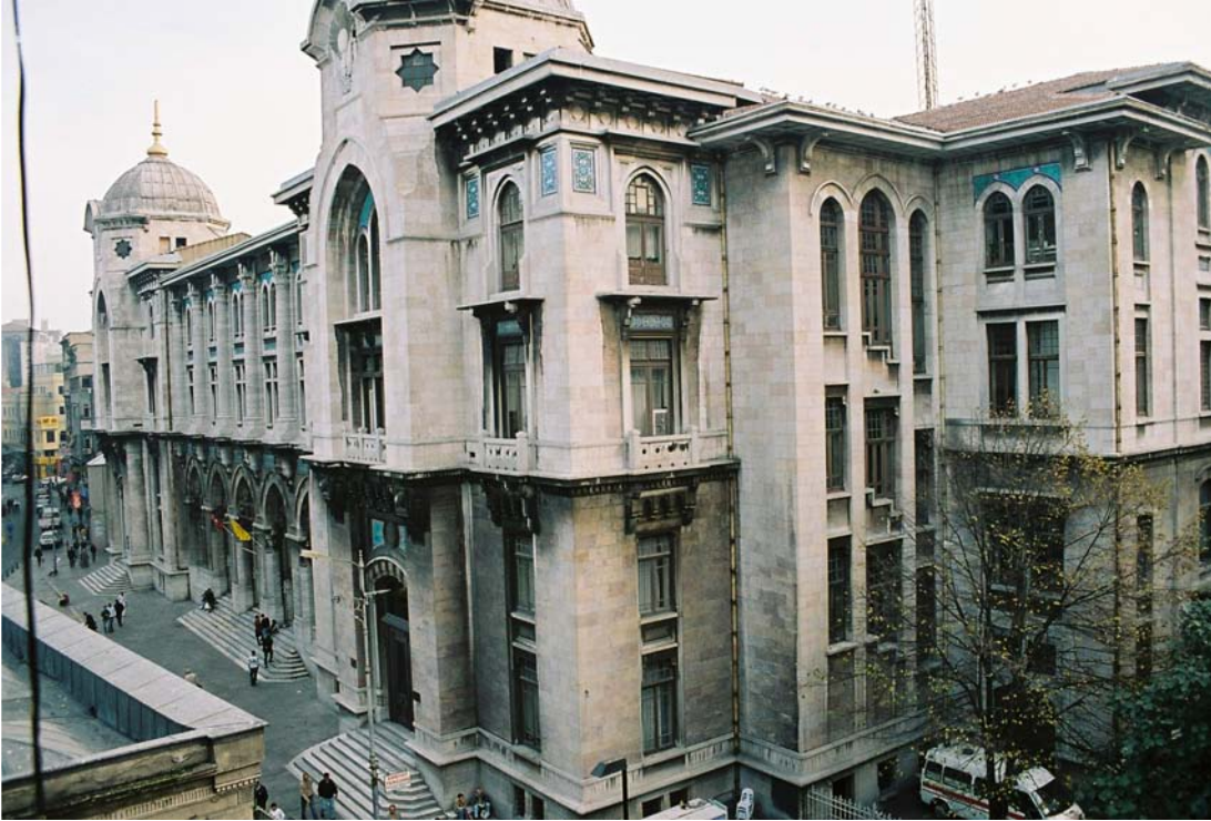
Resim 2.135 Eski Posta ve Telgraf Nezareti (Sirkeci Büyük Postahane) binası.
