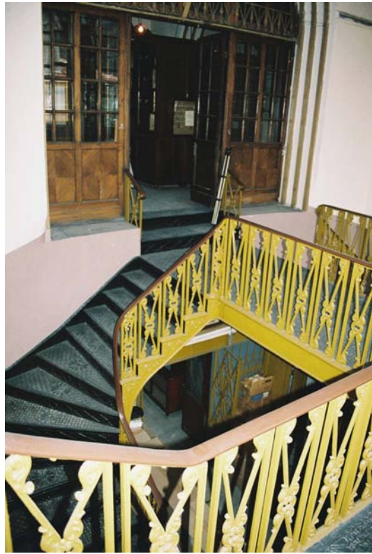
Resim 2.105 Hazine-i Evrak binası kat merdivenleri.
