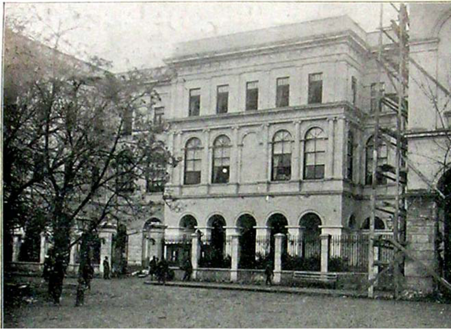
Resim 2.60 Darülfünun Binası Sultanahmet cephesi giriş (Şehbal, 1 Teşrin-i Sani 1325,15, s.289).
