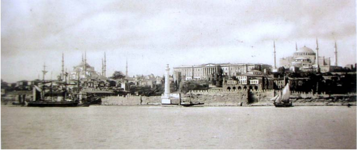
Resim 2.62 Darülfünun binası (Sarıöz, 1996, 37).
