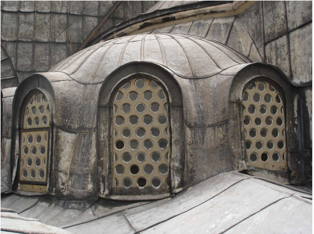
Resim 3.13 Kılıç Ali Paşa Camisi TR3 trompu dış görünüş
