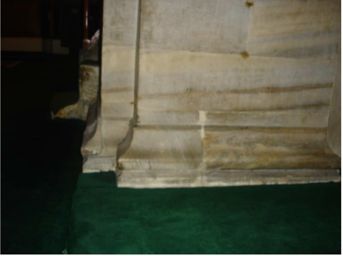
Resim 3.71 Kılıç Ali Paşa Camisi AY1 zemin kat pabuç detayı
