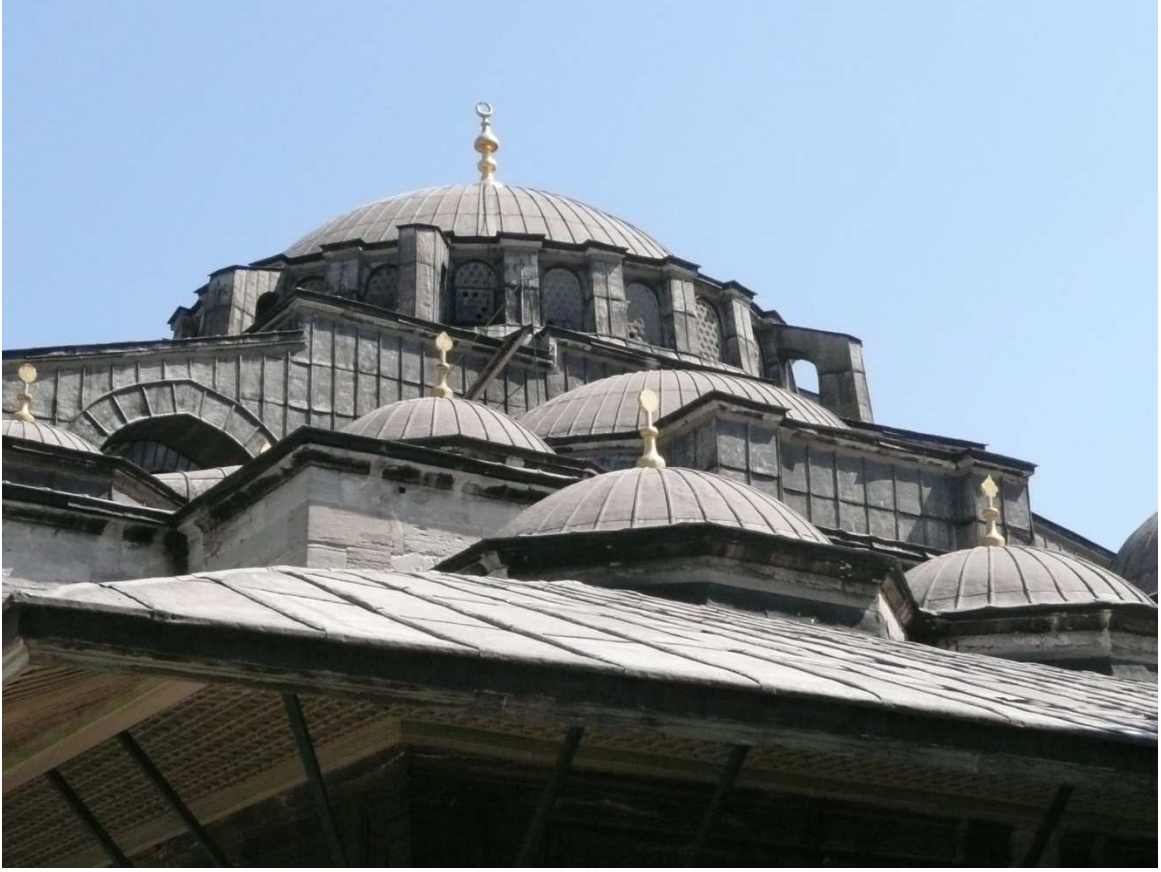
Resim 3.10 Kılıç Ali Paşa Camisi kuzey cephesi
