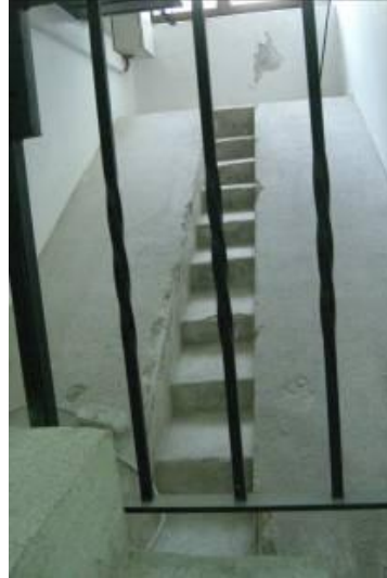
Şekil 5.46 Bodruma inen 5 no.lu su yolunun merdivenle kesişmesinden detay (H. Meriç Uğraş, 2008).
