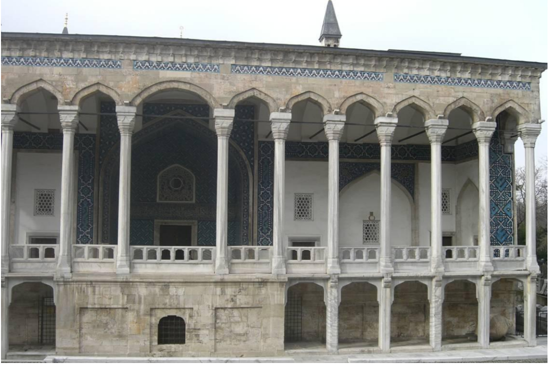
Şekil 5.23 Çinili Köşk'ün giriş eyvanı ve revaklı bölümdeki kemerler (H. Meriç Uğraş, 2009).
