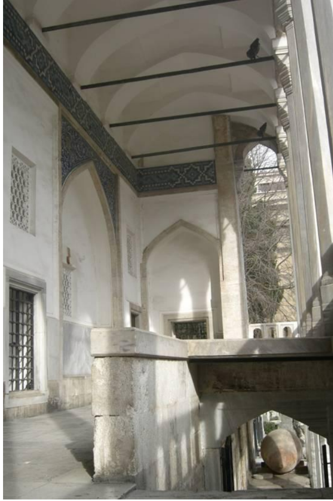
Şekil 5.65 Giriş merdiveni ve sahanlık (H. Meriç Uğraş, 2006).
