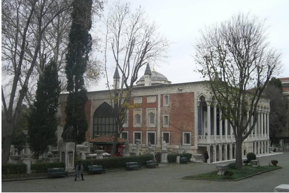
Şekil 5.1 Çinili Köşk genel görünüş (H. Meriç Uğraş, 2009).
