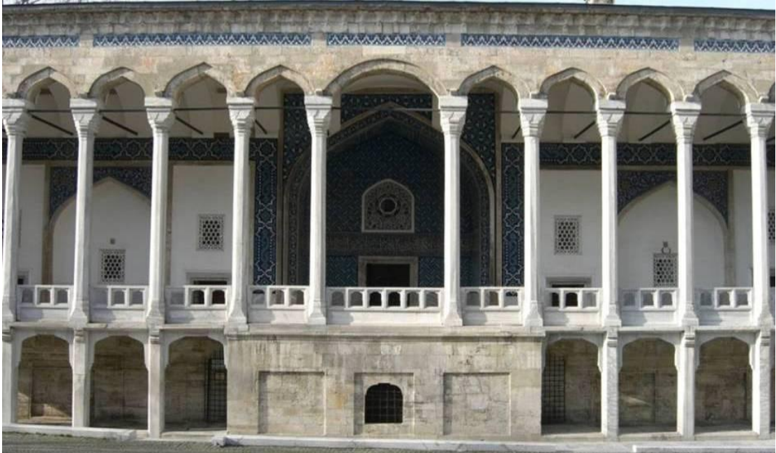
Şekil 5.72 Köşkün ön cephesindeki çiniler (H. Meriç Uğraş, 2006).
