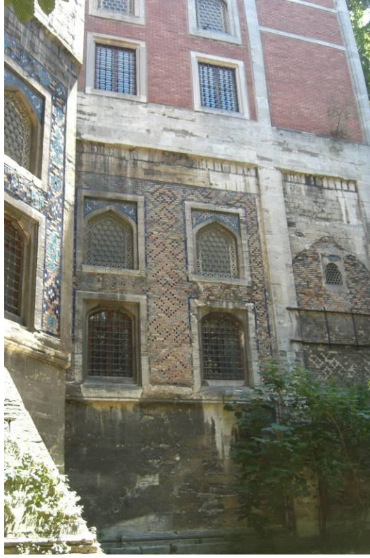
Şekil 5.73 Gülhane Parkı'na bakan arka cephedeki çiniler (H. Meriç Uğraş, 2008)
