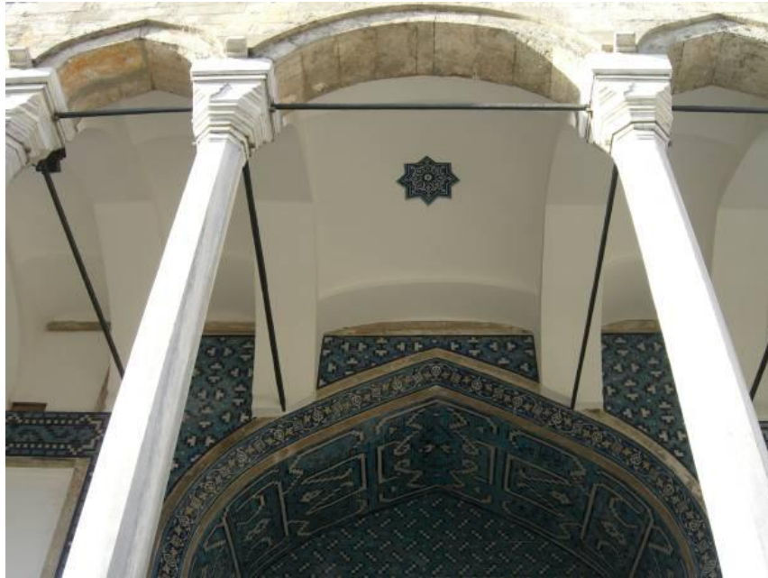
Şekil 5.61 Revak kemerinin giriş eyvanının çinileri ile birleşimi (H. Meriç Uğraş, 2006)
