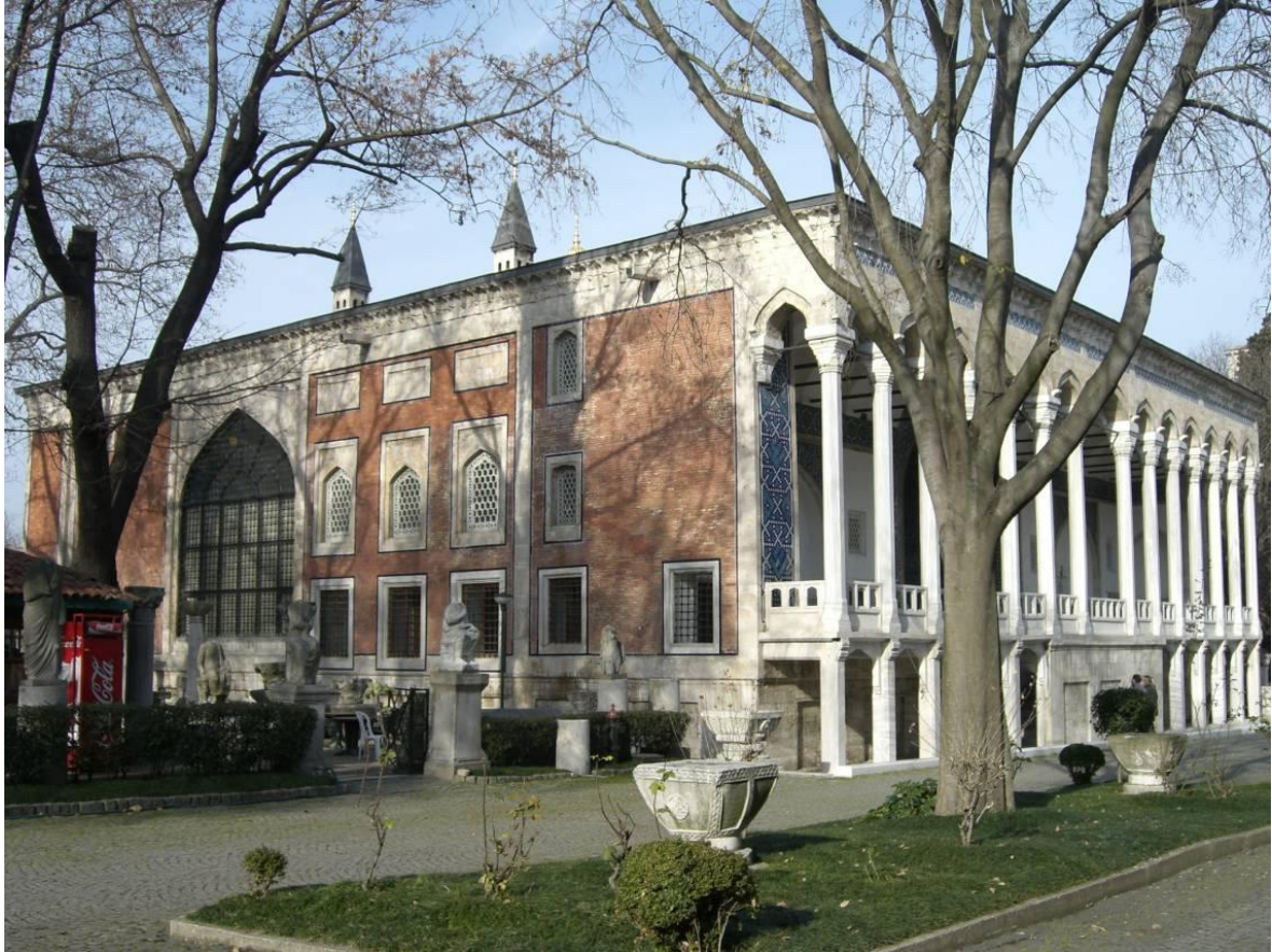
Şekil 5.67 Çinili Köşk'ün Şark Eserleri Müzesi'ne bakan cephesi (H.Meriç Uğraş, 2006).
