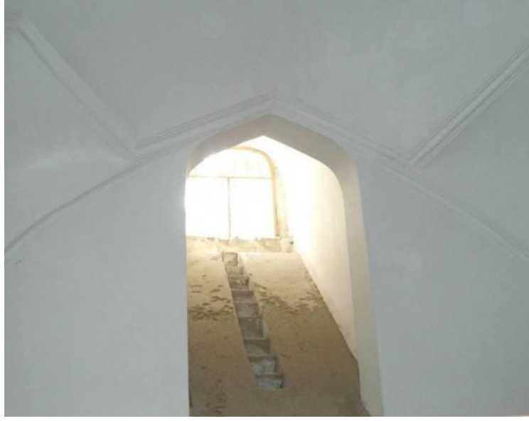
Şekil 5.52 Bodrum kattaki kademeli 2 no.lu su yolu (H. Meriç Uğraş, 2008).
