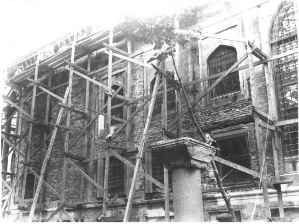
Şekil 5.91 1948-1951 yılları arasında yapılan restorasyon sırasında yenilenen yan cephe (Baha Tanman Arşivi).
