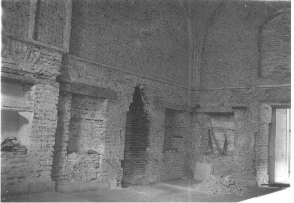
Şekil 5.117 1948-1951 arasındaki restorasyonda çini kaplamaları sökülmüş oda (Baha Tanman Arşivi).
