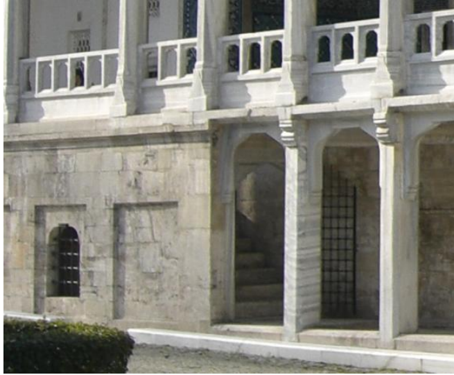
Şekil 5.59 Restorasyon sonrası merdivenin günümüzdeki hali (H. Meriç Uğraş, 2006).
