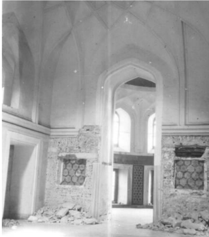
Şekil 5.116 1948-1951 yılları arasında yapılan restorasyon sırasında açılan nişlerdeki çiniler (Baha Tanman Arşivi)
