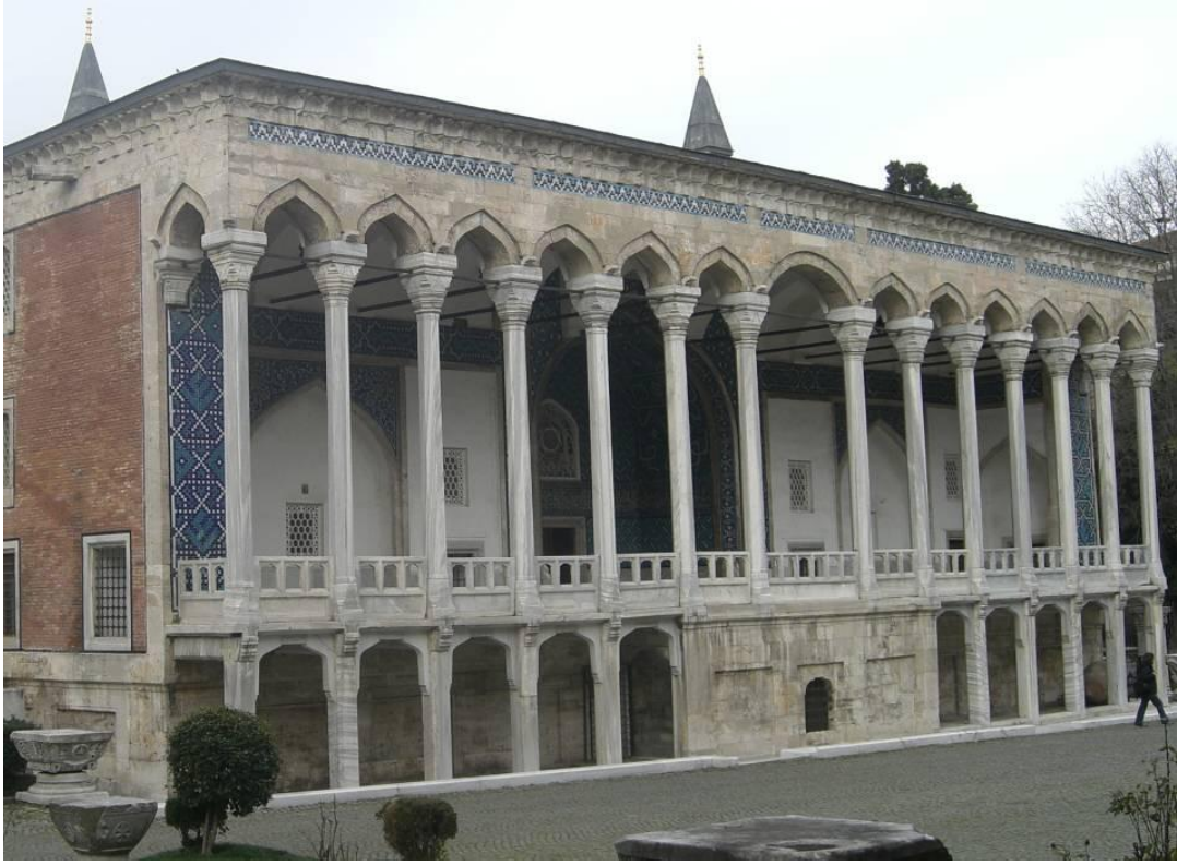
Şekil 5.60 Çinili Köşk'ün revaklı ön cephesi (H. Meriç Uğraş, 2009).
