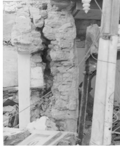
Şekil 4.2 Yığma taş duvarlar kesitinde oluşan hasarlar (Jagadish 2003)
