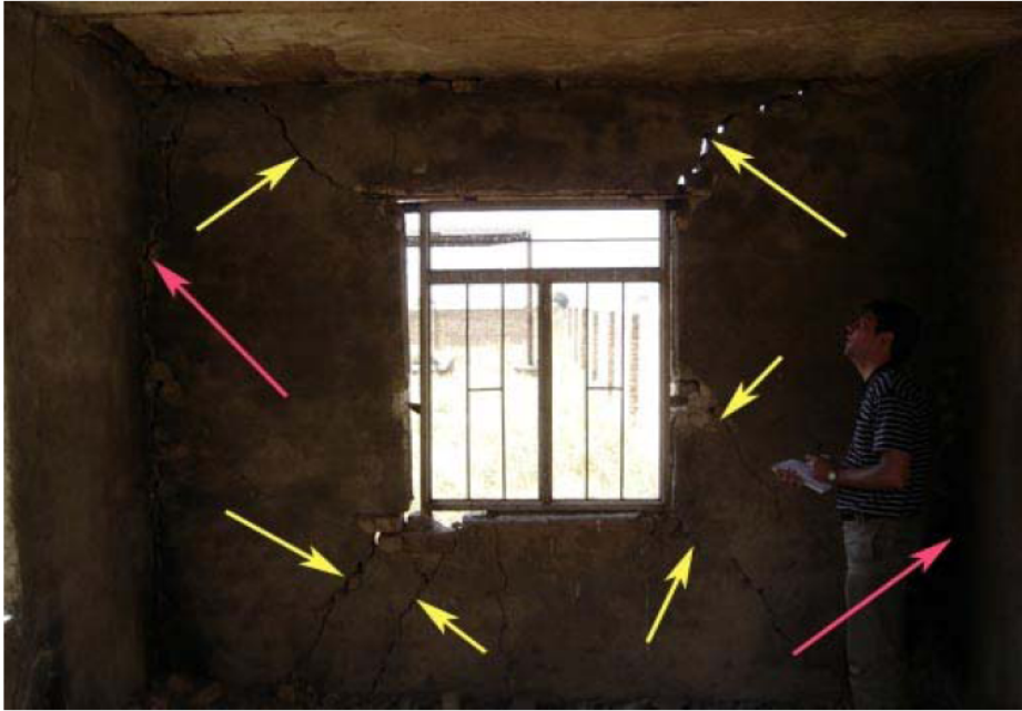
Şekil Ek 3.3 Duvar 3-T-2'ye ait fotoğraflar
