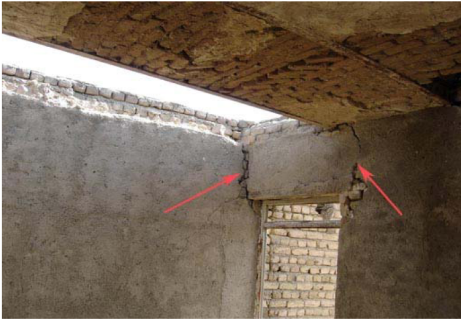
Şekil Ek 2.2 Duvar 3-T-1'e ait fotoğraflar
