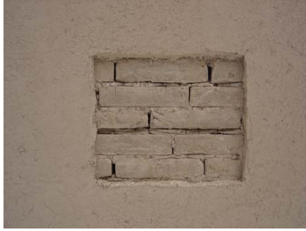
Şekil 3.19 Kerpiç bloklardan yapılmış ve yüzeyi balçıkla sıvanmış bir duvar örneği
