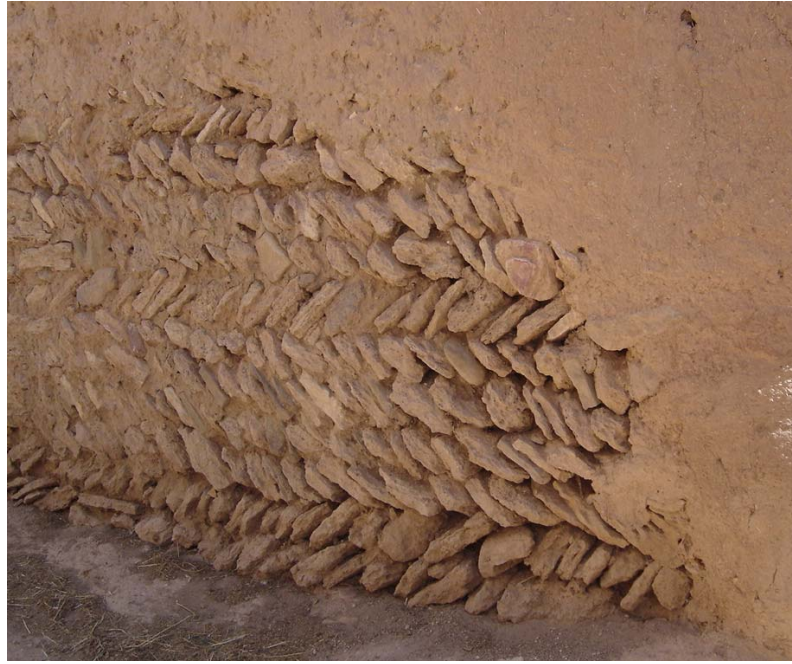
Şekil 3.24 Balıksırtı şeklinde örülmüş bir taş duvar örneği
