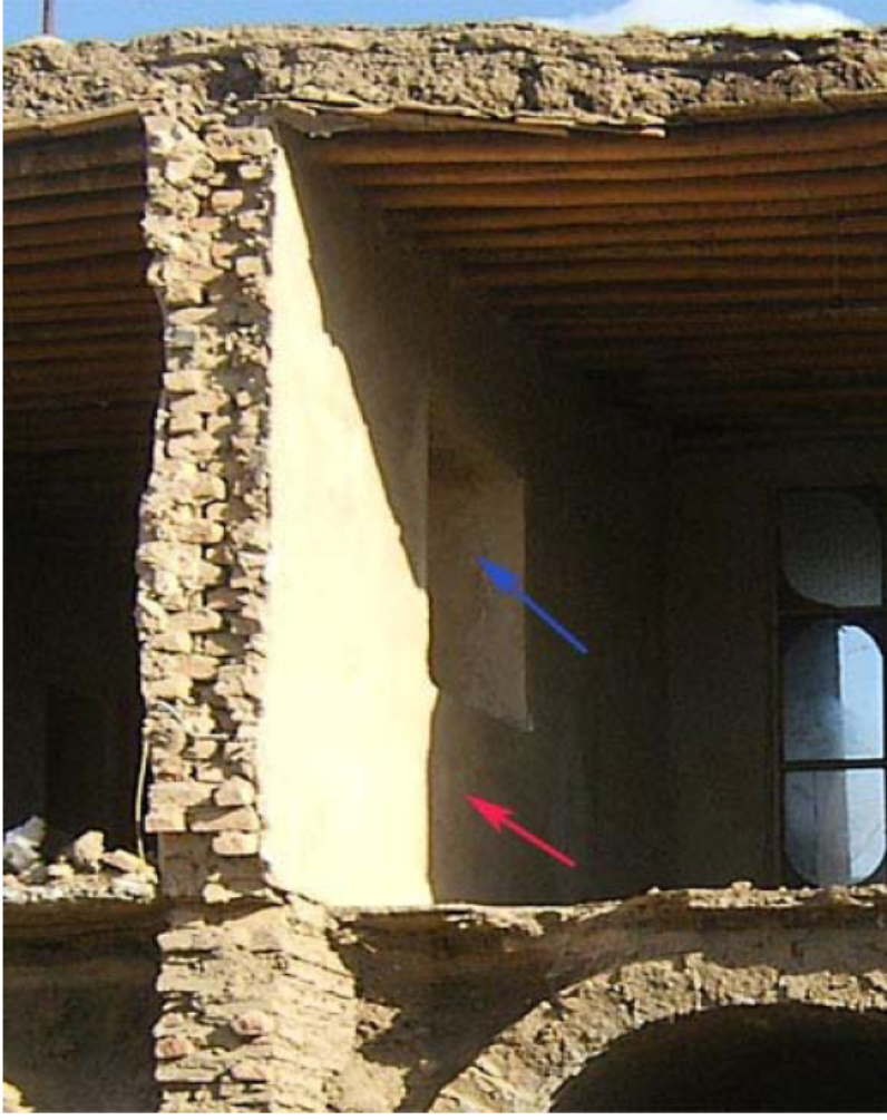
Şekil Ek 8.1 Duvar 12-T-1'e ait fotoğraf
