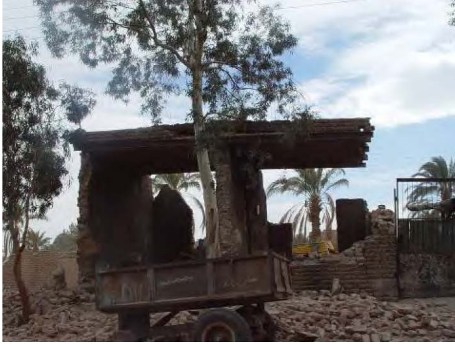
Şekil 4.31 Taşıyıcı duvarın yıkılmasına rağmen ayakta kalan tek parça bir çatı- Bam 2003 (Vaseghi 2003)
