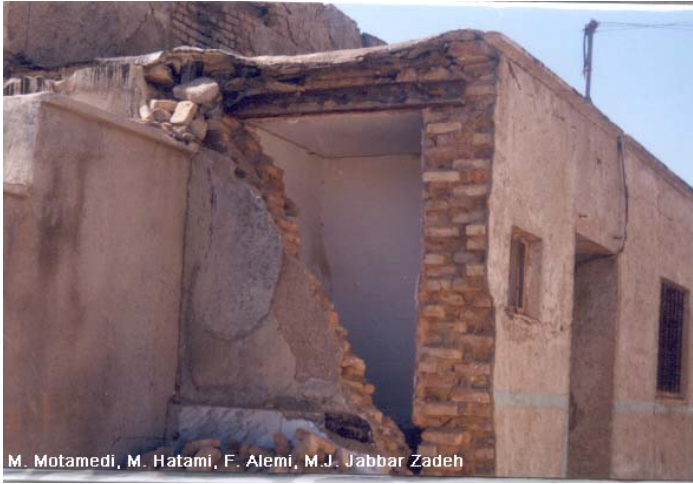
Şekil 4.30 Diyagonal ve düşey çatlakların bir arada oluşumundan kaynaklanan hasar- soldaki Qazvin 2002 - sağdaki Broojerd 2006 (IIEES arşivi)
