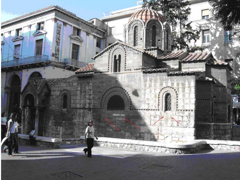
Şekil 4.21 Boşlukların alt kısmında oluşturulan düşey derzler – Atina 2004 (Arun)
