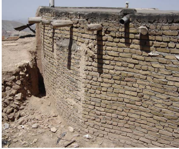
Şekil 3.20 Tuğladan yapılmış bir duvar örneği
