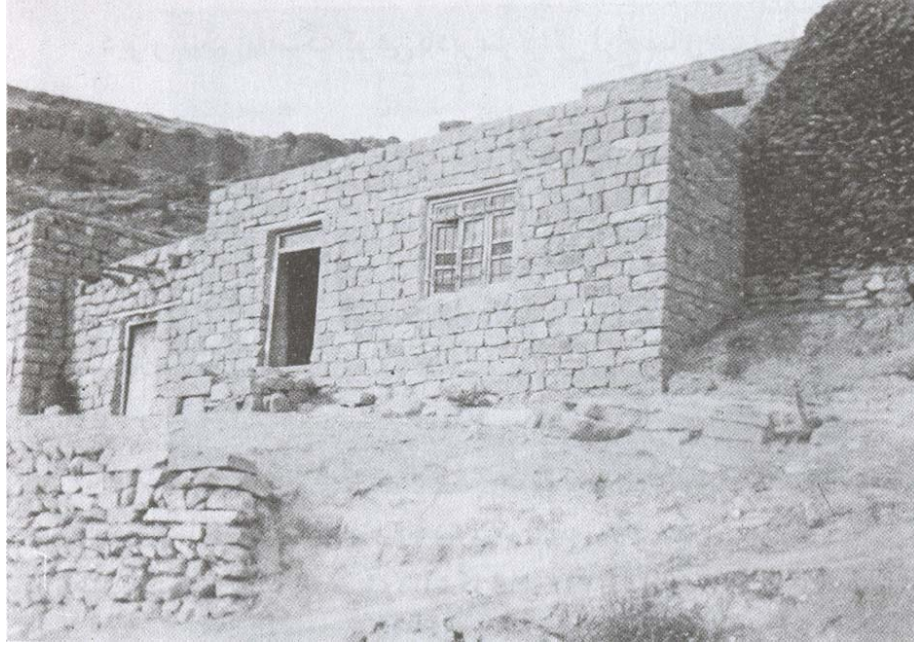
Şekil 3.23 Paralel derzli bir taş duvar örneği
