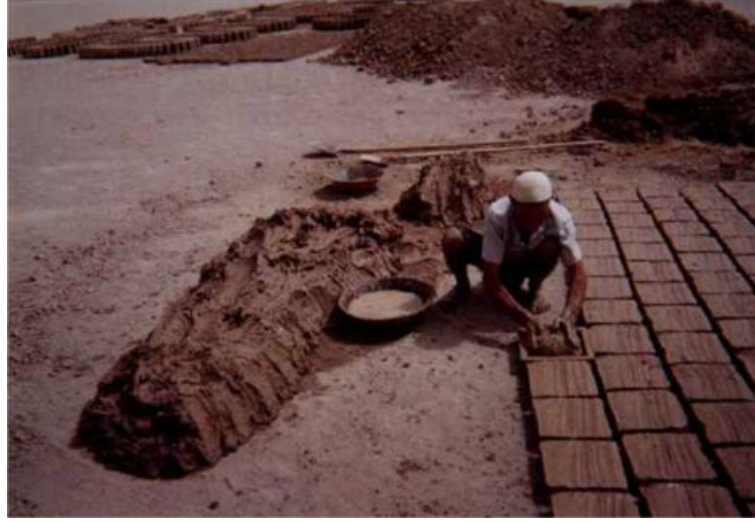
Şekil 3.11 Kerpiç blokların kalıplanma şekli
