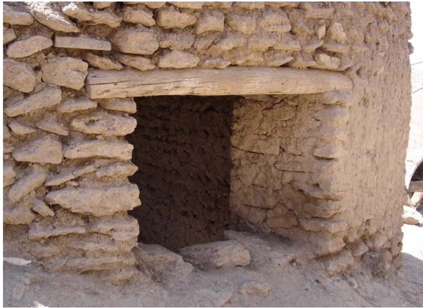
Şekil 3.16 Ahşap bir lento örneği
