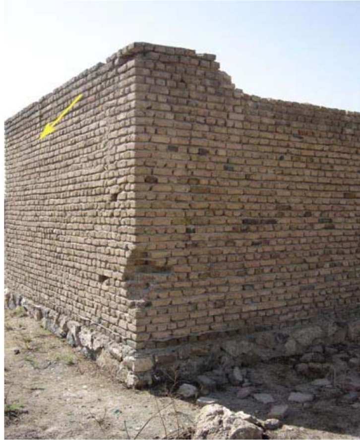
Şekil Ek 1.1 Duvar 1-T-2'ye ait fotoğraflar
