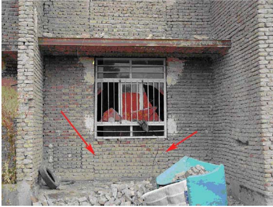
Şekil 4.20 Boşluğun alt kısmında oluşturulan düşey derz – Bam 2003 (IIEES arşivi)
