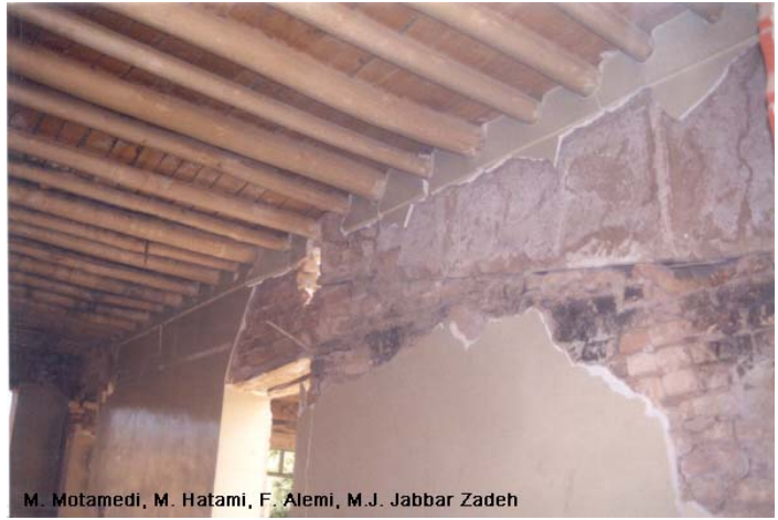
Şekil 4.34 Duvarın üst kısmında çatı ağırlığından kaynaklanan kesme çatlakları – soldaki Northridge 1994 (Leroy Tolles 1996)- sağdaki Changhure 2002 (IIIES arşivi)
