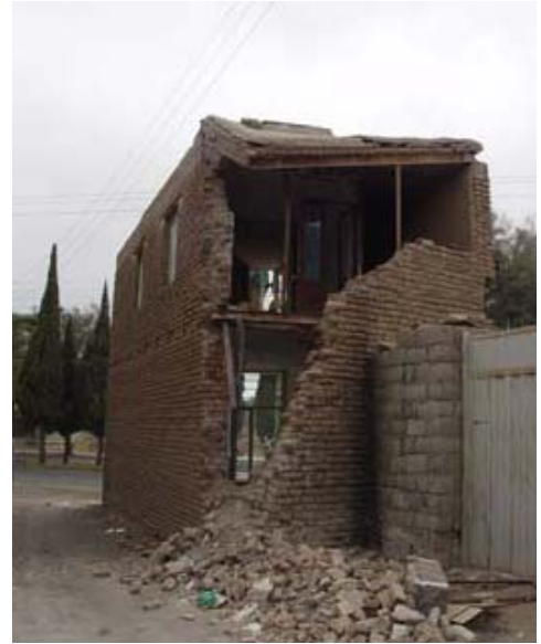
Şekil 4.30 Diyagonal ve düşey çatlakların bir arada oluşumundan kaynaklanan hasar- soldaki Qazvin 2002 - sağdaki Broojerd 2006 (IIEES arşivi)
