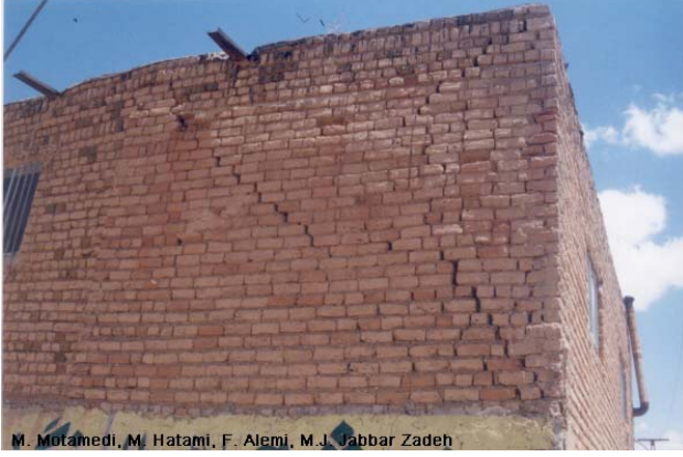
Şekil 4.28 Köşede oluşan diyagonal çatlak- soldaki Changhure 2002 - sağdaki Darb Astane 2006 (IIEES arşivi)
