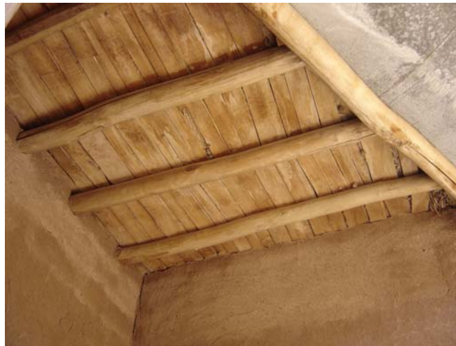
Şekil 6.8 Kiriş aralarını örten tahta parçalarının doğrudan duvar üzerine oturtulduğu bir çatı
