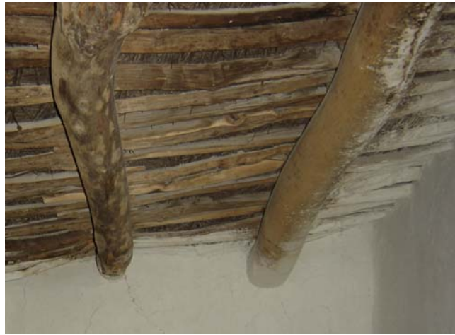
Şekil 3.14 Bir köy evinin ahşap çatı strüktürü
