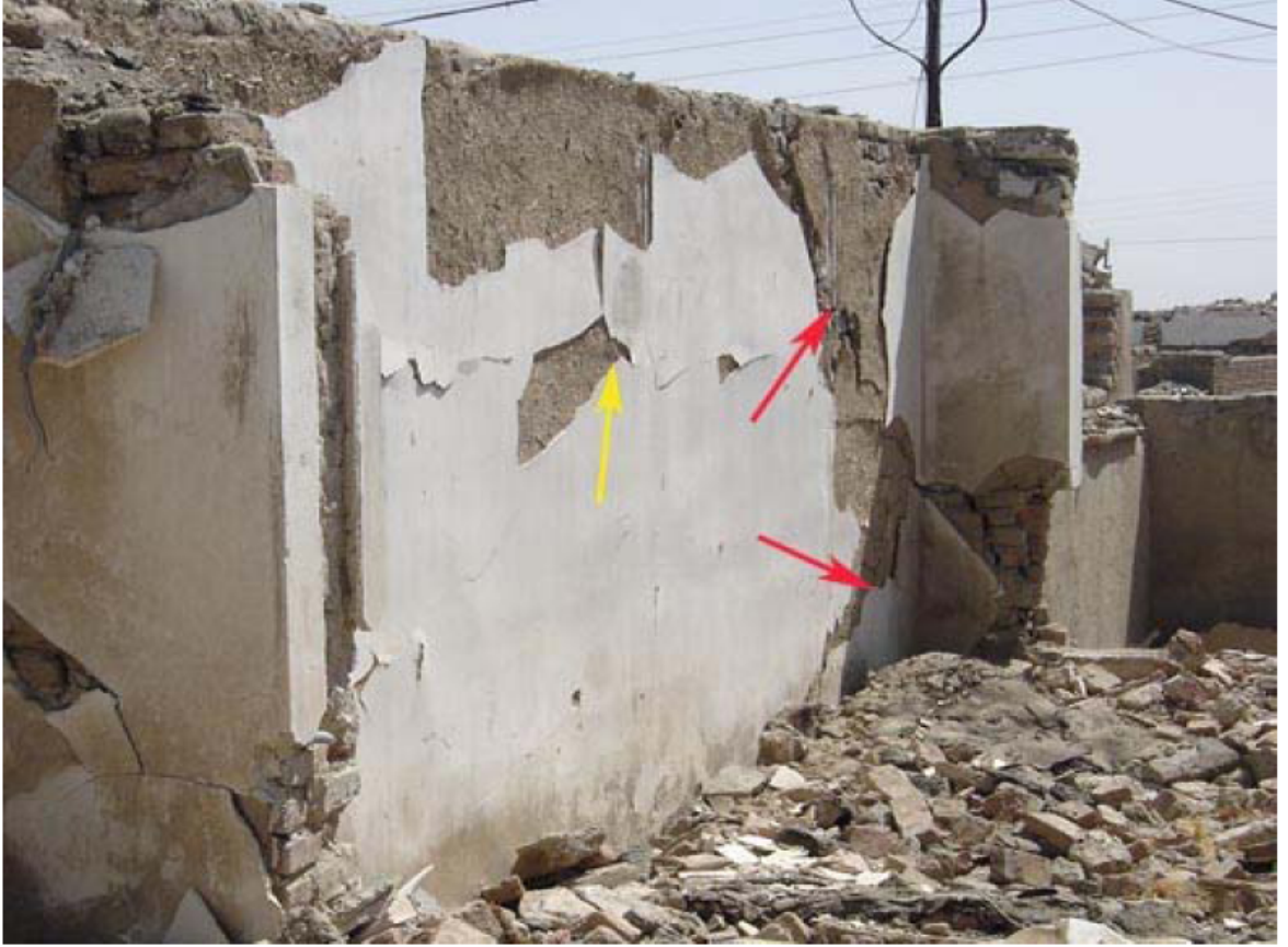
Şekil Ek 6.1 Duvar 6-T-10'a ait fotoğraf
