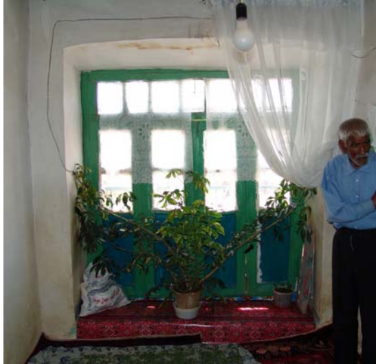
Şekil 6.4 Boşluk oranının büyük olduğu örnek bir duvar
