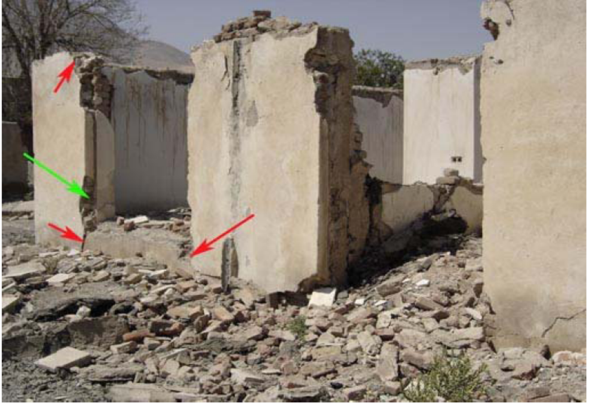
Şekil Ek 5.1 Duvar 6-T-7'e ait fotoğraf
