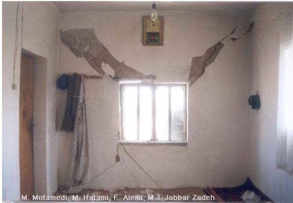
Şekil 4.19 Boşluk köşelerinde oluşan çatlaklar – Qazvin 2002 (IIEES arşivi)
