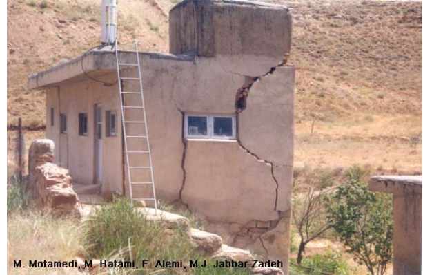
Şekil 4.19 Boşluk köşelerinde oluşan çatlaklar – Qazvin 2002 (IIEES arşivi)
