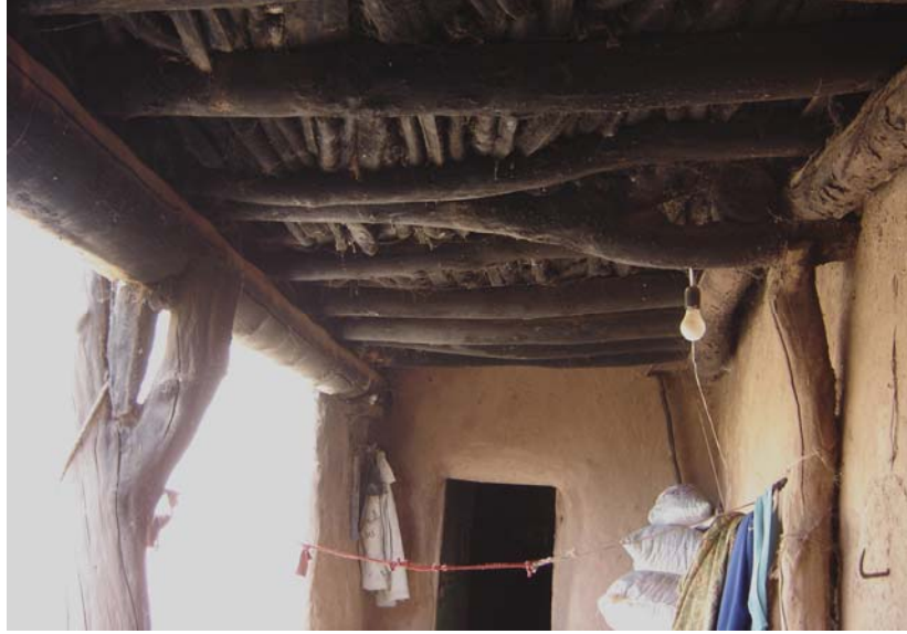
Şekil 3.25 Ahşap bir kolon ve kirişin hiçbir şey kullanılmadan bağlanma örneği
