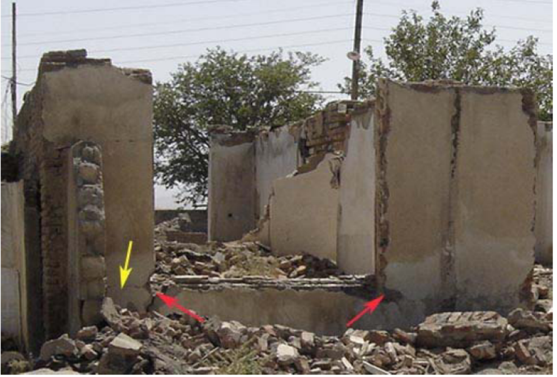
Şekil Ek 4.1 Duvar 6-T-1'e ait fotoğraf
