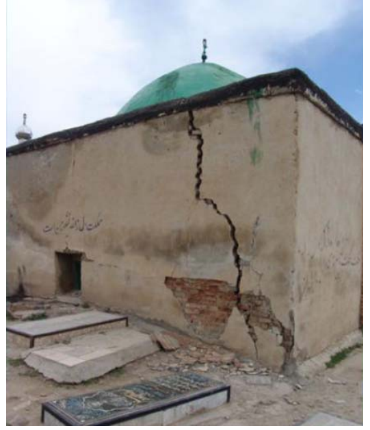
Şekil 4.28 Köşede oluşan diyagonal çatlak- soldaki Changhure 2002 - sağdaki Darb Astane 2006 (IIEES arşivi)
