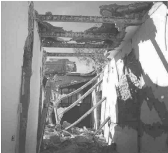
Şekil 4.32 Çatıda oluşan hasarlar- Bam 2003 (Vaseghi 2003)
