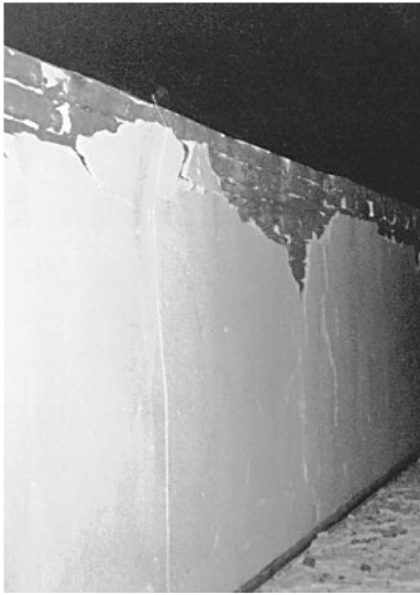
Şekil 4.34 Duvarın üst kısmında çatı ağırlığından kaynaklanan kesme çatlakları – soldaki Northridge 1994 (Leroy Tolles 1996)- sağdaki Changhure 2002 (IIIES arşivi)
