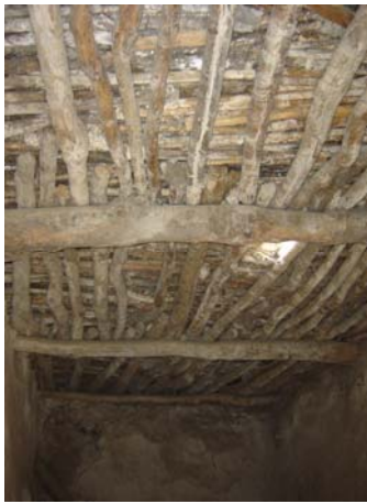
Şekil 3.28 Kırsal bölgedeki köy konutlarında döşeme ve çatı örnekleri
