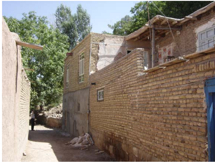
Şekil 3.13 Zunuzag köyünde bulunan bir tuğla bina
