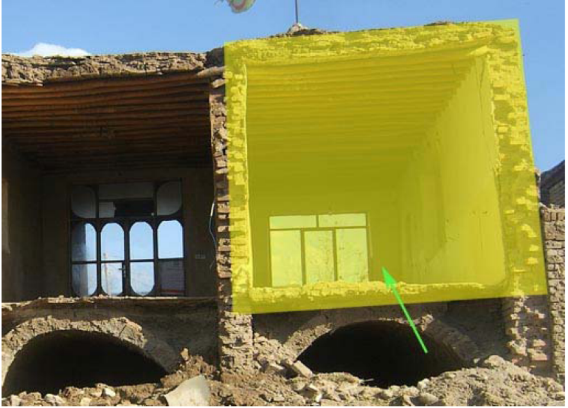
Şekil Ek 7.1 Duvar 12-T-1'e ait fotoğraf
