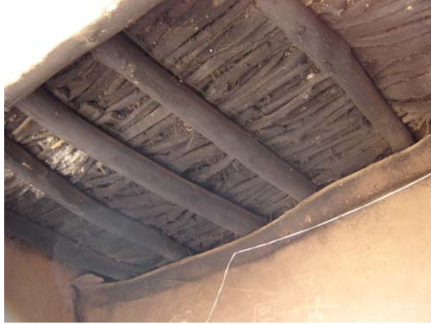
Şekil 3.28 Kırsal bölgedeki köy konutlarında döşeme ve çatı örnekleri
