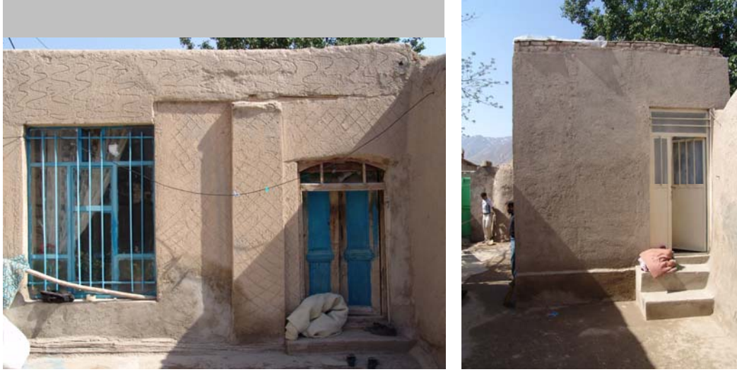
Şekil 6.5 Kapı boşluklarının köşeye yakın olduğu örnekler
