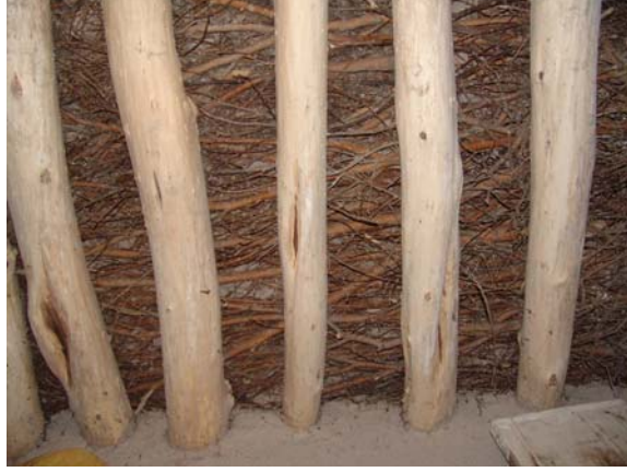
Şekil 6.7 Ahşap kirişlerle herhangi bir bağlantısı olmayan çubuklarla örtülmüş bir çatı örneği
