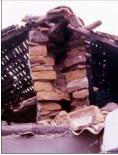
Şekil 4.2 Yığma taş duvarlar kesitinde oluşan hasarlar (Jagadish 2003)
