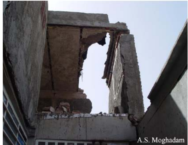
Şekil 4.32 Çatıda oluşan hasarlar- Bam 2003 (Vaseghi 2003)
