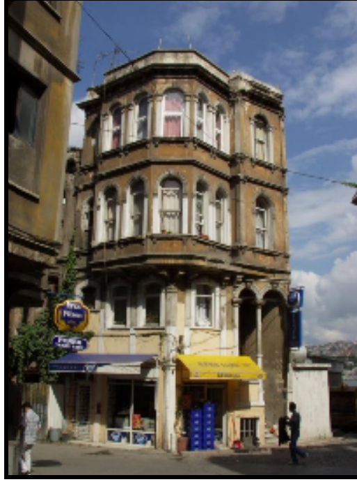
Şekil 5.6 Restorasyon öncesi görünüm, [32]
