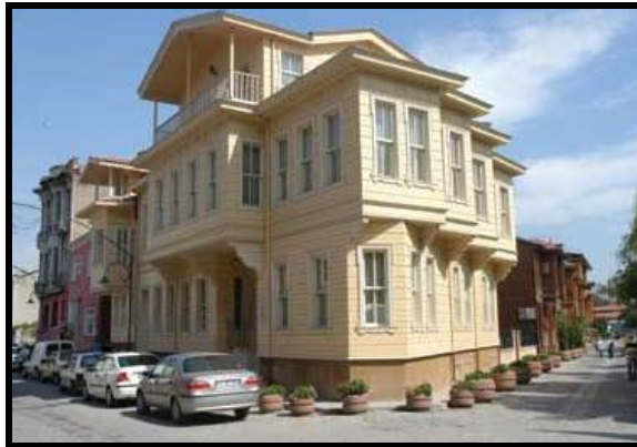
Şekil 4.18 Aynı evin restorasyon sonrası görünümü, [13]
