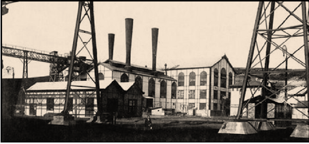
Şekil 5.12 1930'larda Silahtarağa Elektrik Santrali, [35]
