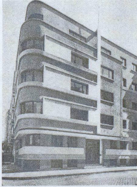
Şekil 5.1.2.2.1 Ayhan Apartmanı’nın yapıldığı yıllardaki özgün cephe düzeni (Arkan, 1939:103)
