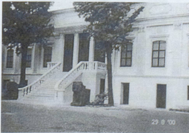
Şekil 5.1.2.1.2 Nezh Eldem'in tasarımı olan ve yıkılan giriş mekânı (KTVKKBK arşivi).
