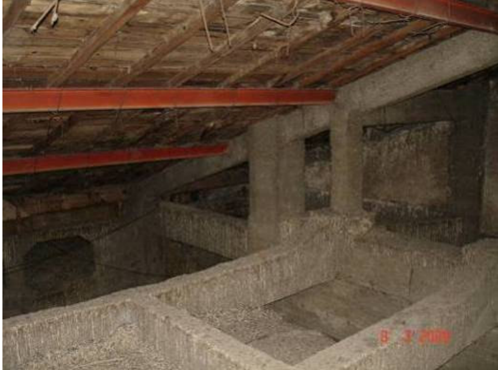
Şekil 4.1.103 Süreyya Sineması betonarme çatı konstrüksiyonu (Cafer Bozkurt ofisi arşivi)
