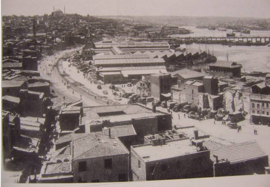
Şekil 4.1.16 Eminönü Meydanı Eminönü Gümrük binası , Antrepo ve depolar yıkım öncesini gösterir bir fotoğraf (Tütel,E.2000)
