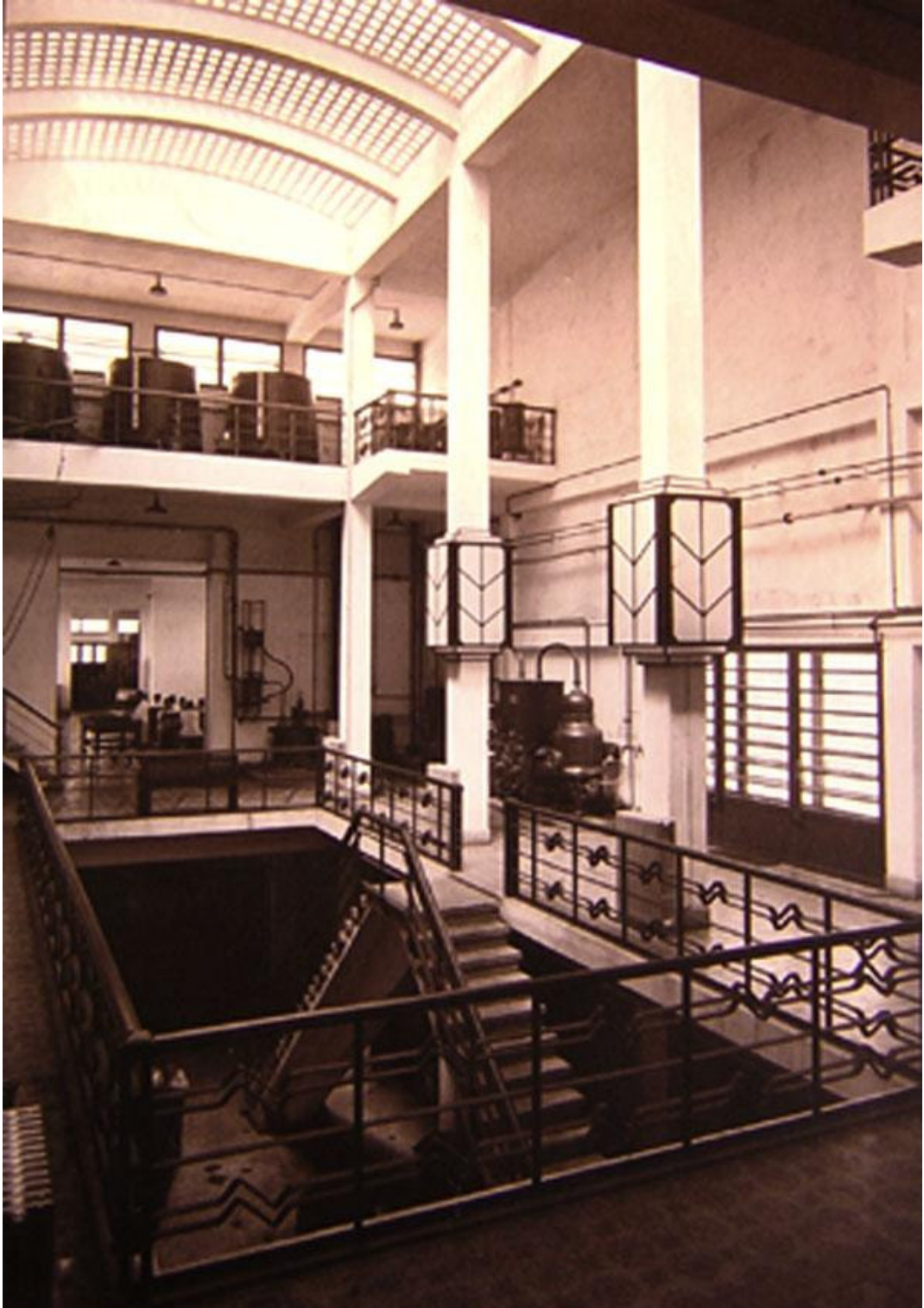
Şekil 4.1.114 Mecidiyeköy Tekel Likör Fabrikası ana bina orta galeriden bakış,kolon ve tavan kirişleri görülmektedir. 1930'lar (Tekel inşaat ve tesisler Dairesi Başkanlığı arşivi,2008)
