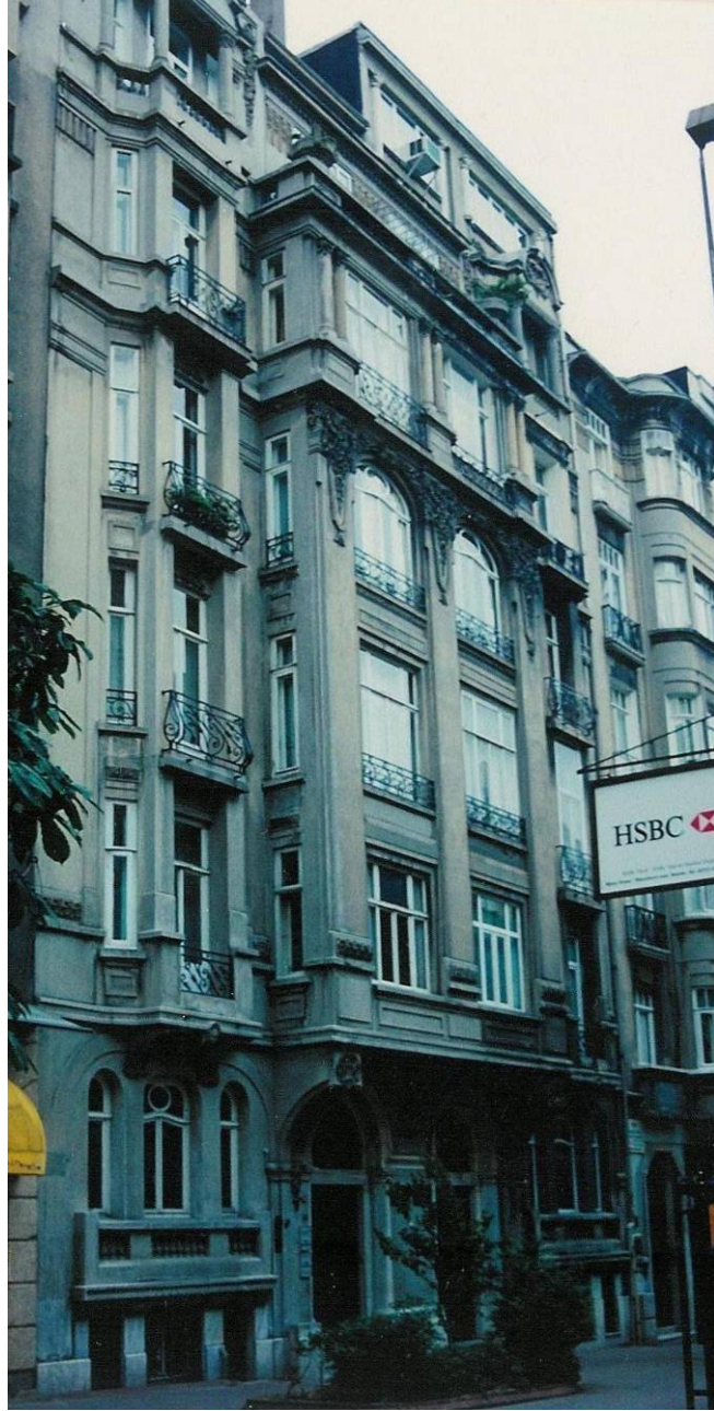
Şekil 4.2.11 Sümer Apartmanı 1928, (fotoğraf:Uzun,B.,2000)
