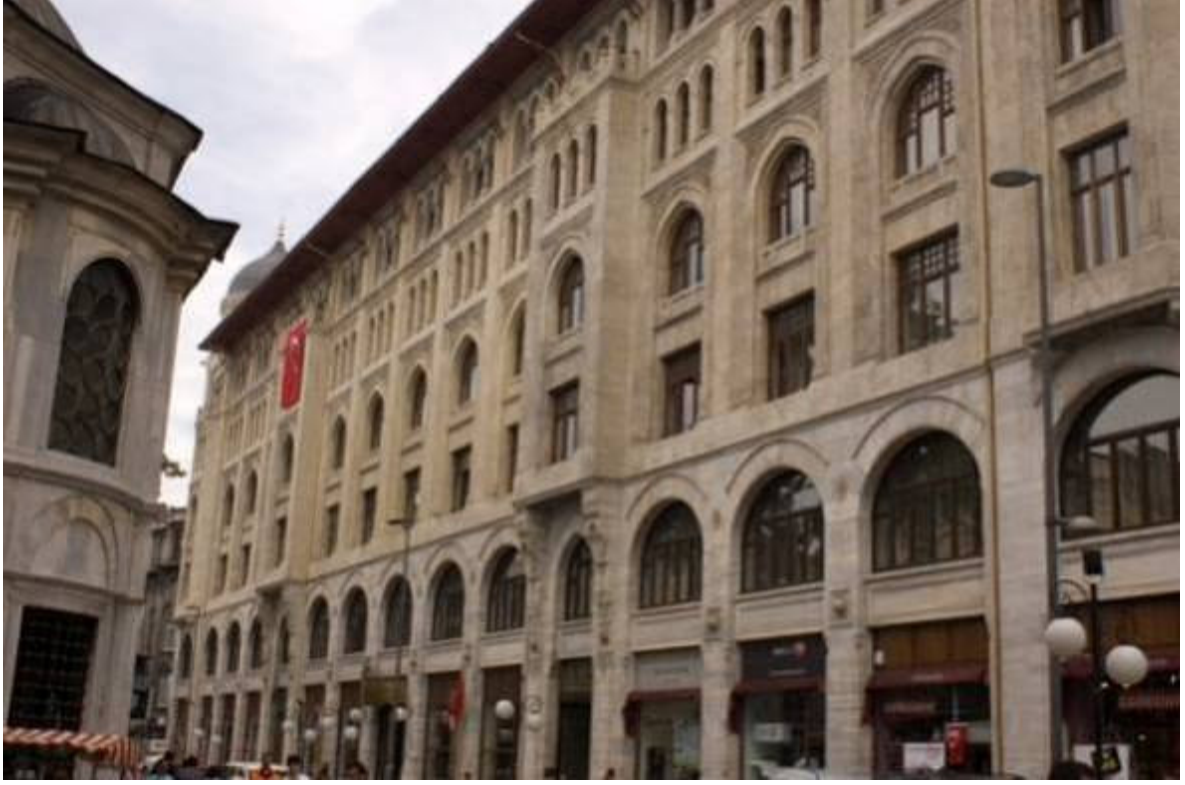
Şekil 4.1.39 IV.Vakıf Han Giriş cephesi, (fotoğraf: Uzun,T., 2007)
