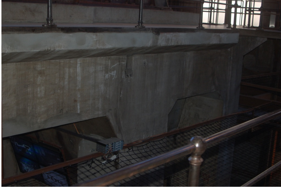
Şekil 4.1.35 Silahtarğa Elektrik Santrali 1-2 nolu makina dairesi ve 1-2 nolu kazan dairelerinde betonarme fil ayaklar gusseler ve betonarme platform üzerinde taşınan kazanlar çeşitli açılardan fotoğraflar , T.Uzun 2008
