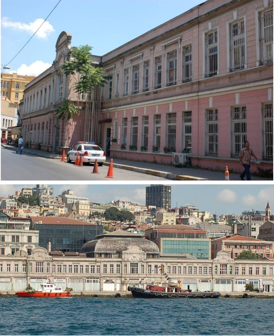
Şekil 4.1.10 Karaköy Gümrük depoları cadde ve deniz cephesi (fotoğraf: Uzun,T., 2007)
