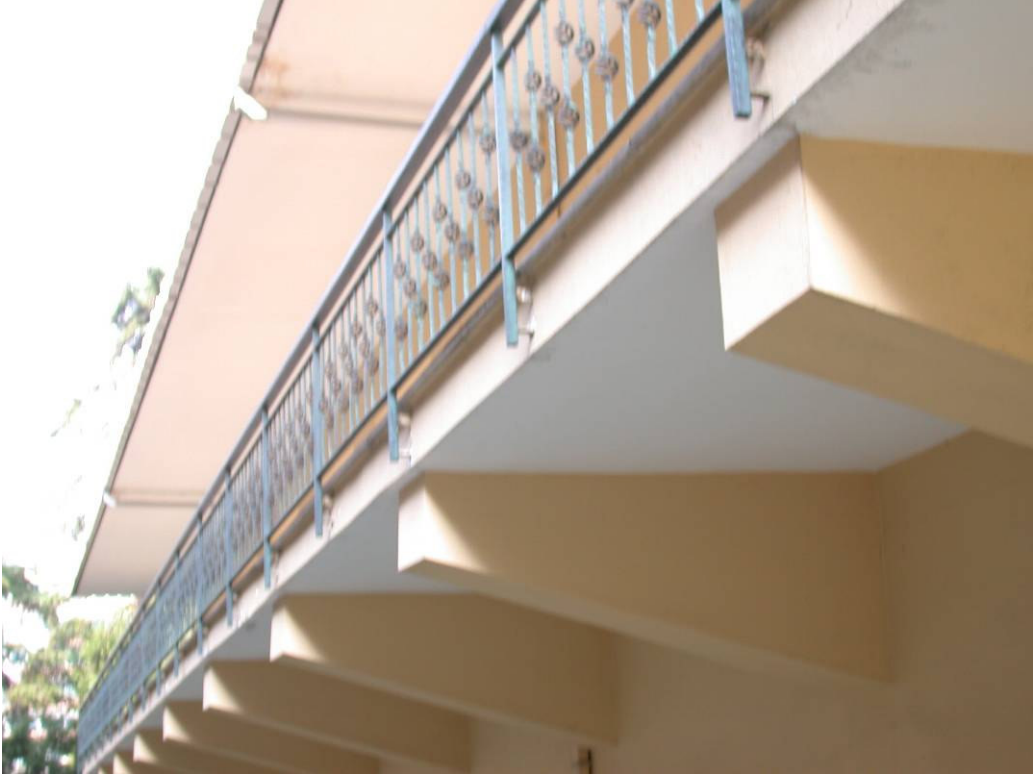
Şekil 4.1.115 Tekel Likör Fabrikası ana bina gusse detayı (fotoğraf: Uzun,T., 2007)
