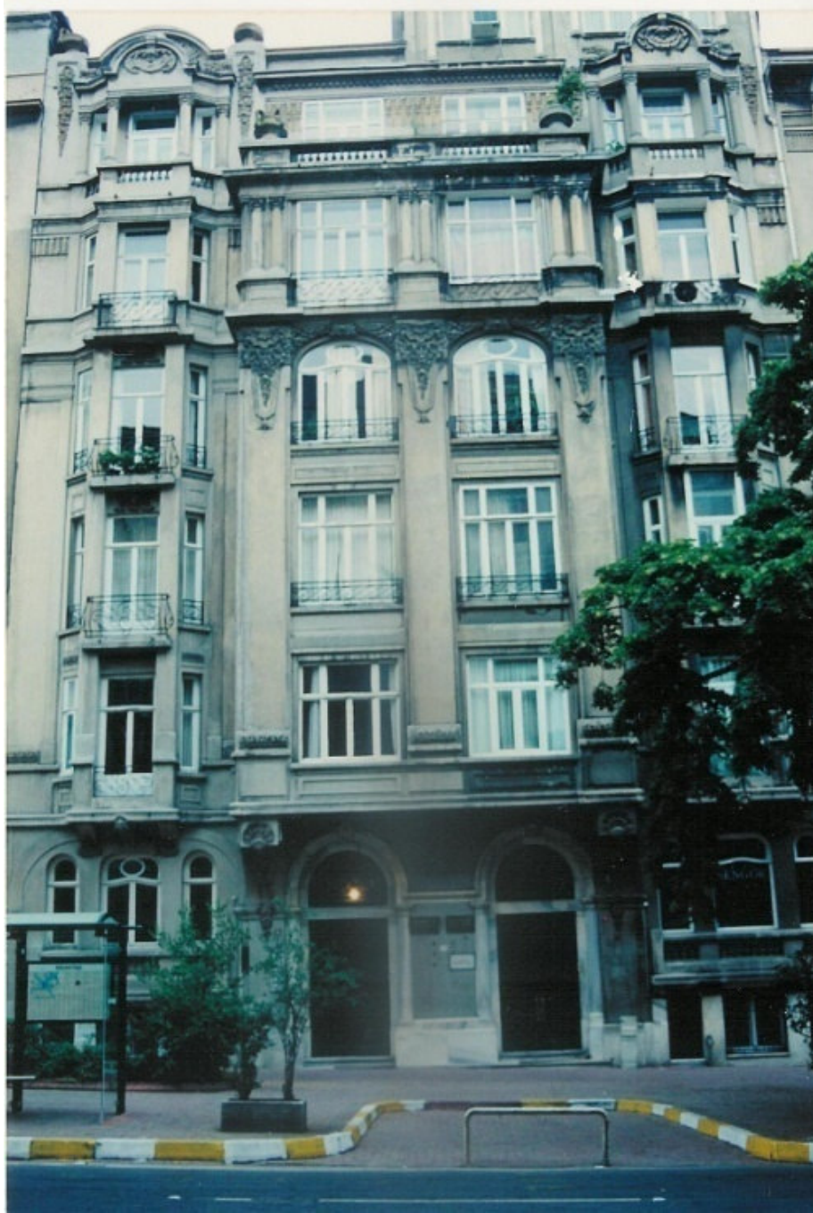
Şekil 4.2.10 Sümer Apartmanı 1928, Giriş kat HSBC Nişantaşı şubesi, (fotoğraf:Uzun,B., 2000)
