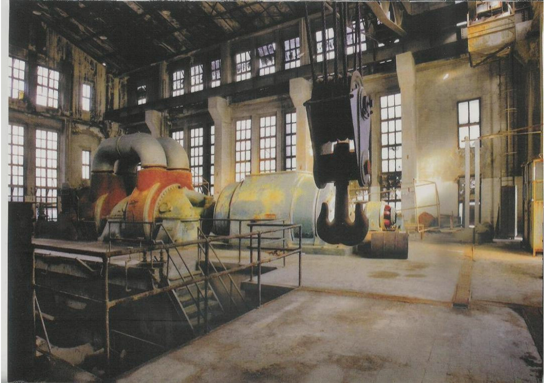
Şekil 4.1.34 Silahtarğa Elektrik Santrali kazan dairesi içinden betonarme gusseli kolonlar görülmektedir. (Bilgi Üniversitesi,Santral özel arşivi,2008)
