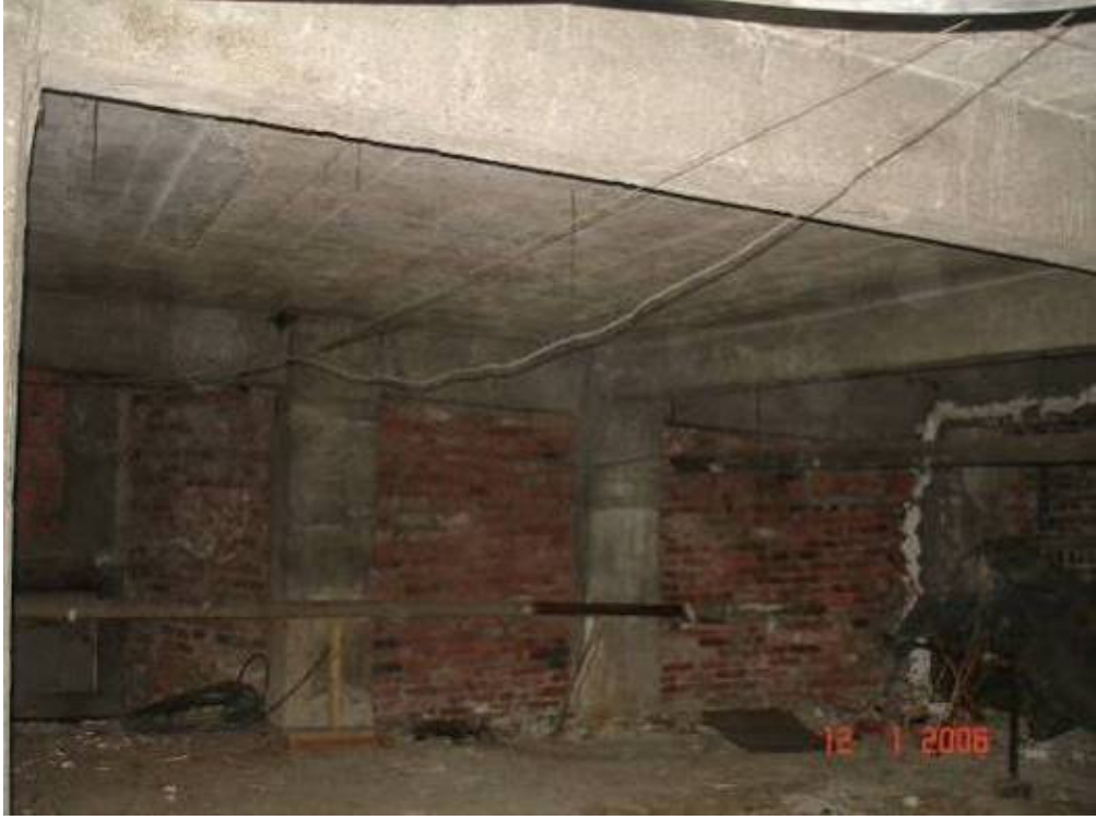
Şekil 4.1.102 Süreyya Sineması bodrum kat betonarme kolonları (Cafer Bozkurt ofisi arşivi)
