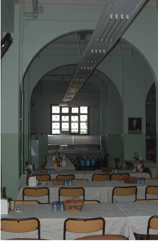
Şekil 4.1.9 Karaköy Gümrük (Rusumat) binası giriş yemekhane katında betonarme kolonlar,kemerli geçişler ve üçgen gusseleri gösteren çeşitli fotoğraflar (Uzun,T.,2008)
