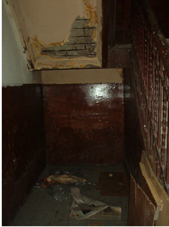
Şekil 4.1.38 Silahtarağa Elektrik Santrali merdiven döşemesinde görülen donatılar (Fotoğraf: Köksal, G. 2005)
