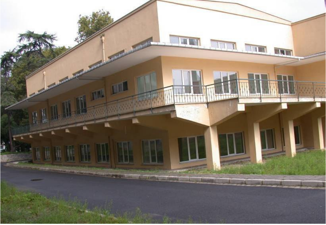
Şekil 4.1.117 Mecidiyeköy, Tekel Likör Fabrikası iç avludan görünüş betonarme gusselere yakından bakış, (fotoğraf:Uzun,T.,2005)
