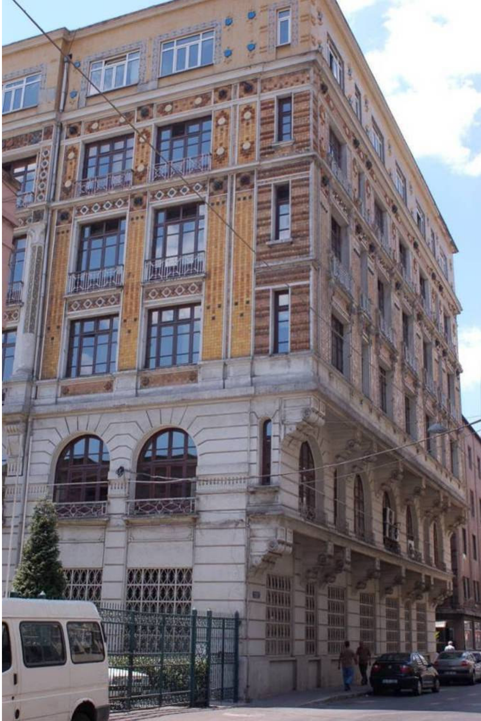
Şekil 4.1.8 Erken betonarme örneklerinden Karaköy Rusumat (Gümrük ) binası cadde cephesi günümüz Gümrük Muhafaza Baş Müdürlüğü (fotoğraf: Uzun,T.,2007)
