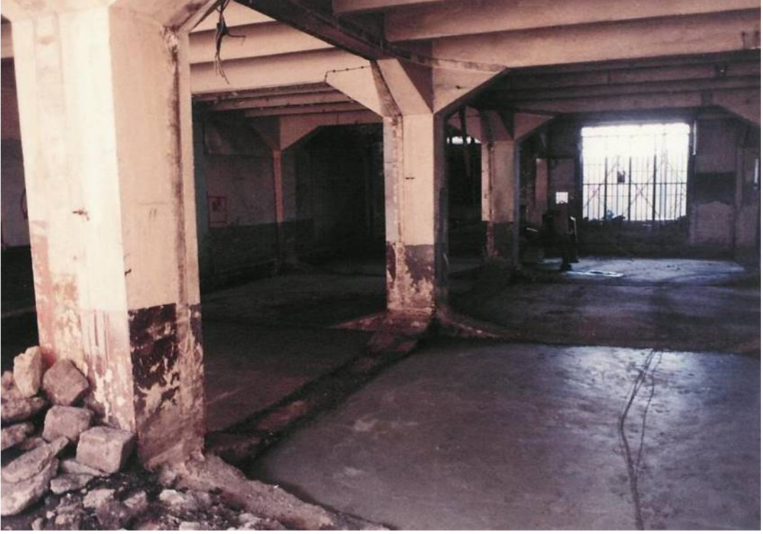
Şekil 4.1.20 Eski Halı ve Manifatura Antreposu No: 13 ( şimdiki Ticaret Odası) kolon – kiriş ilişkisi, ve gusseler görülmektedir. (Ticaret Odası restorasyonundan, İTO arşivi)
