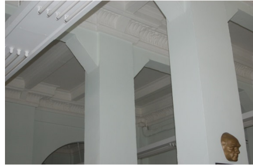
Şekil 4.1.9 Karaköy Gümrük (Rusumat) binası giriş yemekhane katında betonarme kolonlar,kemerli geçişler ve üçgen gusseleri gösteren çeşitli fotoğraflar (Uzun,T.,2008)
