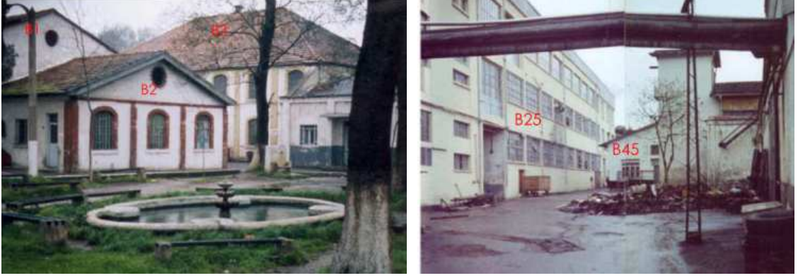
Şekil 3.17 ve Şekil 3.18 Beykoz Debbaghane-i Âmire’deki marangozhane (B 1), kalıp atölyesi (B 2), lastik işletmesi (B 3); deri işletmesi (B 25 ve B 45), 2006 (Tolga, 2006)
