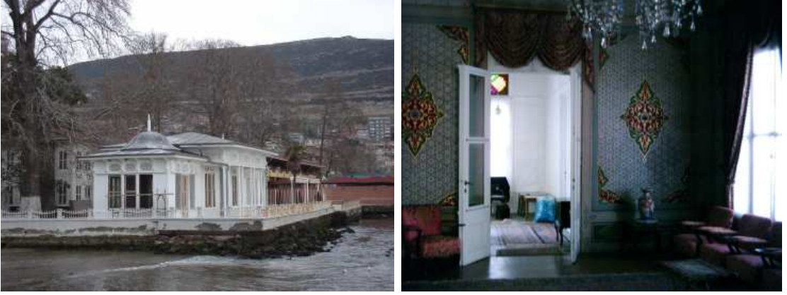
Şekil 3.84 ve Şekil 3.85 Beyaz Köşk'ün güneydoğu cephesi ve ana mekanı (Nevra Ertürk Arşivi, 2007; Aydın ve Utkaner, 2006)
