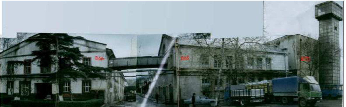
Şekil 3.19 Beykoz Debbaghane-i Âmire’deki itfaiye, ambar (B 66) ve kundura işletmesi binaları (B 70), 2006 (Tolga, 2006)
