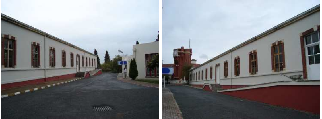
Şekil 3.110 ve 3.111 Yıldız Çini Fabrika-i Hümayunu'nun işletme binasının güney cephesi ve doğu kanadı (Nevra Ertürk Arşivi, 2007)
