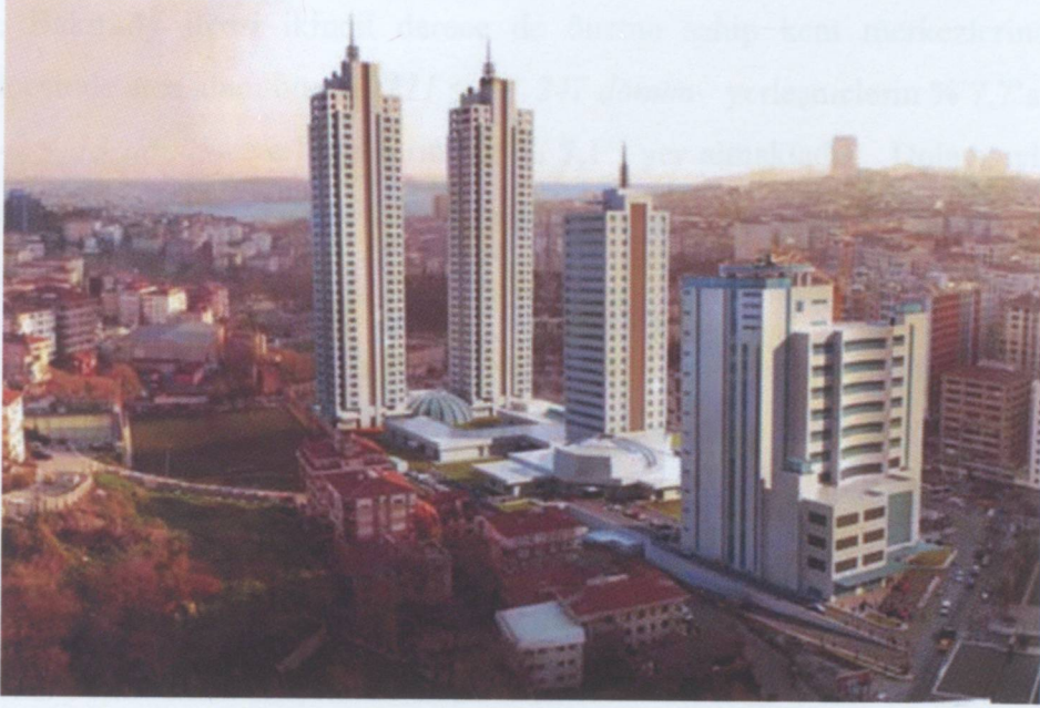
Şekil 7.1. Şişli ilçesinin Fulya mahallesinde yer alan 42 dönüm arsa alanına sahip (orta küçük) Selenium Twins Yerleşmesi ( www.ascioğlu.com )
