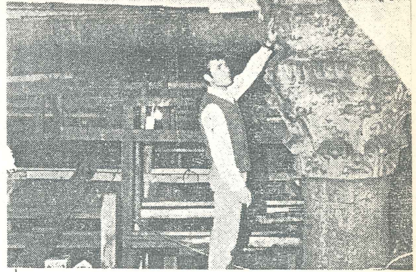
Yerebatan Sarayı'nın delinerek sarnıcı içine atılan temellerden birini inşa
