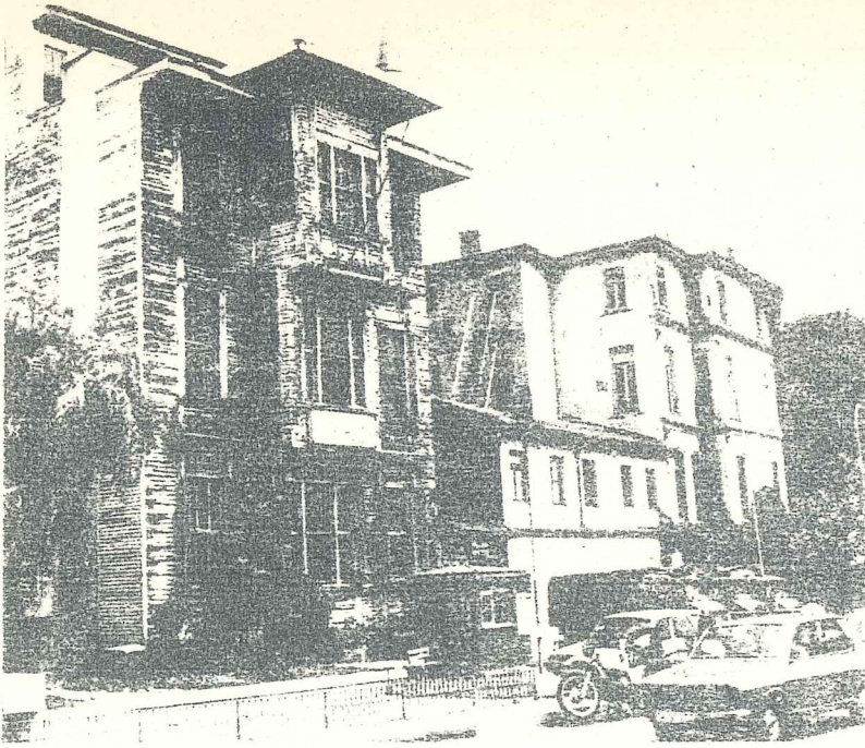
1./Kasım 1984'de yıkılan ahşap konak, Ekim 1984
