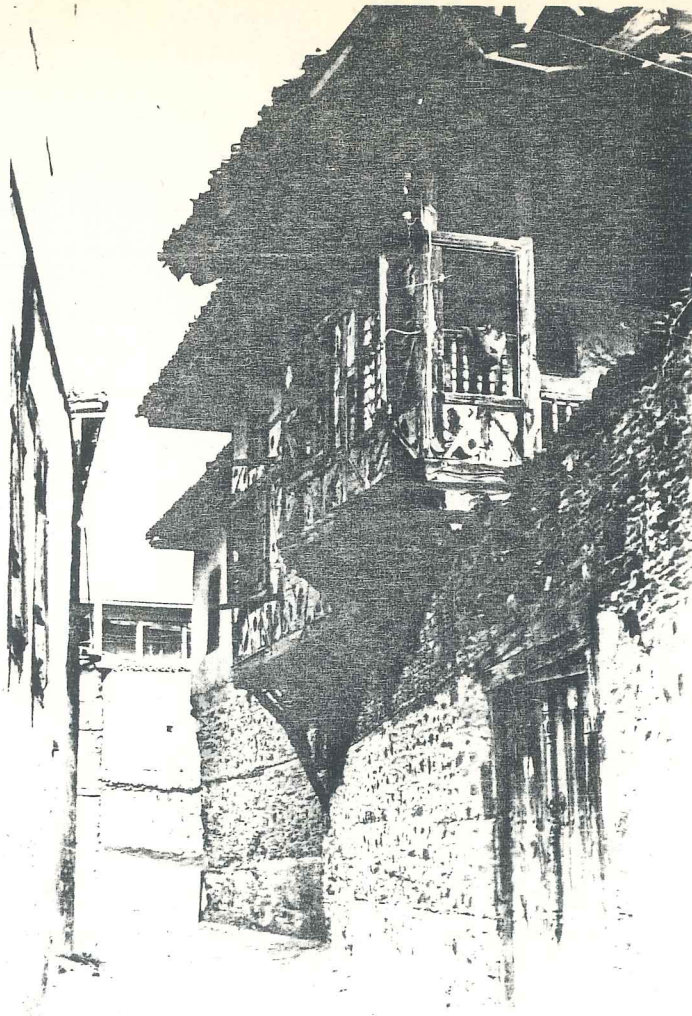
RESİM 7-Harım Meydanı Ramazan Bilmez Evi, 73. sokak görünüşü.
