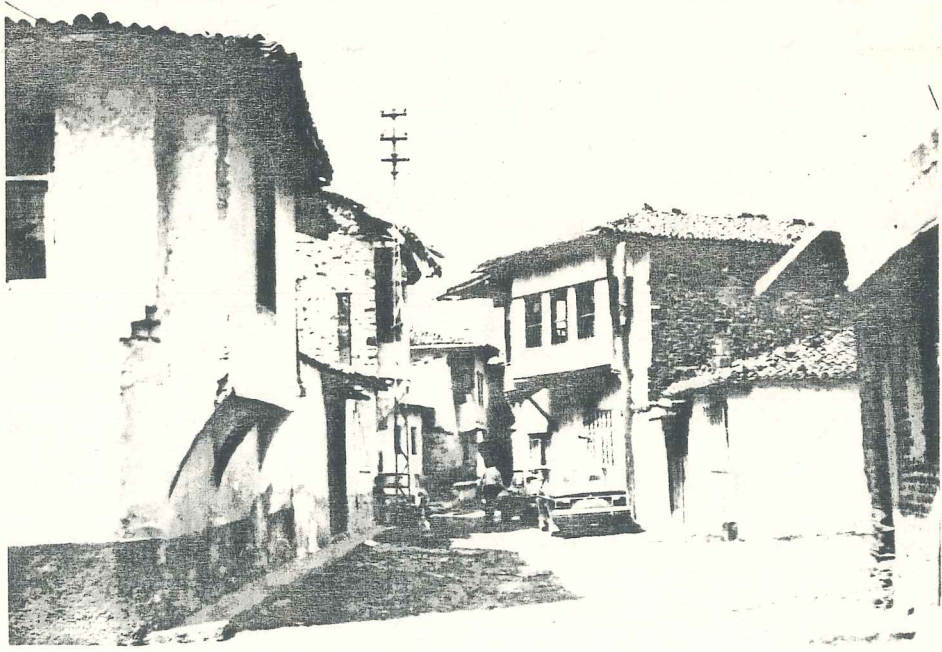
RESİM 77-Kızılkaya Mah. 97. sokak görünüşü.
