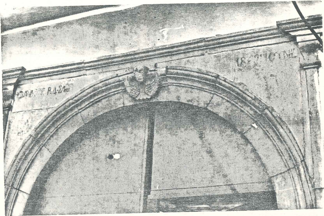
RESİM 53- 40.Sokak,27 nolu ev, mermer söveli giriş kapısı.
