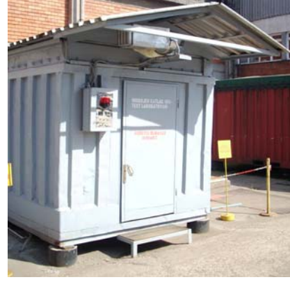
b. Havalandırma ve alarm ünitesi
