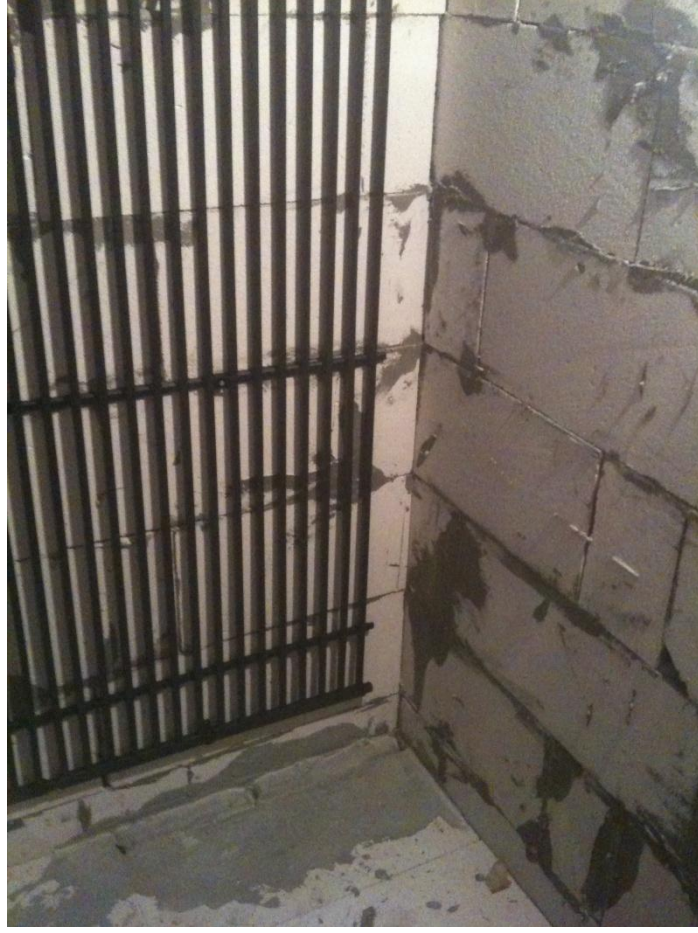
Şekil 4. 8 Isıtma/soğutma panellerinin duvarlara monte edilme aşaması
