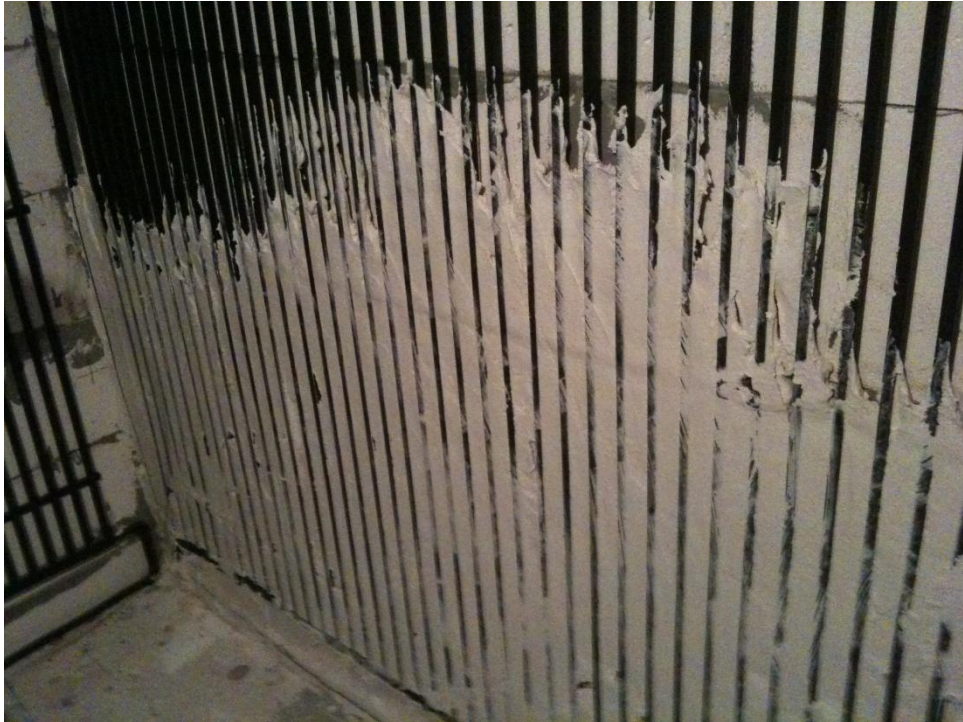
Şekil 4. 9 Panellerin üzeri alçı sıva ile kaplanma aşaması
