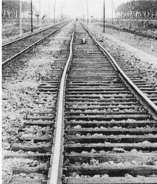
Şekil 1.6 Lokomotifin “kararlı olmayan Klingel hareketi” nden kaynaklanan ray deformasyonu (Knothe, 2008).
