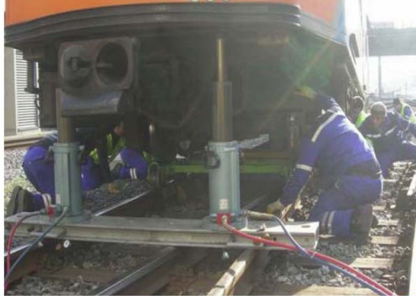
Şekil Ek 3.1 Hidrolik pompalarla araç kaldırılarak kurtarma arabaları tekerlek altlarına yerleştirilir (565 no'lu araçta aks kırılması raporu, 2007).
