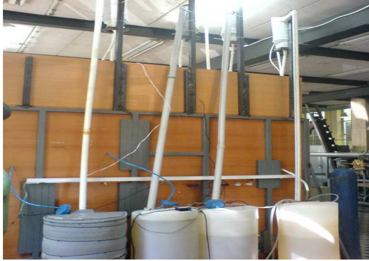
(b) Tesisatın arkasındaki su depoları
