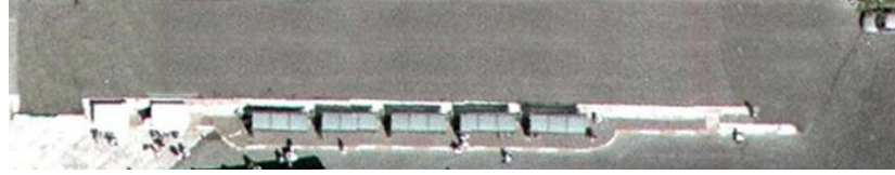
Şekil 4.49 Meydandaki yol ve kaldırım alanları
