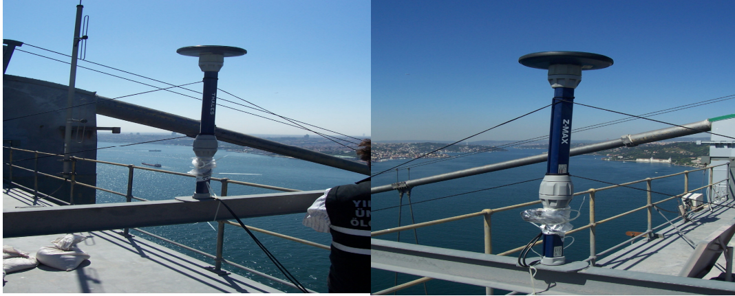
Şekil 5.5 Beylerbeyi kule B1 numaralı obje noktasındaki GPS ve modem anteni
