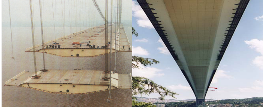
Şekil 2.4 Tabliyenin oluşturulması
