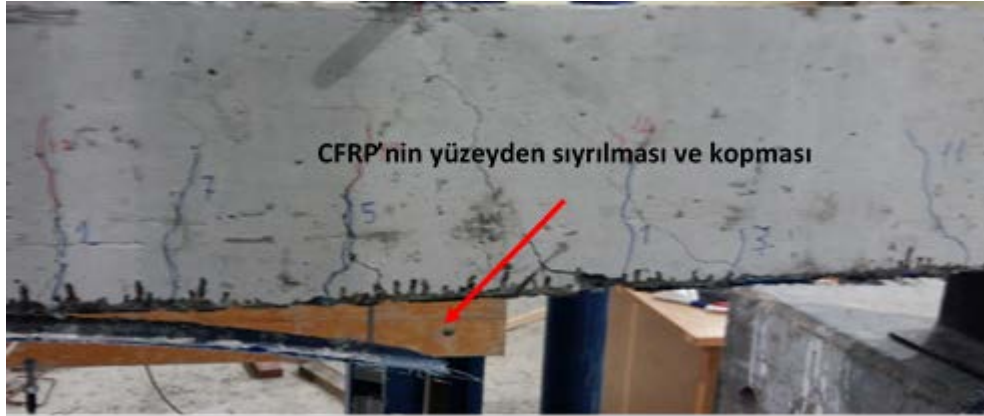
Şekil 4. 25 K20KG00 deney kirişinin göçme mekanizması
