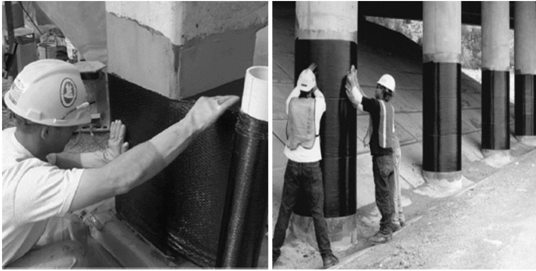
Şekil 3. 5 Kolonlarda FRP sargı uygulaması [54]
