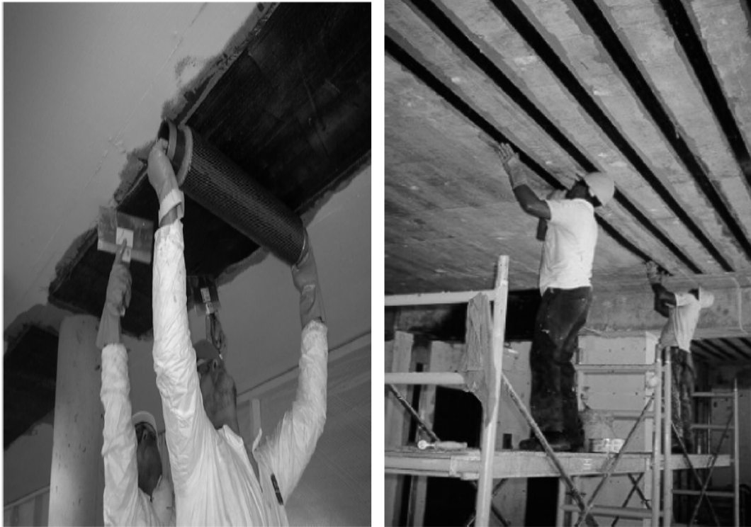
Şekil 3. 2 Döşemenin CFRP kumaş ile güçlendirilme uygulaması [54]
