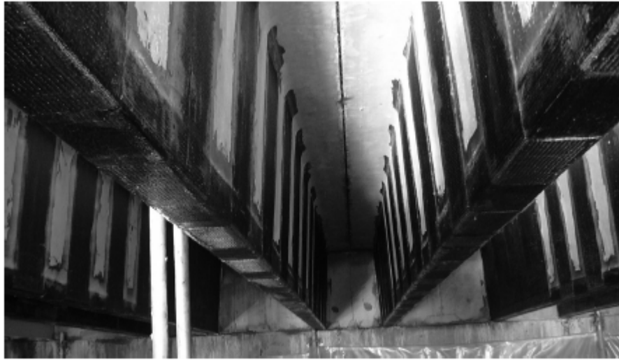
Şekil 3. 1 Betonarme kirişte eğilme (ve kesme) güçlendirmesi [54]
