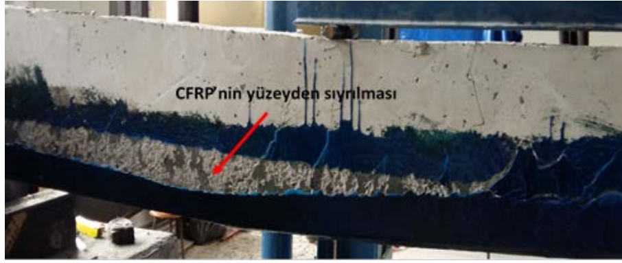
Şekil 4. 35 K40KG70 deney kirişinin göçme mekanizması
