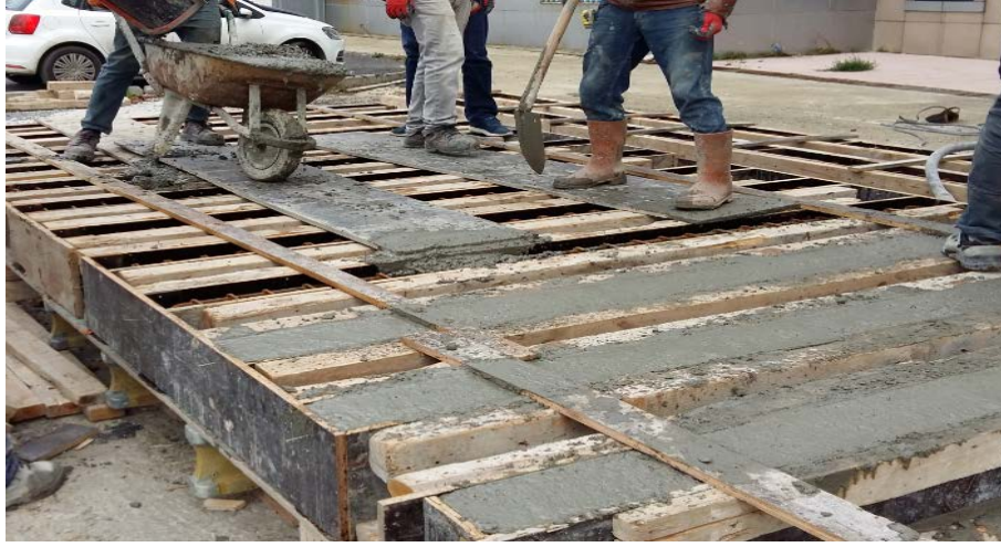
Şekil 4. 13 Kalıplara beton dökülmesi
