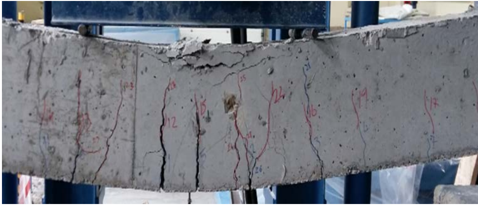
Şekil 4. 31 K40R deney kirişinin göçme mekanizması
