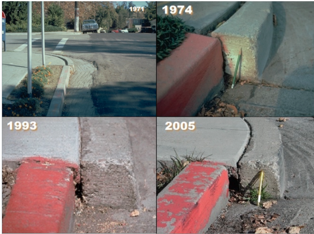
Şekil 2.6 Hayward fayında meydana gelen kripin kaldırım taşında oluşturduğu yerdeğiştirmenin izlenmesi [67]
