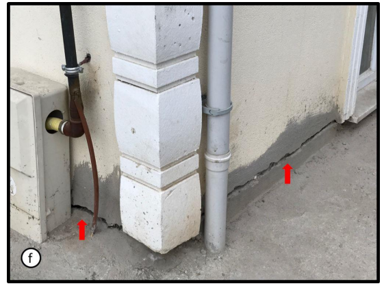
Şekil 4.1 Bolvadin’de gözlemlenen yüzey deformasyonları ve bunların arazi, yol ve yapılara olan etkileri
