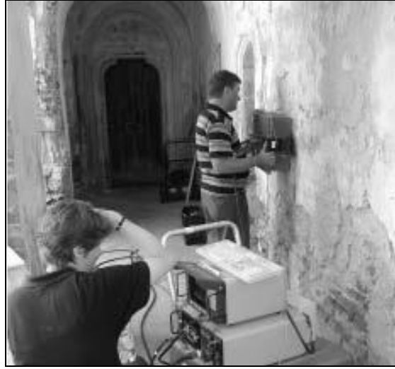
Şekil 5.1 Duvar üzerinde radar uygulaması (Diamanti vd., 2008)
