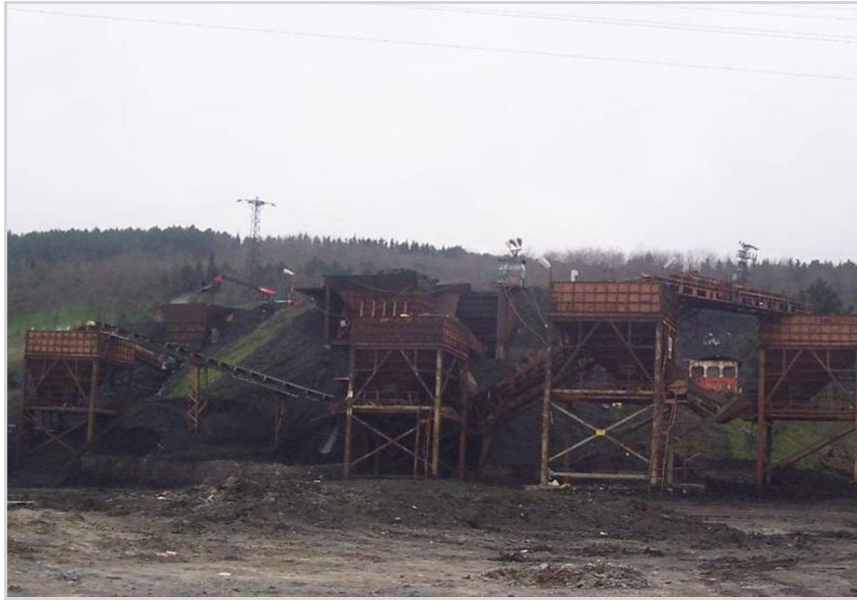
Şekil 4. 3 Milten Müteahhitlik yıkama tesisi
