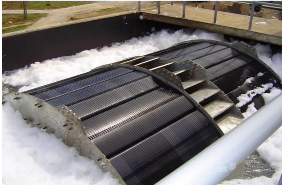
Şekil 4.11 Döner biyolojik reaktörler [50]
