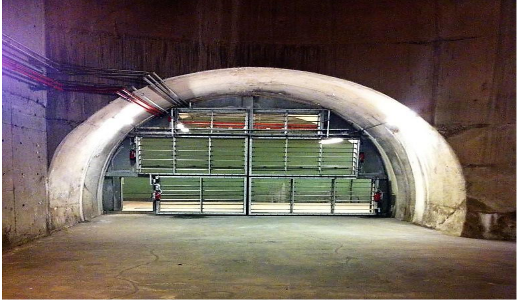
Şekil 2.2 Tünel havalandırma şaftı
