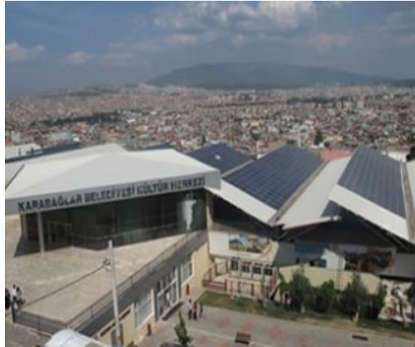
Şekil 3.17 İzmir Karabağlar Belediyesi Bozyaka Pazaryeri çatı üzeri panel yerleşimi
