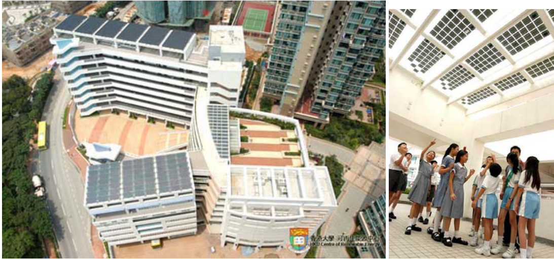
Şekil 3.11 Hong Kong'da PV panel çatı uygulaması yapılmış bir okul binası
