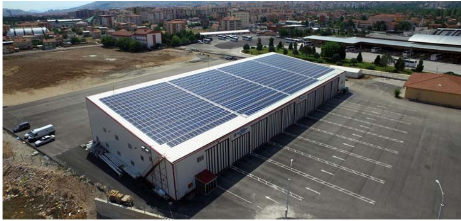
Şekil 3.26 Malatya B.Belediyesi Trambüs Bakım İstasyonu GES
