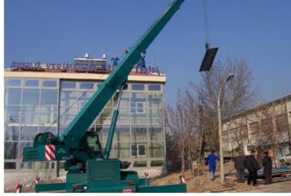
Şekil 3.13 YEGM parkı tesis binası fotovoltaik panel montajı
