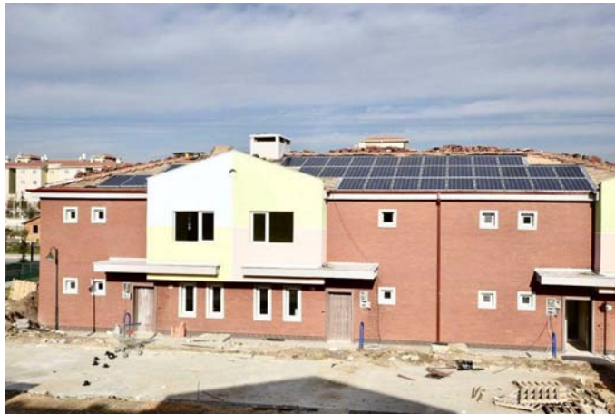
Şekil 3.23 Tepebaşı Belediyesi, çatı entegre uygulaması
