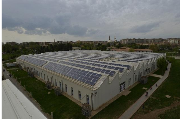
Şekil 3.15 Sümer Park çatı üzeri güneş paneli uygulaması
