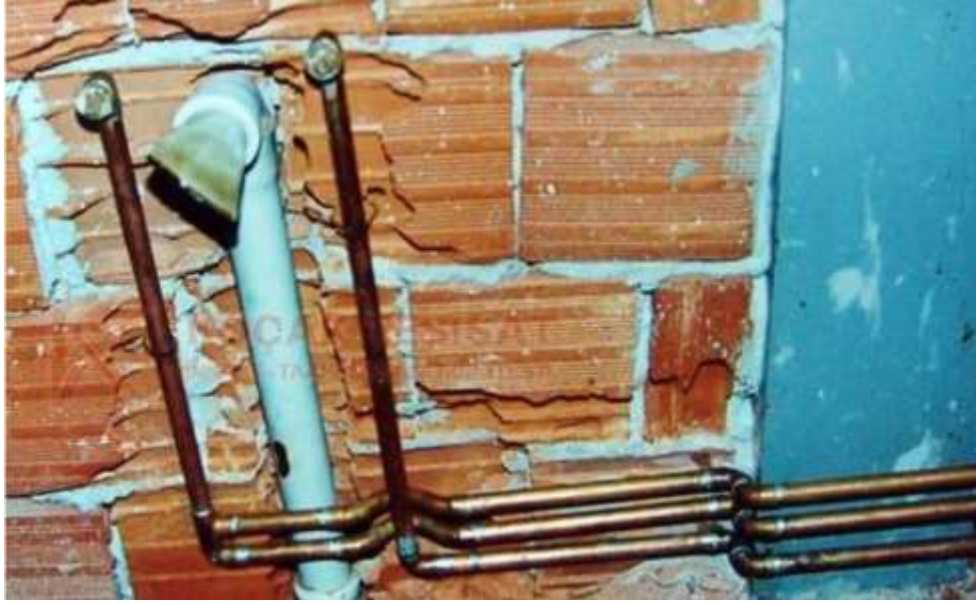
Şekil 2.2 Bakır boru ile ankastre temiz su tesisatı [10]
