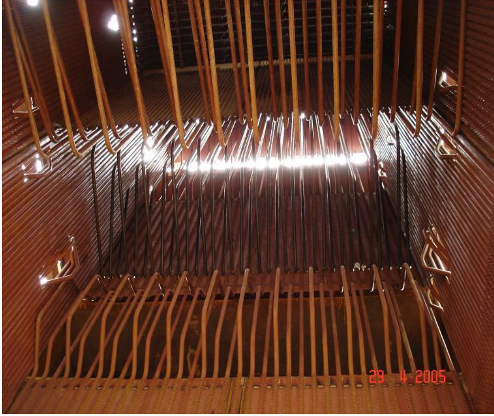
Şekil 5.3 Su borulu kazanların içten görünüşü [23]
