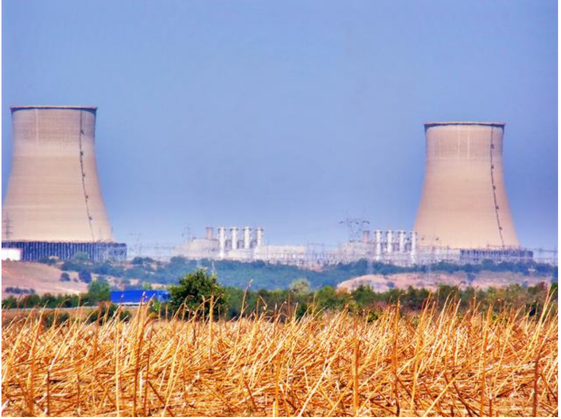
Şekil 8.6 Hamitabat soğutma kuleleri[22]
