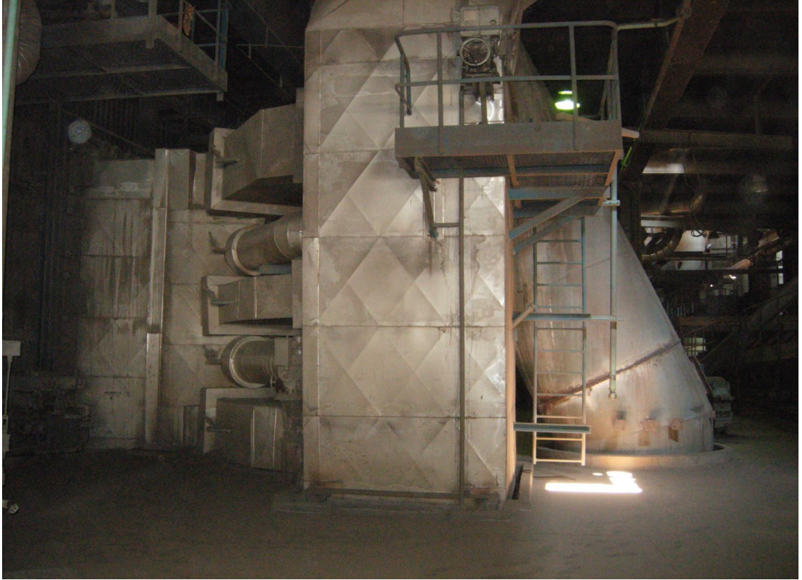
Şekil 5.18 Pülverize kömür sistemi [22]
