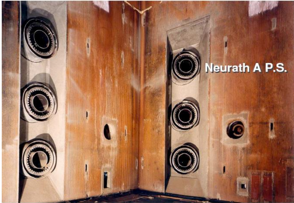
Şekil 5.4 Su borulu kazanlardaki yakıcı ağızlar [23]
