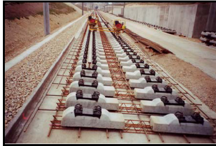
Şekil 2. 5 Beton içine gömülü tip balastsız üstyapı [8]
