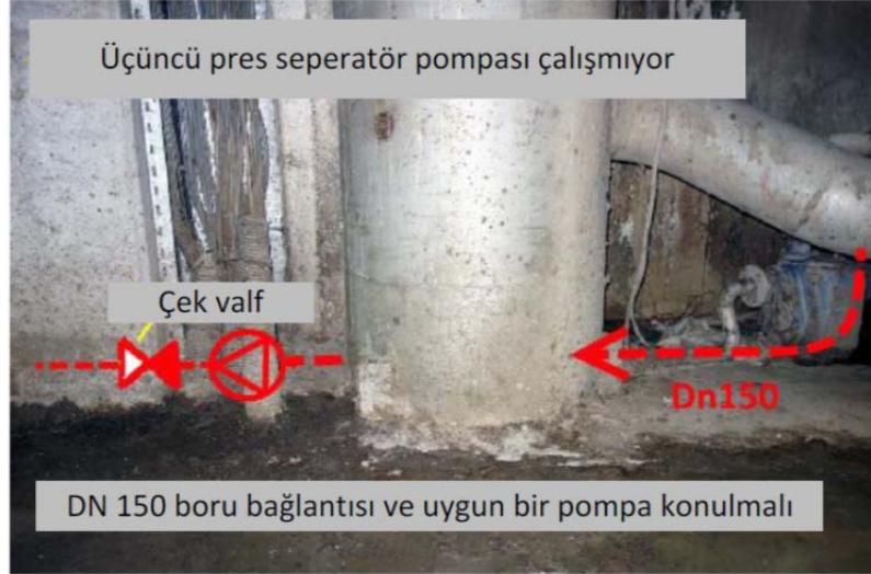
Şekil 6. 31 Vakum seperatörü dizayn hatası
