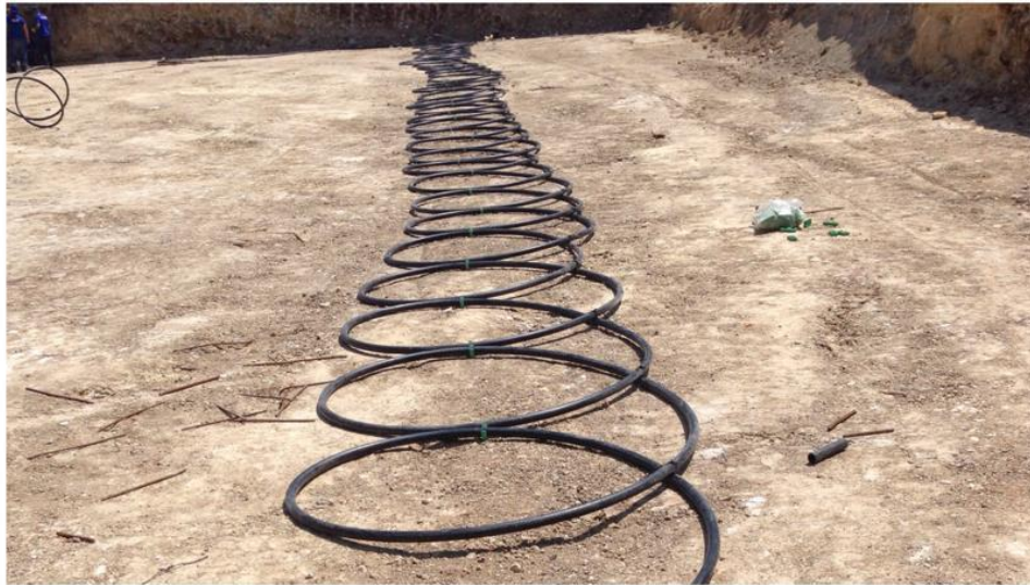
Şekil 2.11 Slinky Tip Isı Değiştirici Örneği
